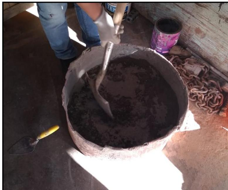
**Fotografía N° 16:** Incorporación de agua en la mezcla, se mezcló hasta observar homogeneidad Fuente: elaboración propia.
