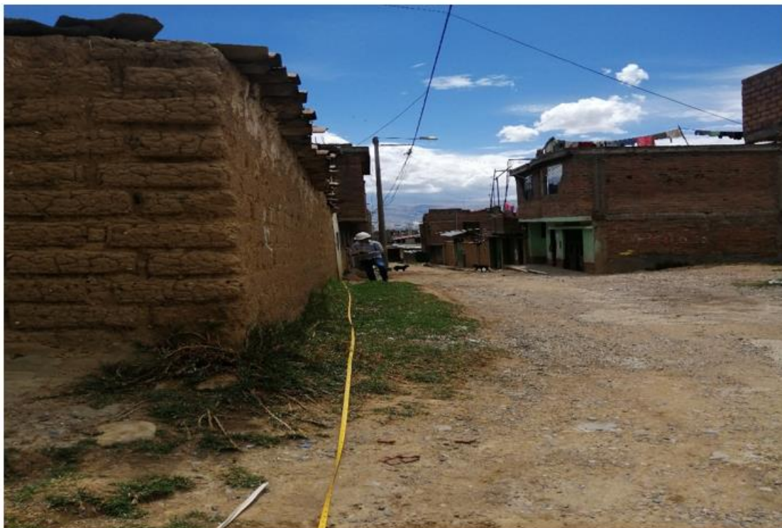
Fotografía 05: Medición y reconocimiento de material utilizado en la construcción de las viviendas – Asociación los Libertadores – Huancayo Fuente: Propia.
