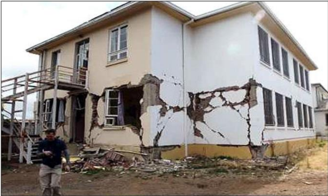
Figura 4. Efecto de irregularidad en planta. Fuente: Medina & Pimichumo (2018).
