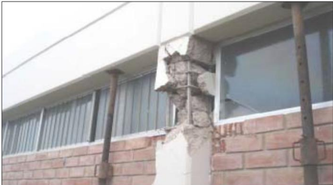
Figura 3. Efecto de columna corta. Fuente: Medina & Pimichumo (2018).
