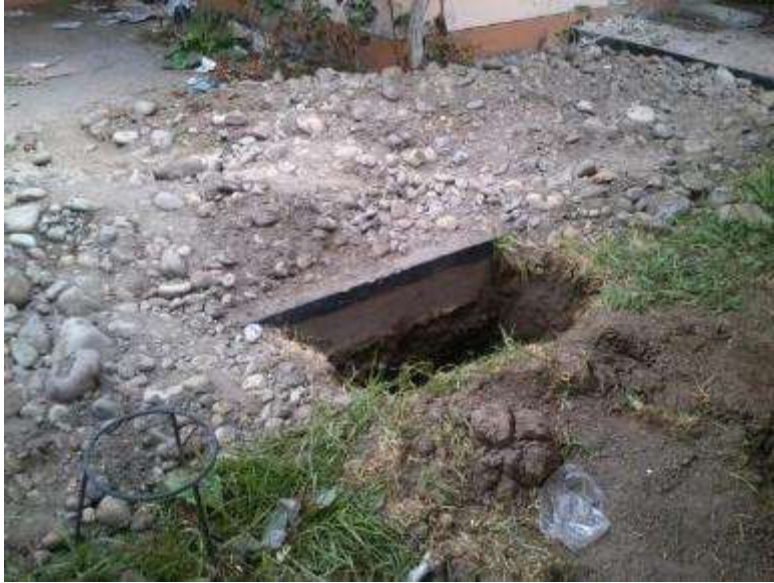
Vista exterior de calicata C-1
