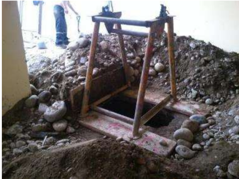
Vista exterior de calicata C-2
