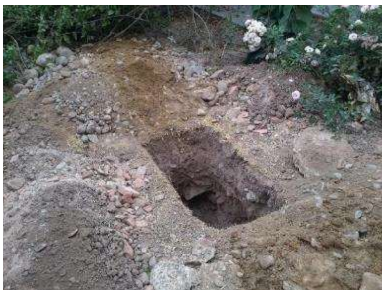
Vista exterior de calicata C-3
