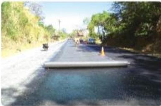
Se ha empleado la siguiente estructura de costos en una vía típica urbana para contemplar la utilización del geotextil en repavimentación, visualizando sus beneficios a largo plazo. Los costos totales se han realizado calculando cantidades por km. de vía, trabajando con un ancho promedio de carril de 3.5m.
