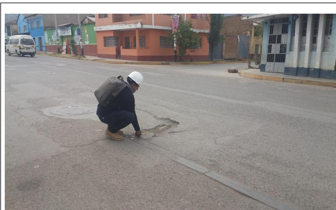
**IMAGEN N° 08. Se observa la falla de bache con un nivel de severidad alto. Además el parche con un nivel de severidad media.**
