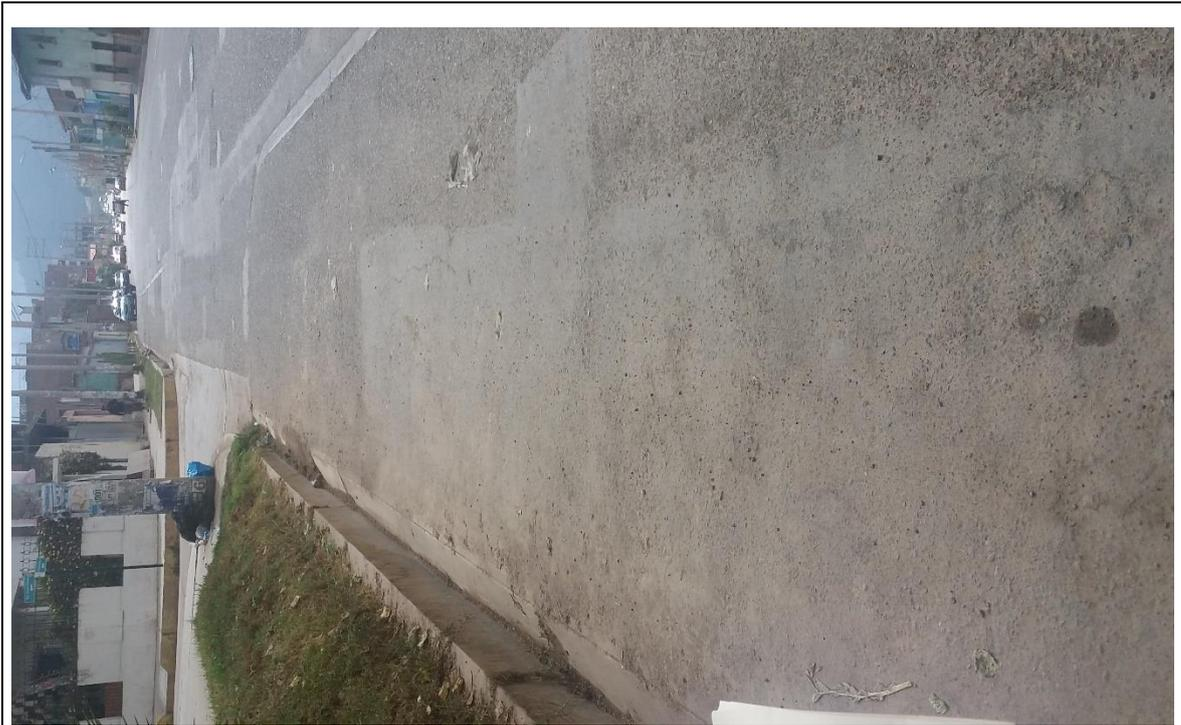
**IMAGEN N° 03. Se observa peladura y desprendimiento con un nivel de severidad media**
