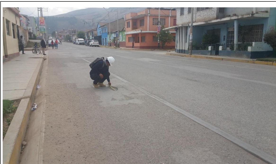
**IMAGEN N° 07. Se observa la falla de bache con un nivel de severidad alto, además el parche con un nivel de severidad media.**
