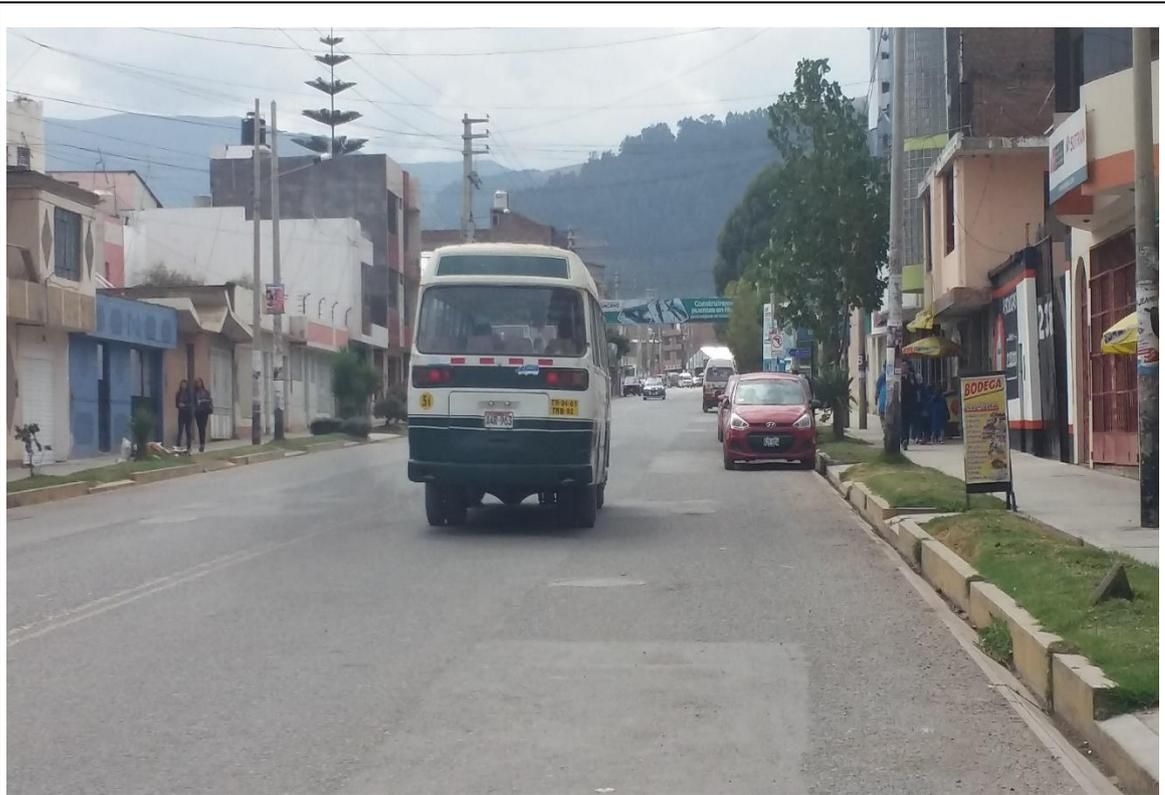
**IMAGEN N° 15.** Se observa la falla de peladura y desprendimiento con un nivel de severidad medio. Además de la falla de parcheo con un nivel de severidad medio.
