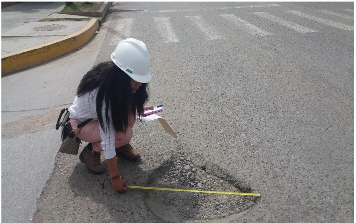
**IMAGEN N° 04. Se observa la falla de bache con un nivel de severidad alto.**
