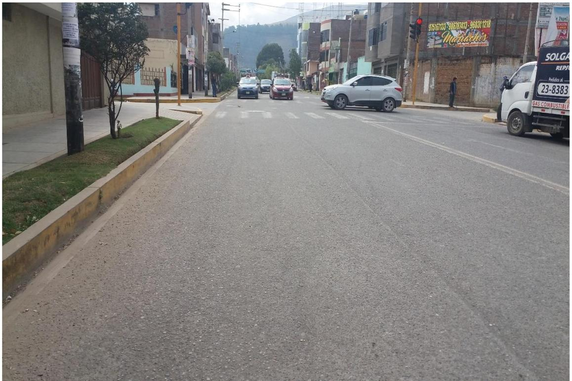
**IMAGEN N° 16.** Se observa la peladura y desprendimiento de finos con un nivel de severidad medio. Además de la falla de parcheo con un nivel de severidad medio.
