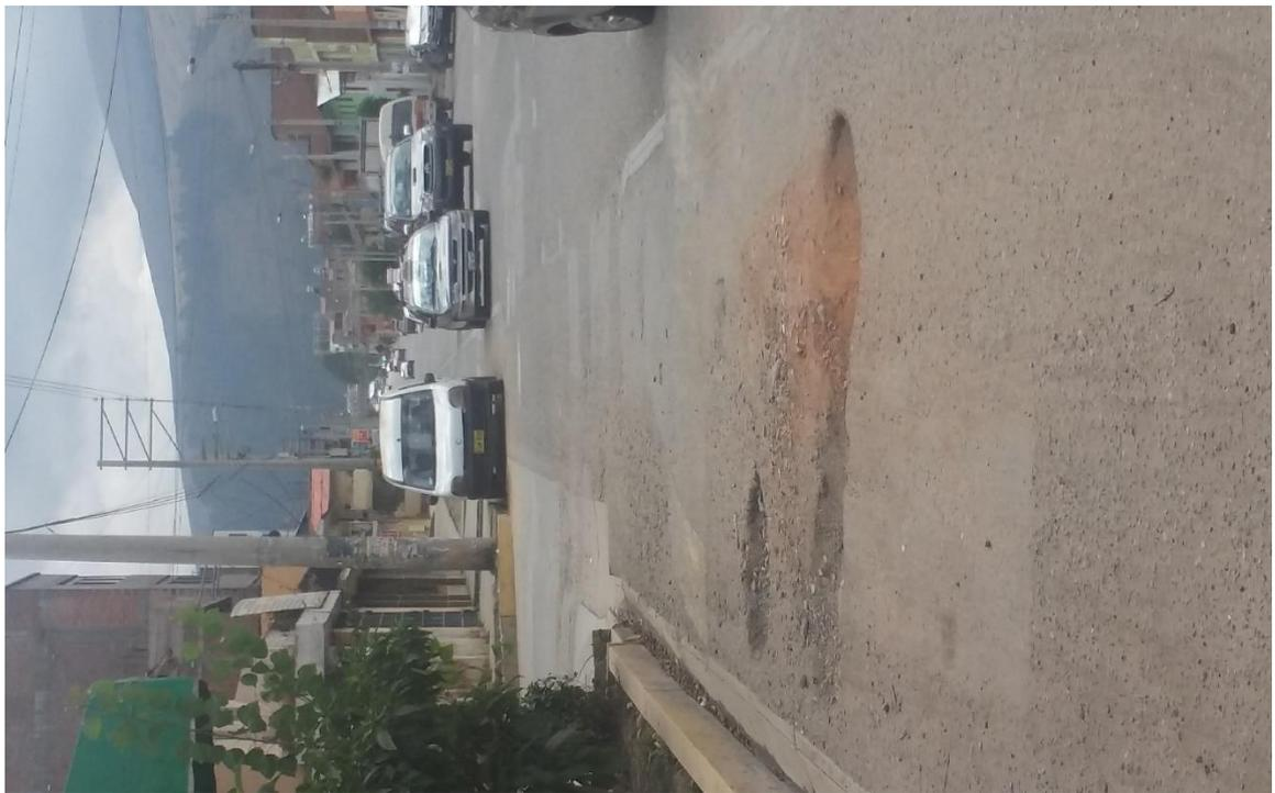
**IMAGEN N° 06. Se observa la falla de bache con un nivel de severidad alto.**
