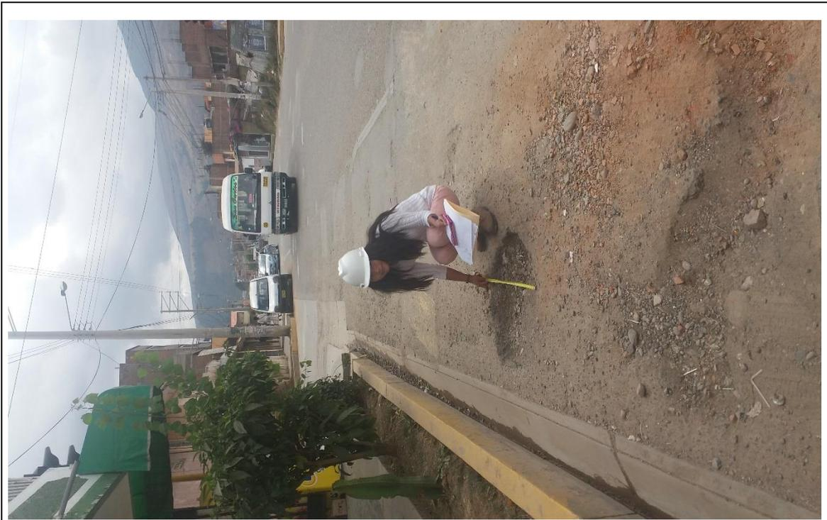
**IMAGEN N° 05. Se observa la falla de bache con un nivel de severidad alto.**
