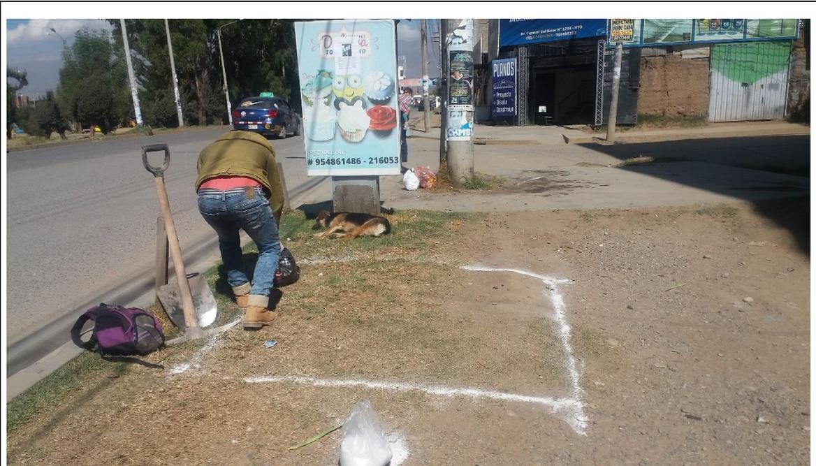
IMAGEN N° 22. Se observa el traza para la excavación de la calicata. En el tramo del estudio.
