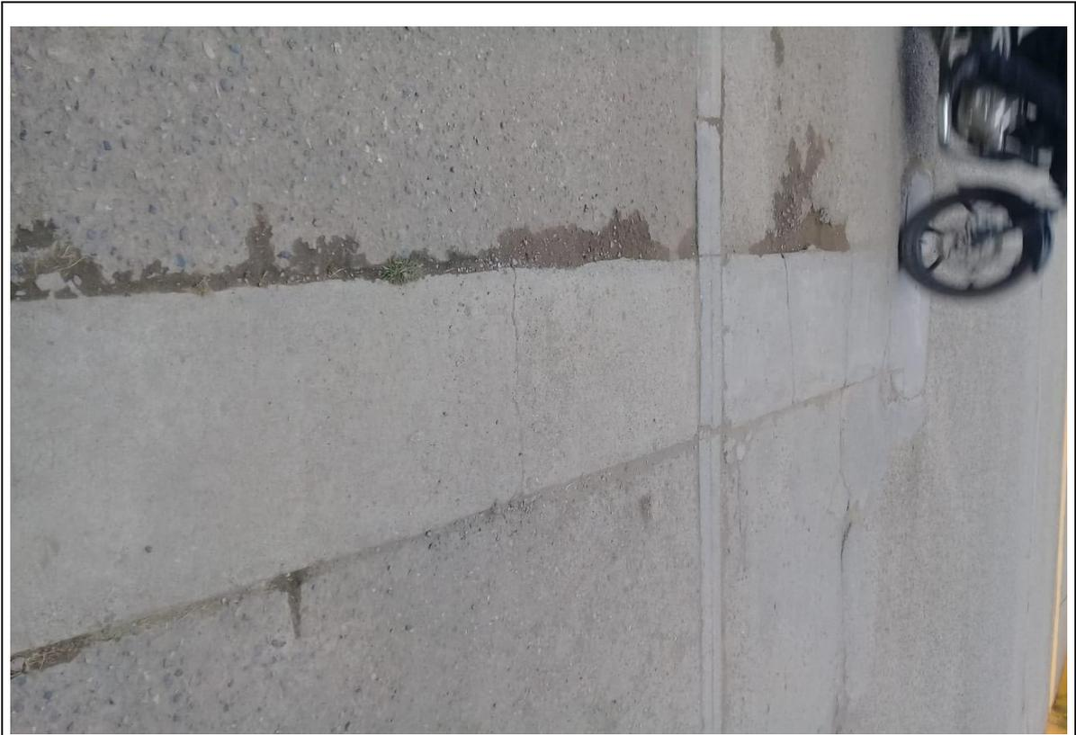
**IMAGEN N° 11.** Se observa la falla de peladura y desprendimiento con un nivel de severidad medio. además el parche con un nivel de severidad media.
