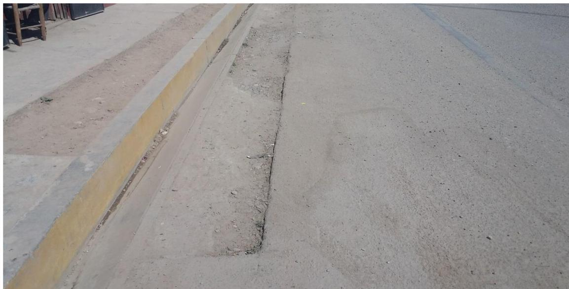
**IMAGEN N° 01.** Se observa la falla de ahuellamiento y baches con un nivel de severidad alto.
