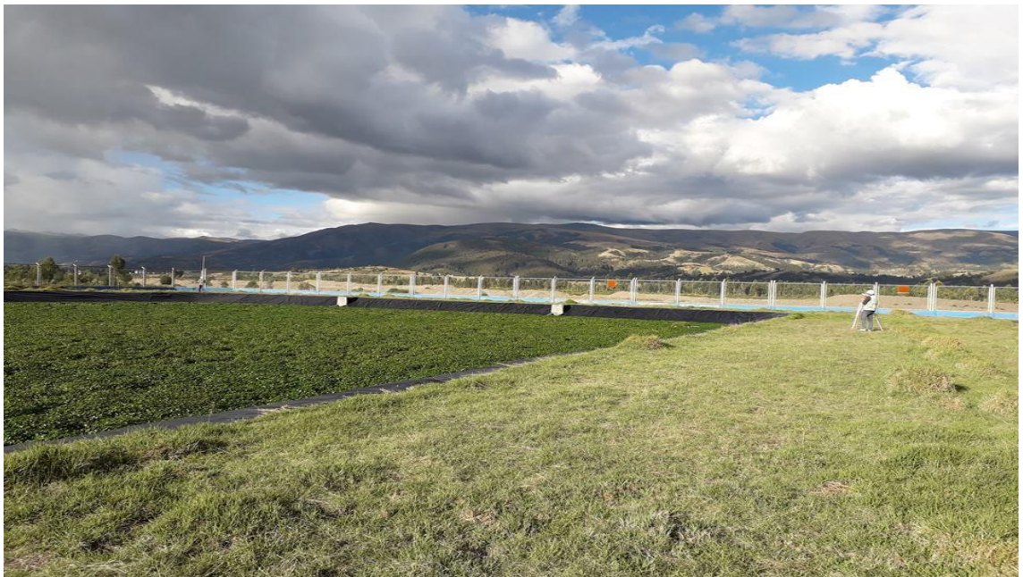
IMAGEN N.08: Replanteo de la laguna de oxidación de Sicaya.
