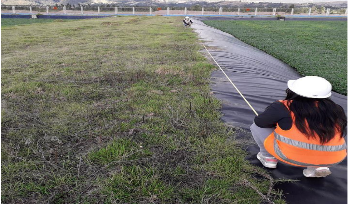
IMAGEN N.09: Replanteo de la laguna de oxidación de Sicaya.
