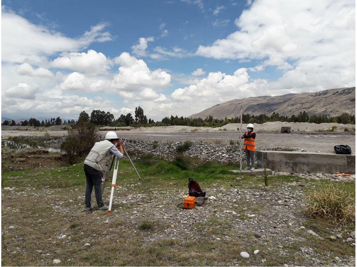
IMAGEN N.07: Replanteo de la laguna de oxidación de Sausa.
