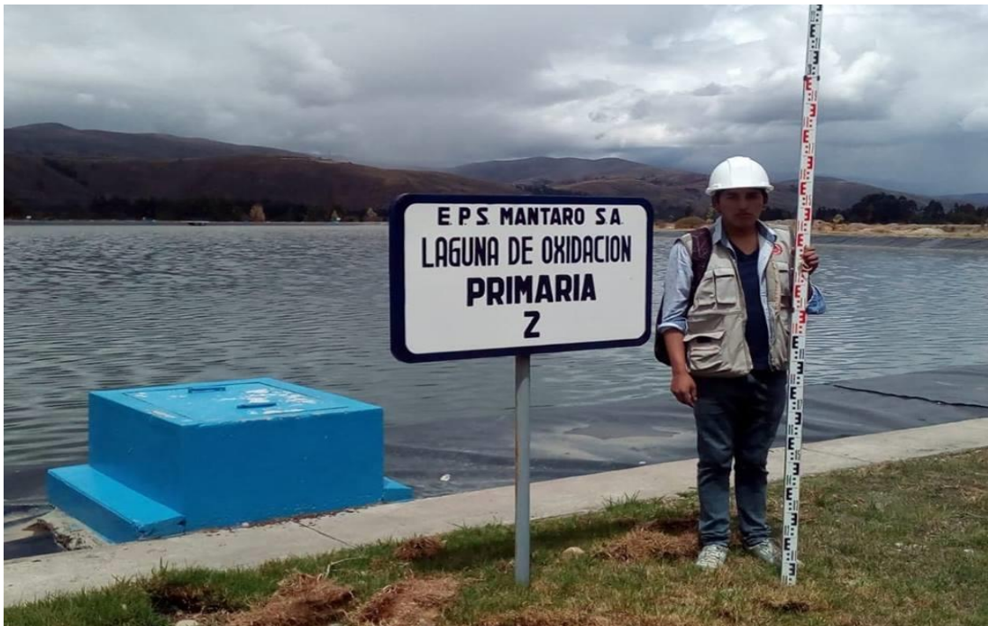
IMAGEN N.06: Replanteo de la laguna de oxidación de Sausa.
