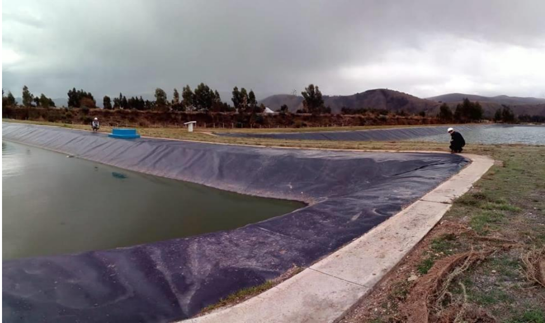
IMAGEN N.05: Replanteo de la laguna de oxidación de Sausa.
