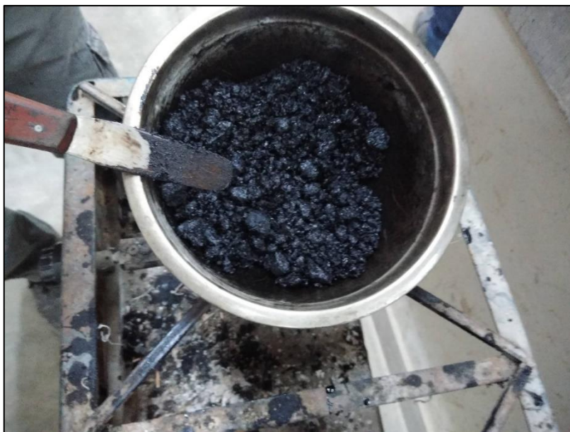
Fotografía 30: Mezclado de los agregados y asfalto
