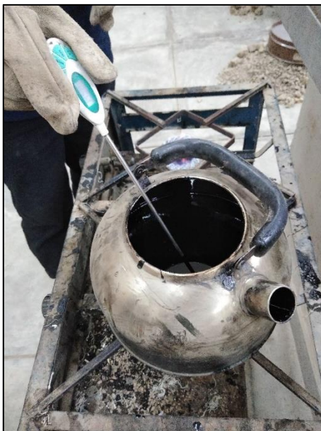
Fotografía 26: Calentado del cemento asfáltico
