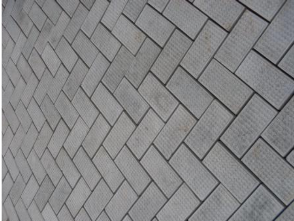
Figura 4: Ensamblaje de adoquines tipo “espina de pescado” Fuente: Ministerio de Transportes y Comunicaciones
