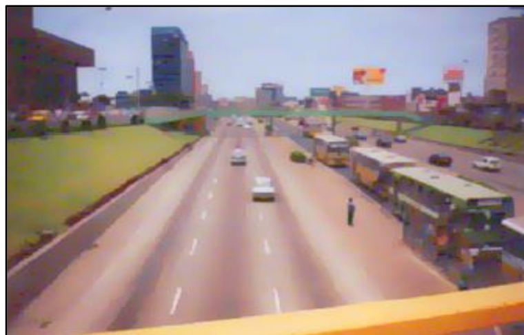
Figura 11: Condiciones de operación de los niveles de servicio, Nivel de Servicio A.
