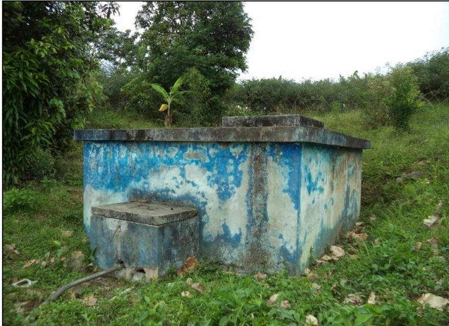
**Ilustración 4** Reservorio existente de 15m<sup>3</sup>
