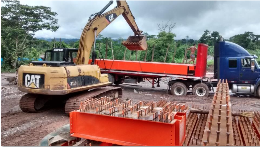
Fotografía. 27: Almacenaje de los elementos estructurales en obra.
