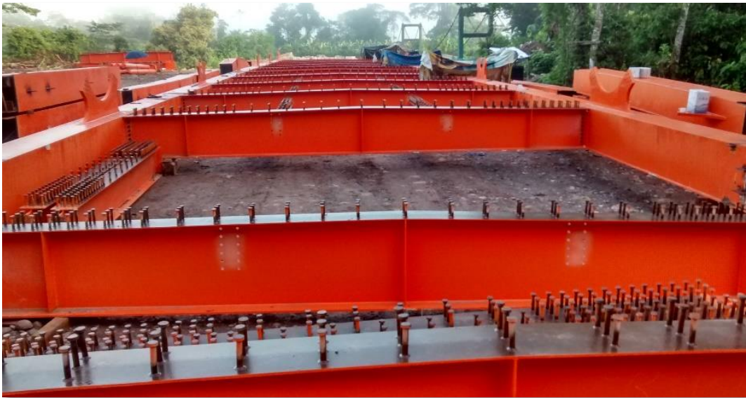
Fotografía. 30: Ensamblaje de la superestructura.
