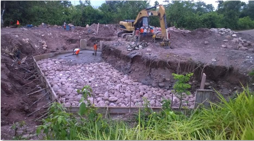
Fotografía. 10: Concreto en falsa zapata
