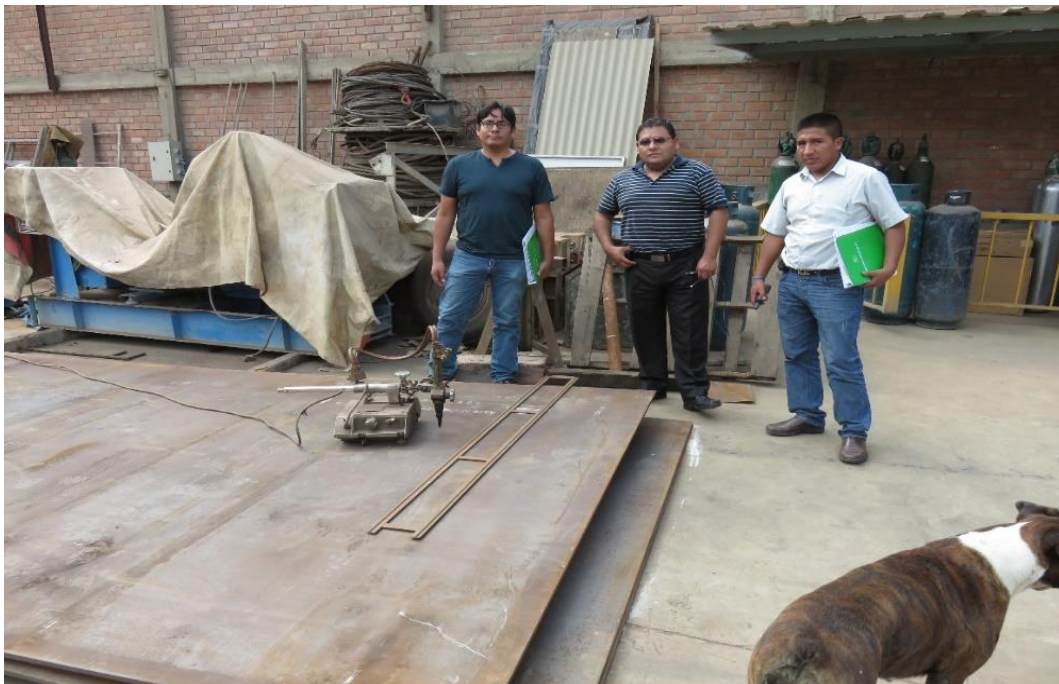
Fotografía. 20: Verificando el acero en taller.
