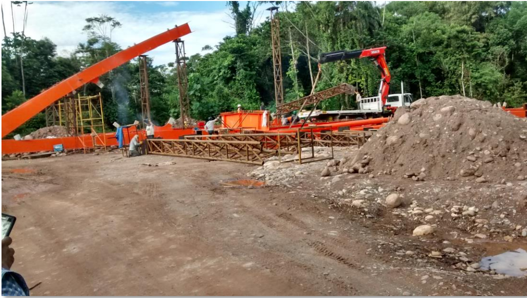
Fotografía. 33: Ensamblaje de la superestructura.
