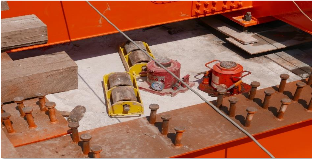
Fotografía. 37: Lanzamiento de la superestructura.
