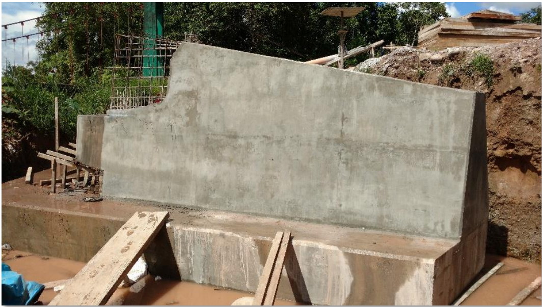
Fotografía. 17: Concreto en estribos.
