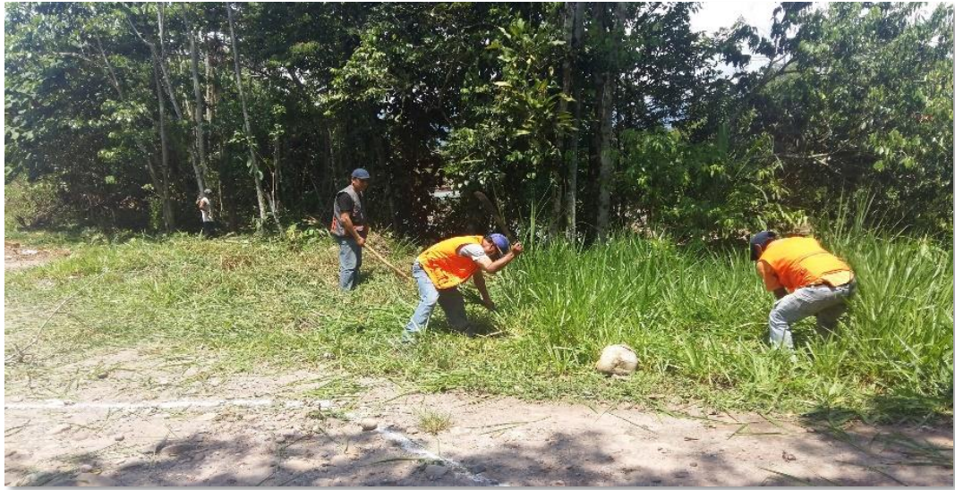
Fotografía. 06: Limpieza de terreno.
