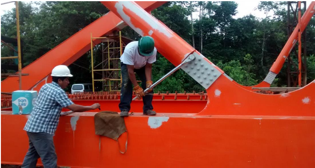
Fotografía. 36: Torque a los pernos de la superestructura.
