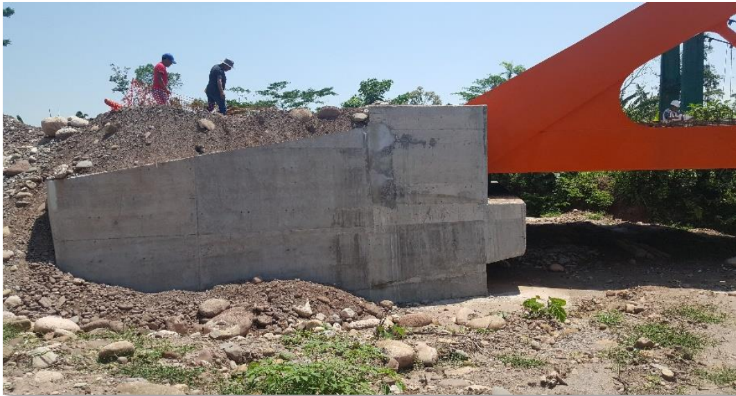
Fotografía. 19: Estribos cargado con la superestructura.
