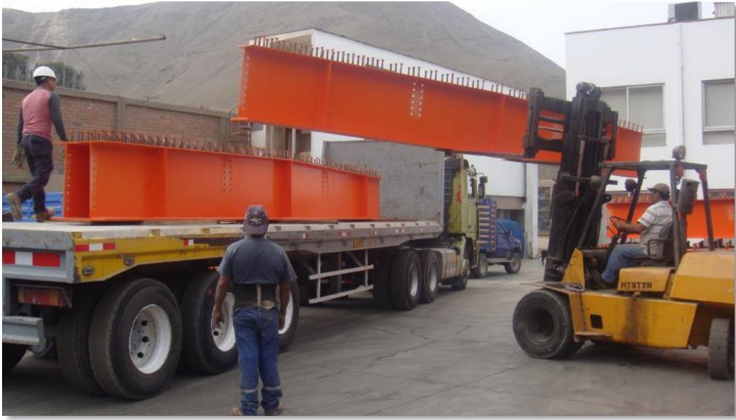
Fotografía. 25: Transporte de los elementos estructurales.
