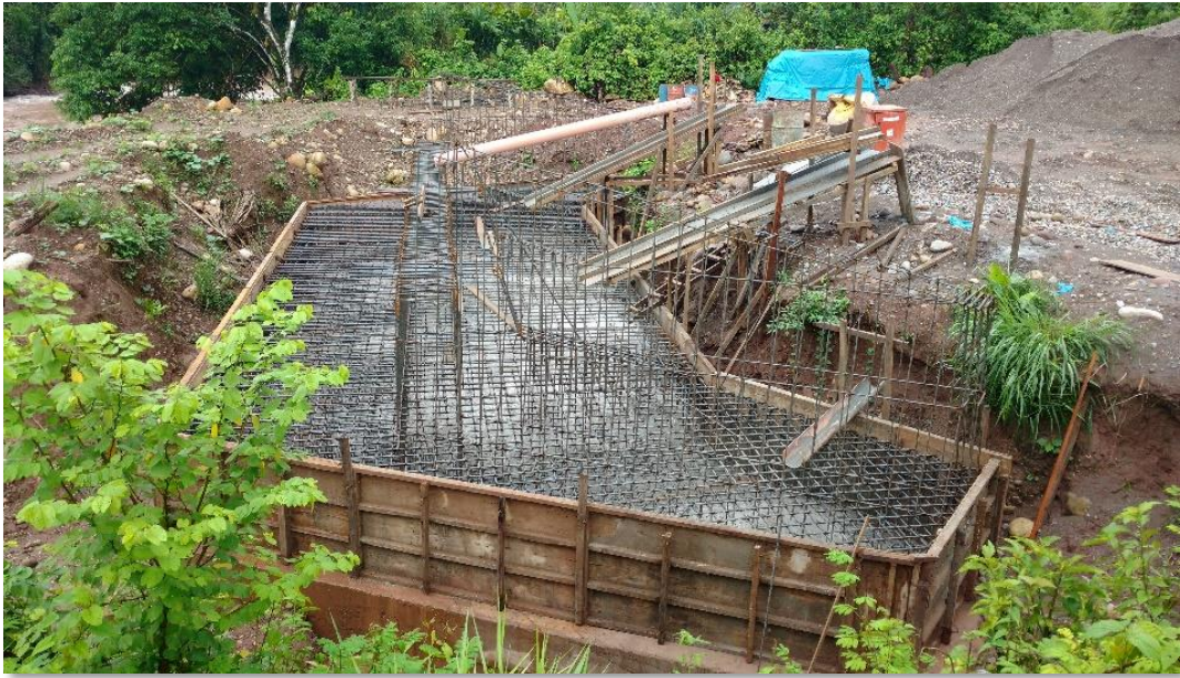
Fotografía. 14: Habilitación de acero para la pantalla de los estribos.
