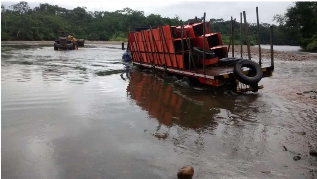
Fotografía. 26: Transporte de los elementos estructurales.
