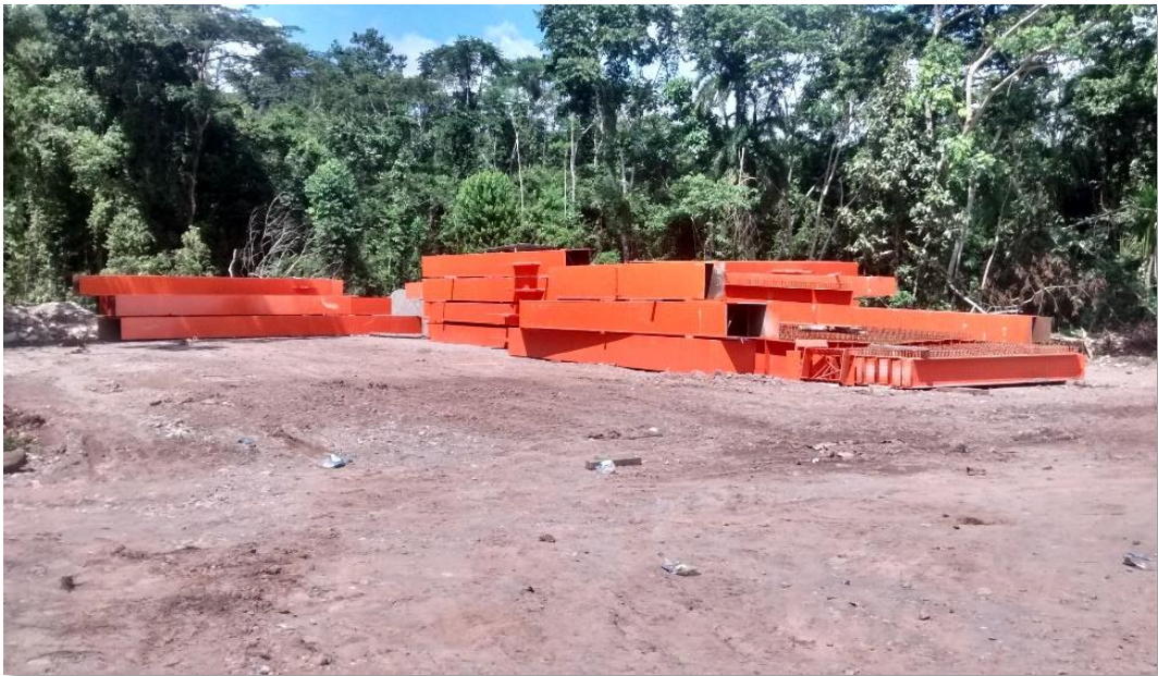
Fotografía. 28: Almacenaje de los elementos estructurales en obra.
