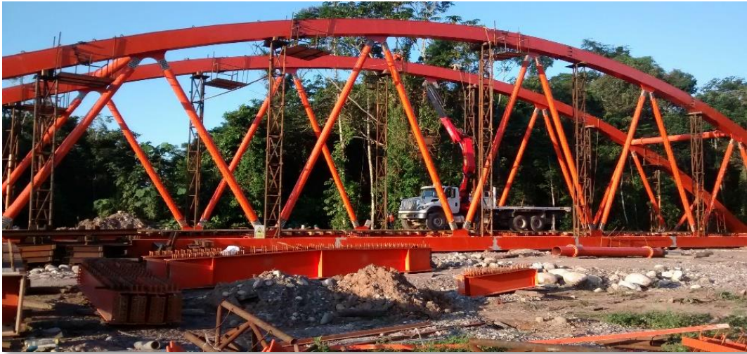
Fotografía. 35: Ensamblaje de la superestructura.
