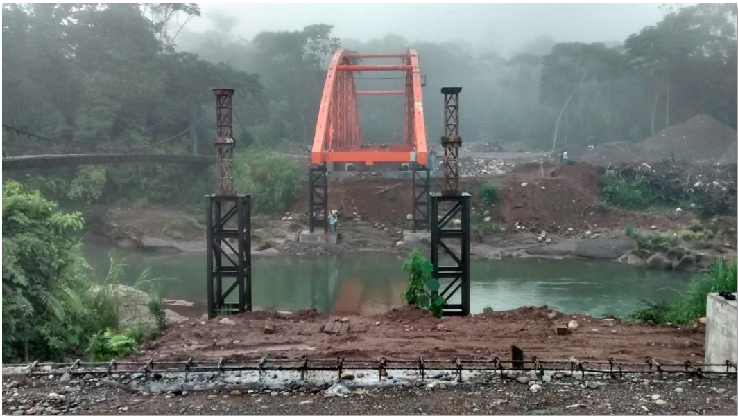
Fotografía. 40: Lanzamiento de la superestructura.
