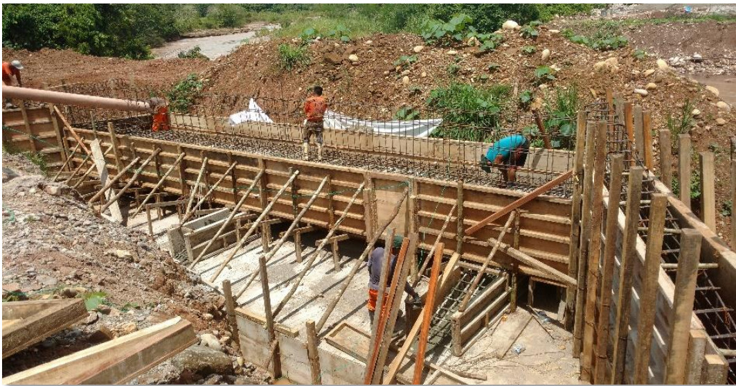
Fotografía. 15: Encofrado de la pantalla de los estribos.
