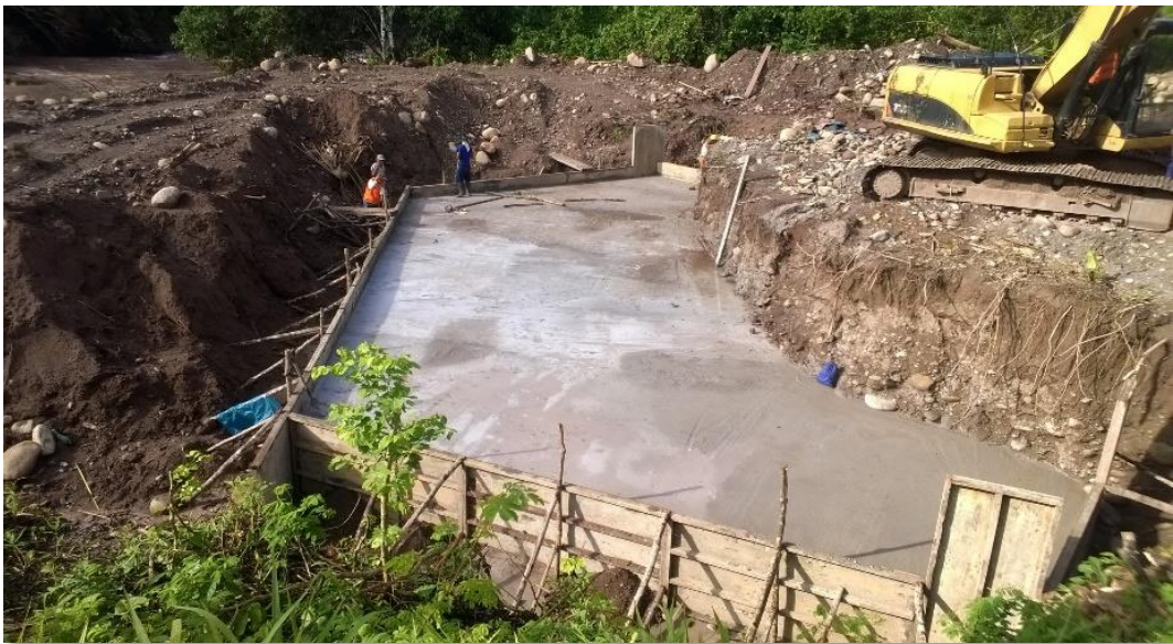
Fotografía. 11: Concreto Falsa zapata
