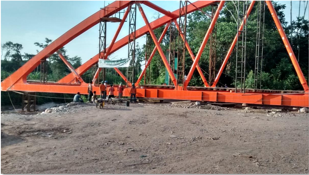
Fotografía. 39: Lanzamiento de la superestructura.
