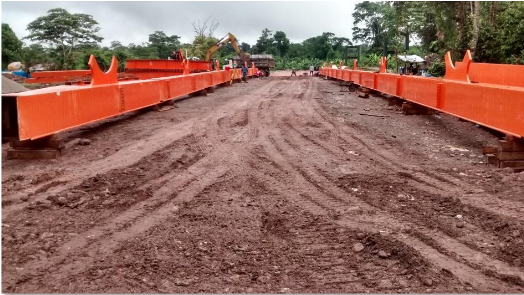
Fotografía. 29: Ensamblaje de la superestructura.
