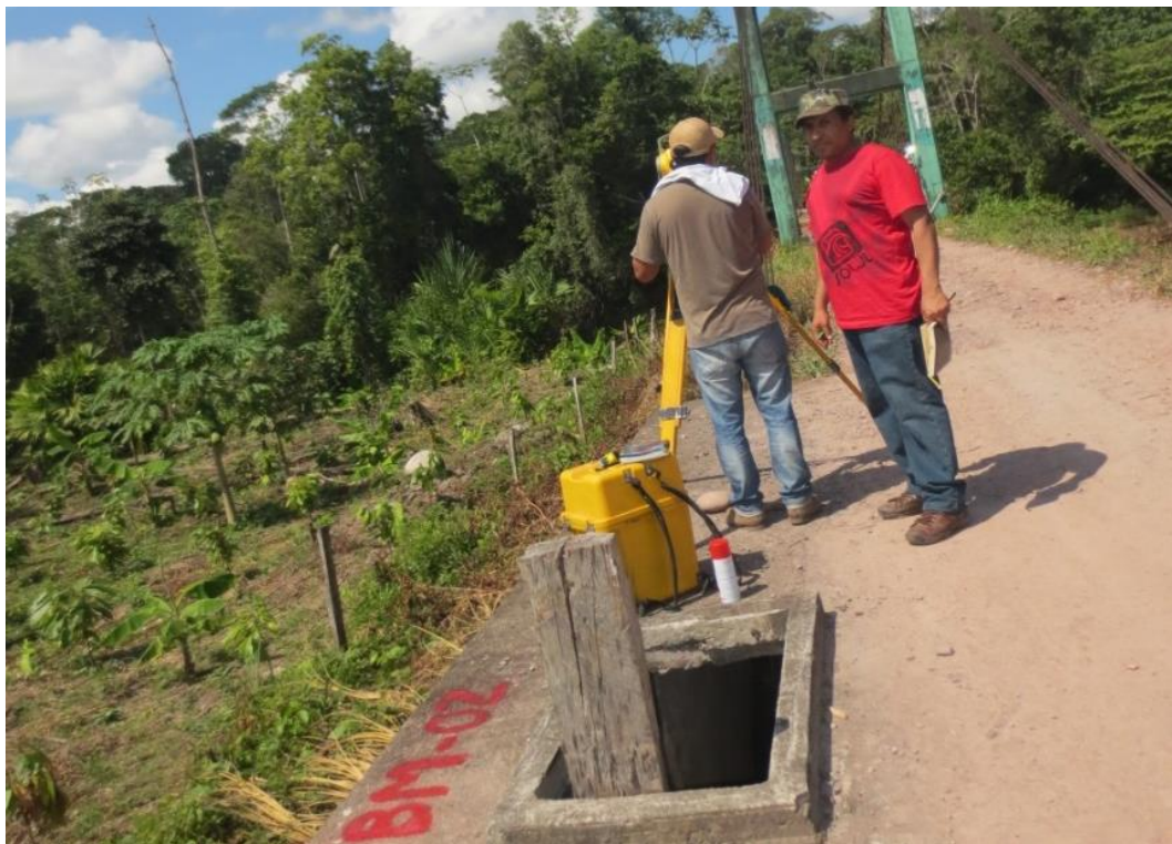
Fotografía.02 Vista del Puente existente en el Rio Lagarto.
