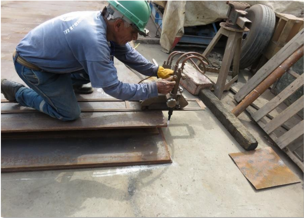
Fotografía. 21: Trabajos de corte de acero.
