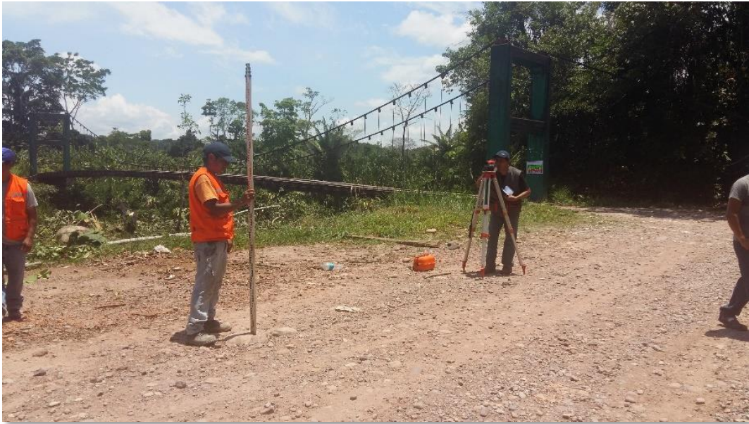
Fotografía. 08: Trazo y replanteo
