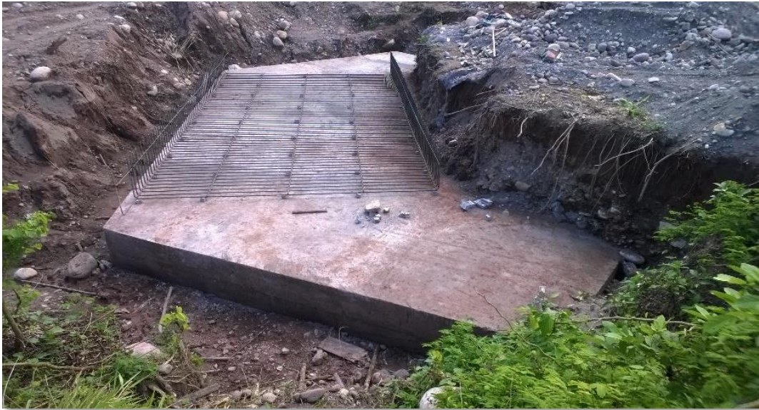
Fotografía. 12: Habilitación de acero para la zapata de los estribos
