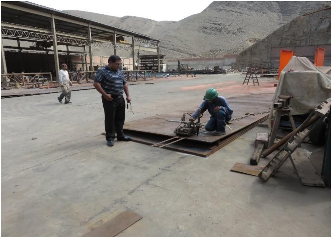
Fotografía. 22: Trabajos de corte de acero.
