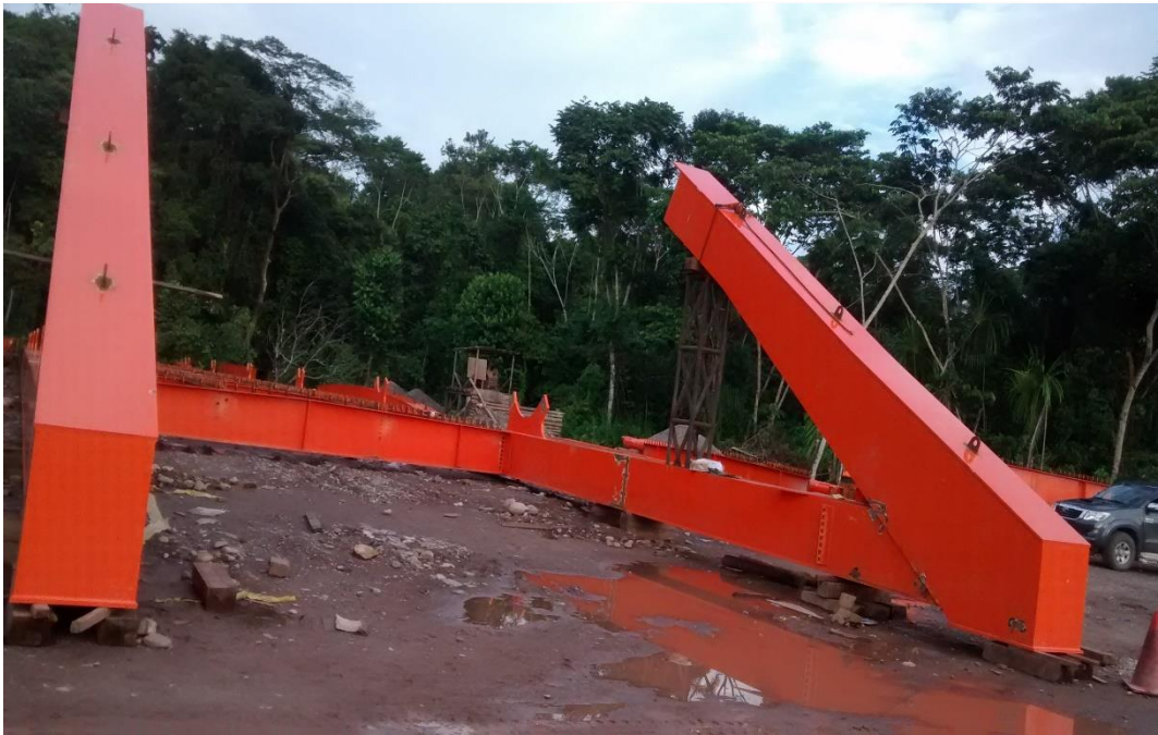
Fotografía. 32: Ensamblaje de la superestructura.
