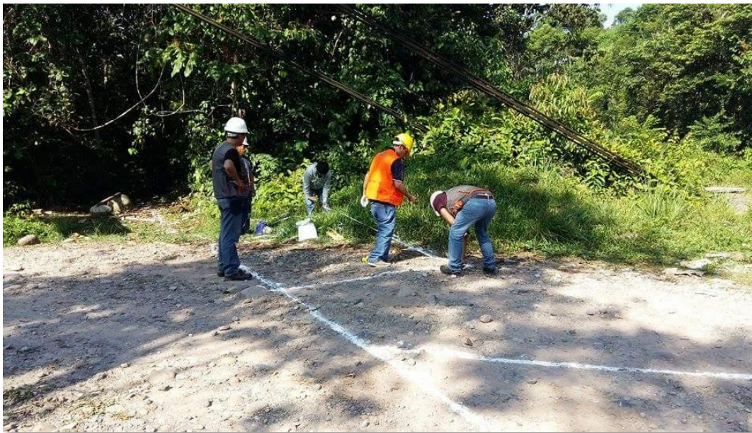
Fotografía. 07: Trazo y replanteo preliminar.
