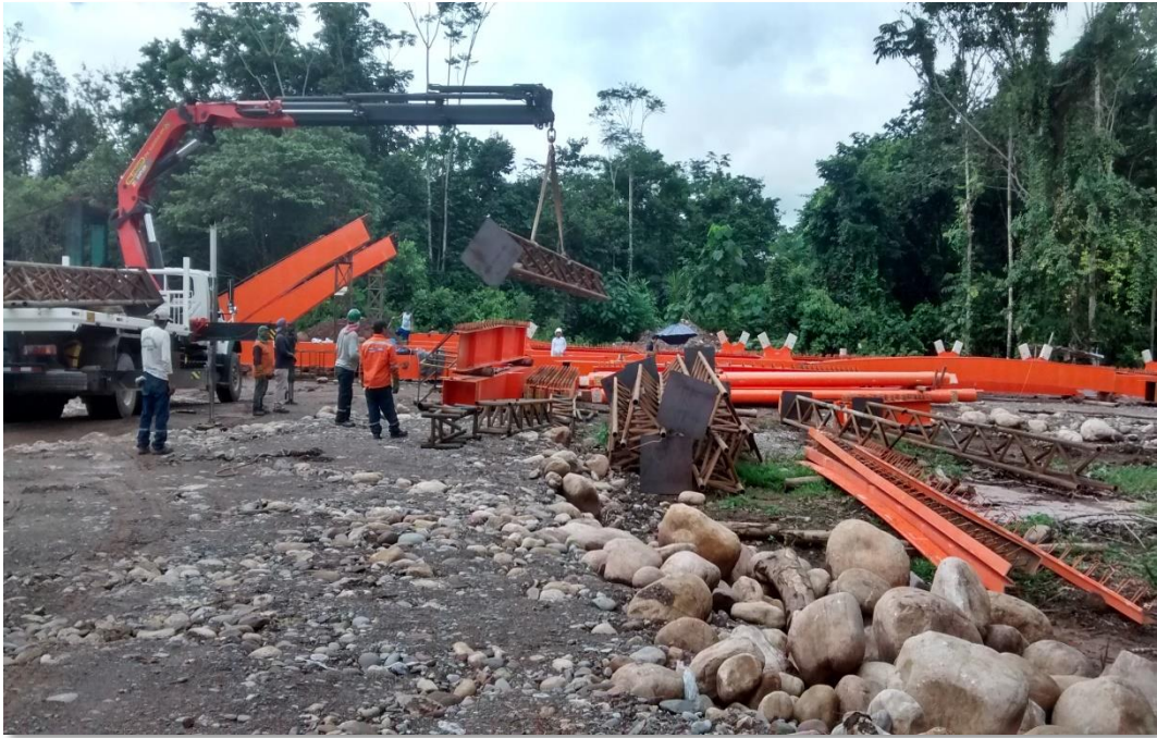
Fotografía. 31: Ensamblaje de la superestructura.
