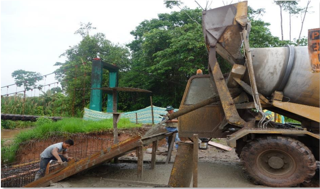
Fotografía. 16: Concreto en estribos.
