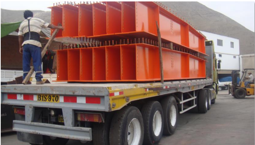
Fotografía. 24: Transporte de los elementos estructurales.
