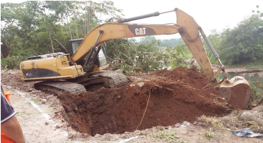
Fotografía. 09: Trabajos de excavación.
