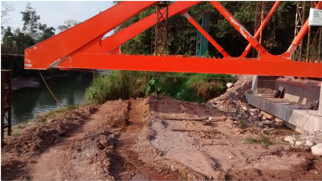
Fotografía. 38: Lanzamiento de la superestructura.
