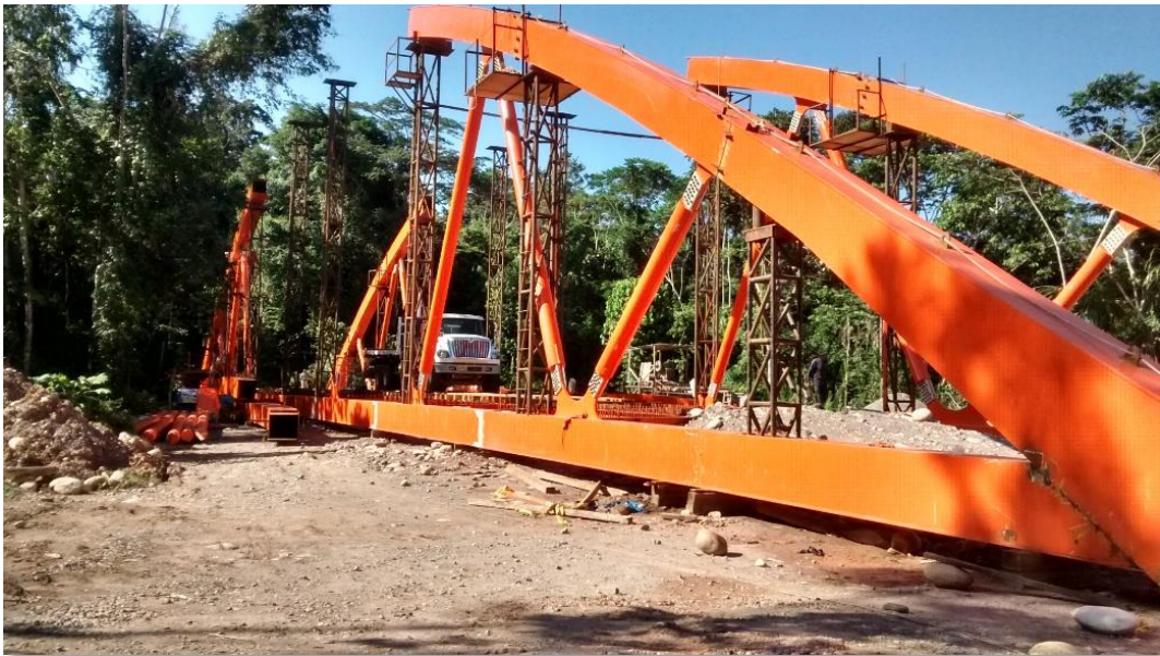
Fotografía. 34: Ensamblaje de la superestructura.
