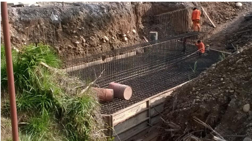
Fotografía. 13: Encofrado de la zapata de los estribos
