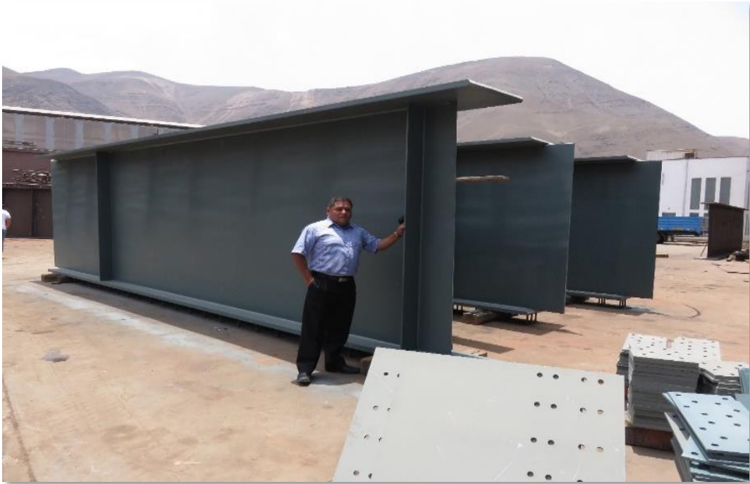
Fotografía. 23: Armado de vigas metálicas estructurales.
