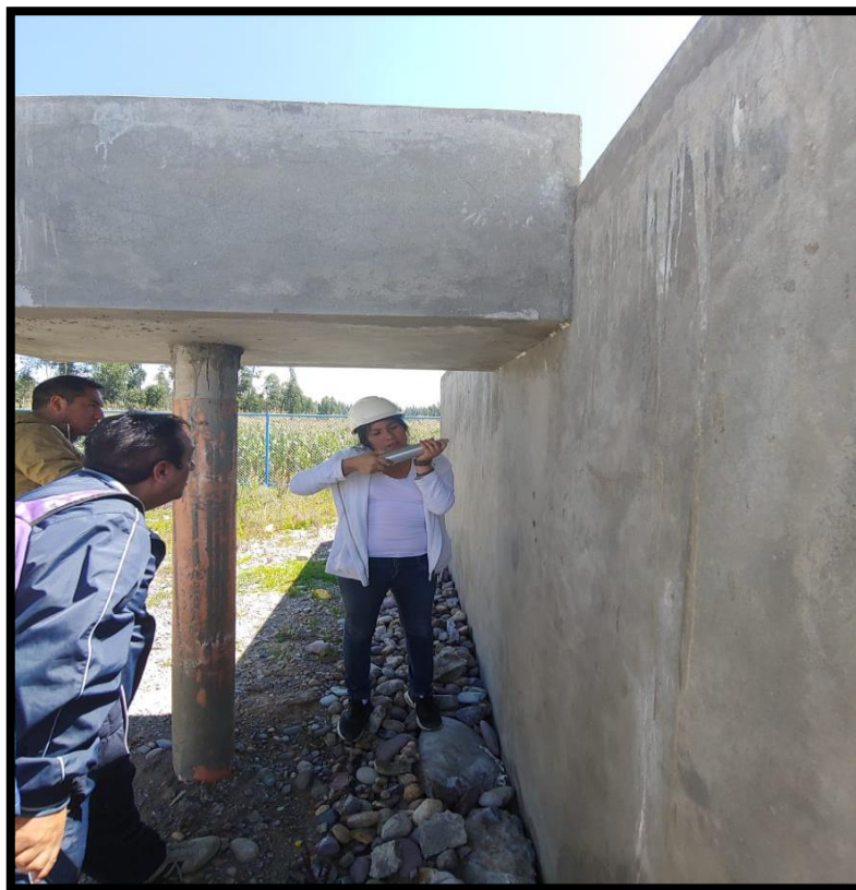
Fotografía 9.- Calculo de la resistencia en el Filtro Biológico PTAR N°01
