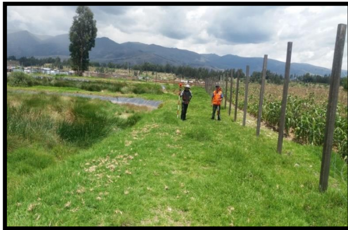
Fotografía 2.- Levantamiento topográfico de la planta del PTAR
