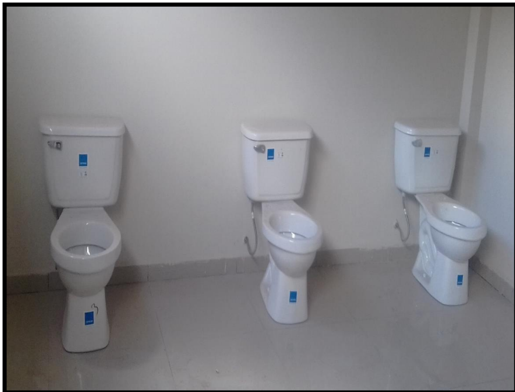
FOTO N° 50: COLOCADO DE LOS SANITARIOS EN LOS SS.HH.
