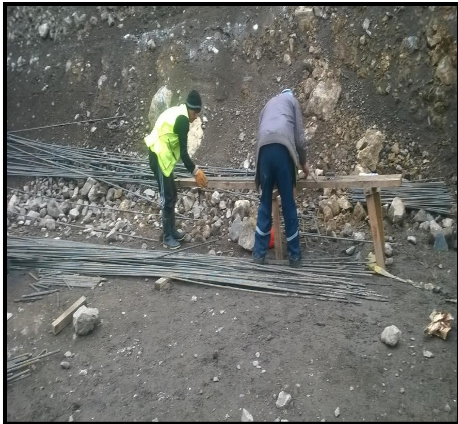
FOTO N° 10: HABILITADO DEL ACERO DE REFUERZO
