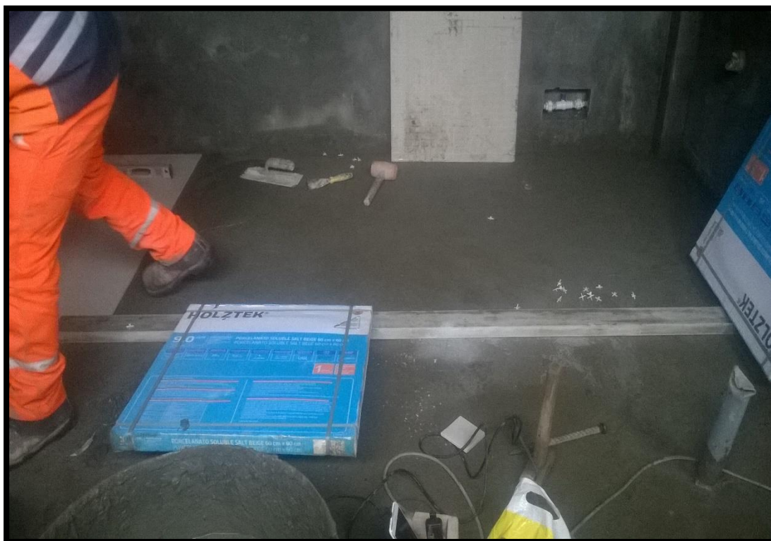
FOTO N° 49: COLOCADO DEL PORCELANATO DE LOS AMBIENTES DEL CAFETIN Y SS.HH.
