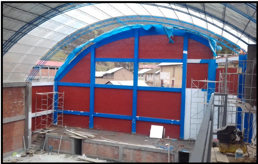
FOTO N° 63: CONTINUANDO CON LOS TRABAJOS DE ARQUITECTURA SE REALIZA EL RESPECTIVO PINTADO DE MUROS, COLUMNAS Y VIGAS EXTERIORES
