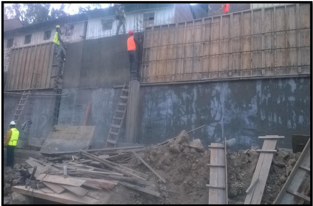
FOTO N°36: DESENCOFRADO DEL MURO DE CONTENCIÓN DEL EJE 5-5'
