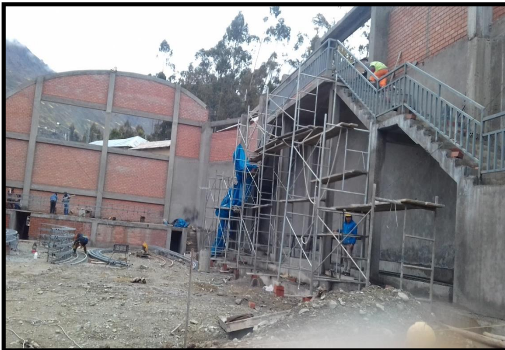
FOTO N° 51: TARRAJEO DE LOS MUROS INTERIORES Y COLUMNAS
