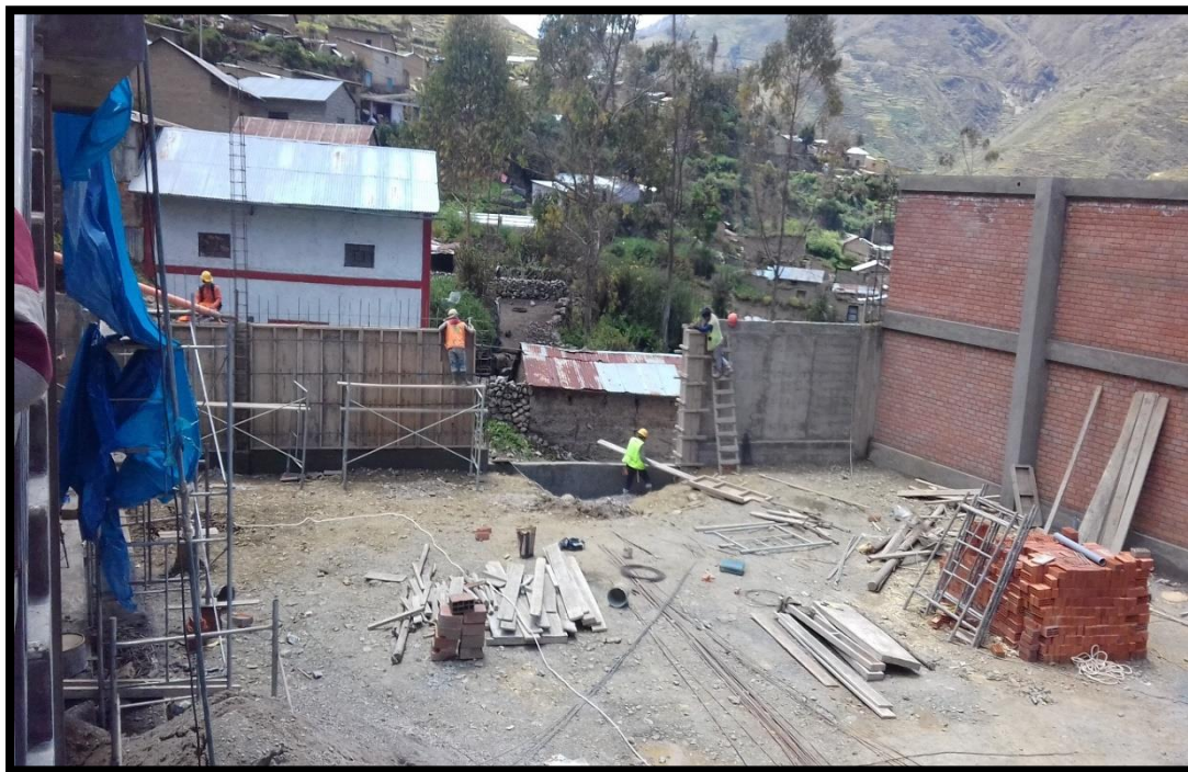
FOTO N° 54: ENCOFRADO DE PANTALLA DE CONCRETO DEL ÚLTIMO EJE
