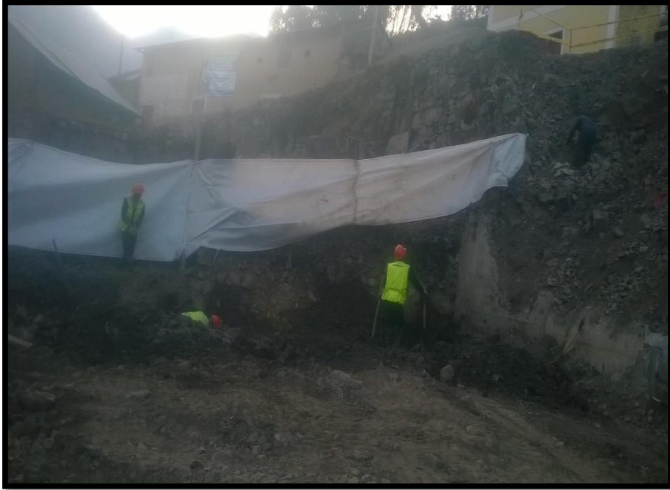
FOTO N° 19: EXCAVACION DE LAS ZANJAS PARA LAS ZAPATAS Y EL CIMIENTO CORRIDO
