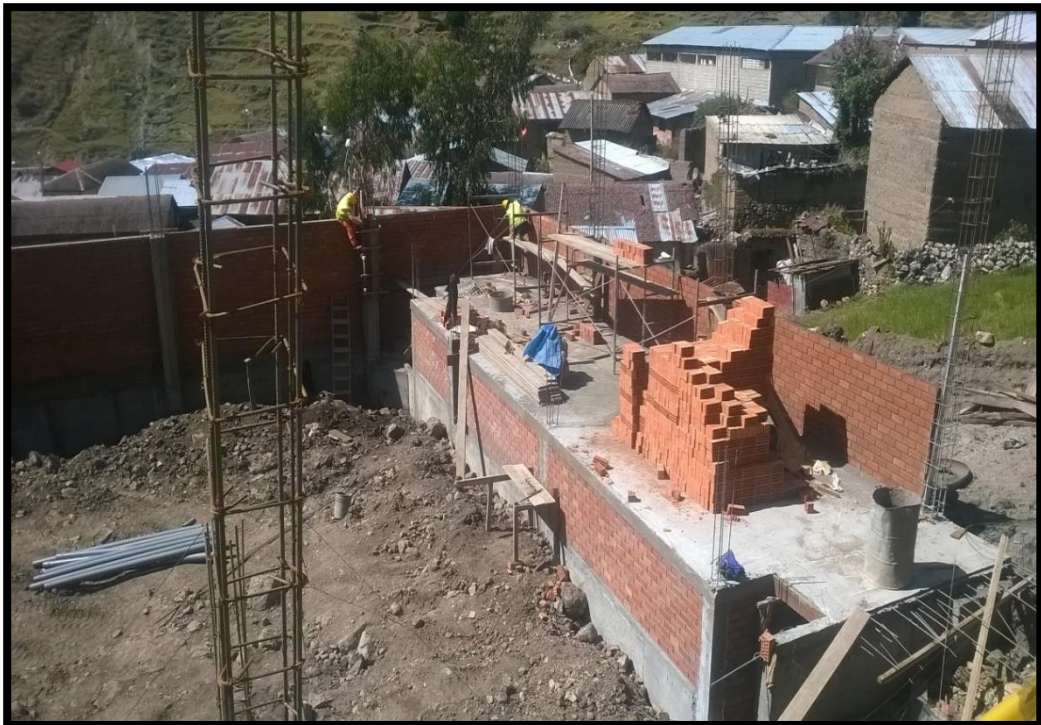
FOTO N°28: CONTINUACIÓN DE LA CONSTRUCCIÓN DEL MURO DE ALBAÑILERÍA
