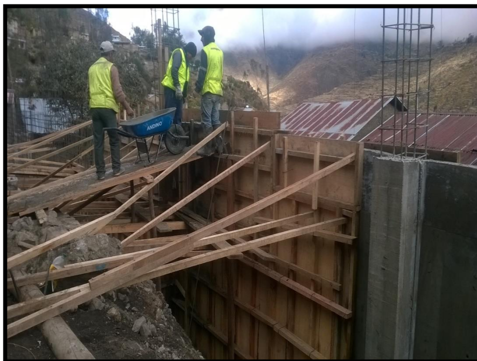
FOTO N° 16: VACIADO DE LAS PANTALLA DEL MURO DE CONTENCIÓN DEL LADO SUR
