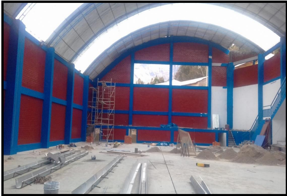
FOTO N° 64 Y 65: SE PUEDE APRECIAR EL PINTADO CULMINADO TANTO DE MUROS, COLUMNAS Y VIGAS INTERIORES
