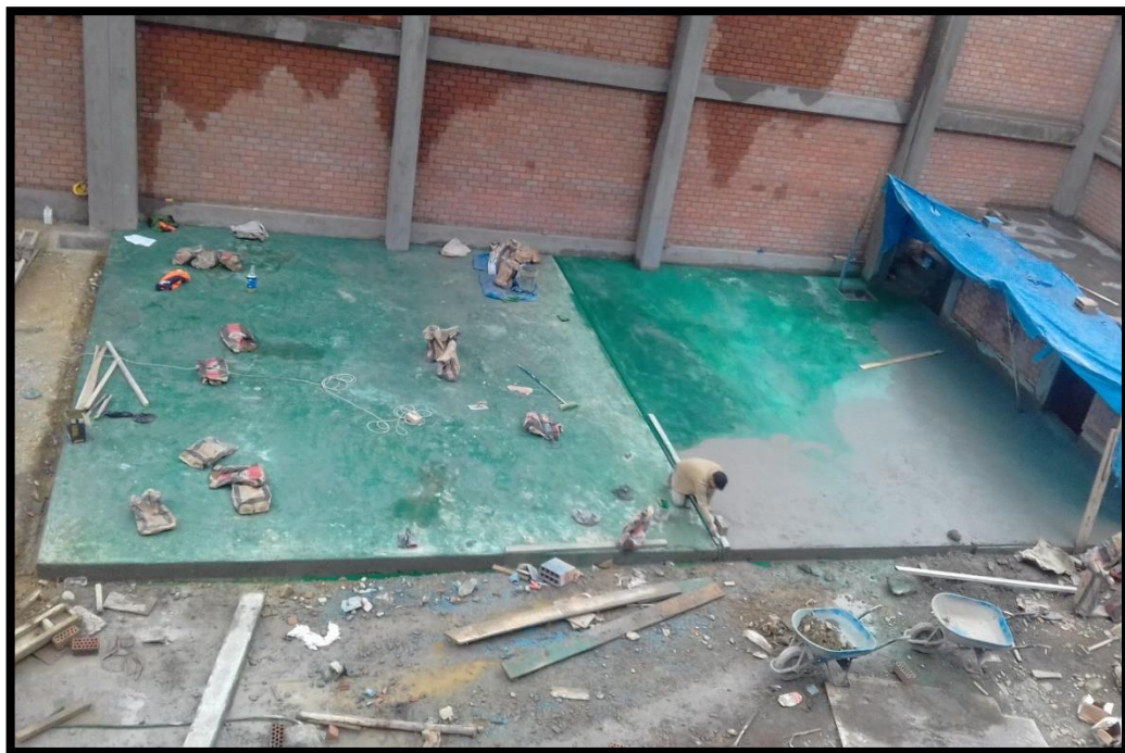
FOTO N° 61: CONTINUANDO CON LOS TRABAJOS DE LA LOSA DEPORTIVA SE REALIZA EL RESPECTIVO PULIDO CON EL OCRE VERDE
