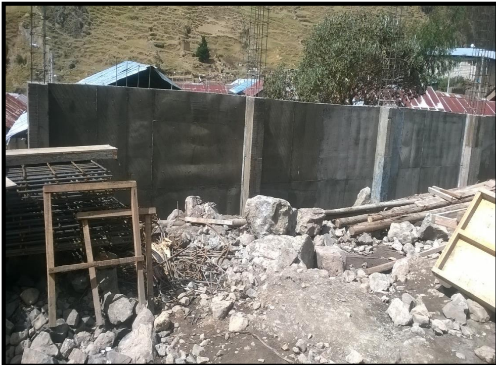
FOTO N° 18: CULMINACION DEL VACIADO DEL MURO DE CONTENCION DEL LADO SUR
