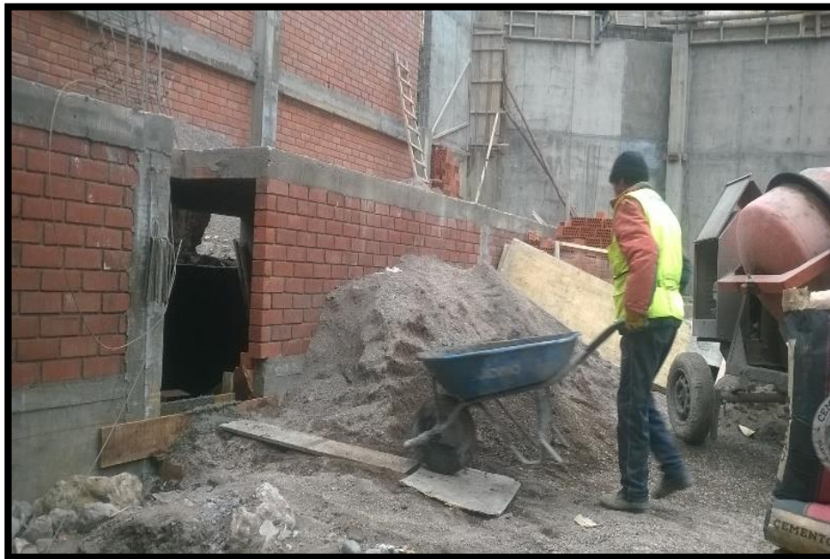
FOTO N° 40: VACIADO DE LAS GRADERIAS PARA EL ACCESO A LOS SS.HH. Y CAFETIN
