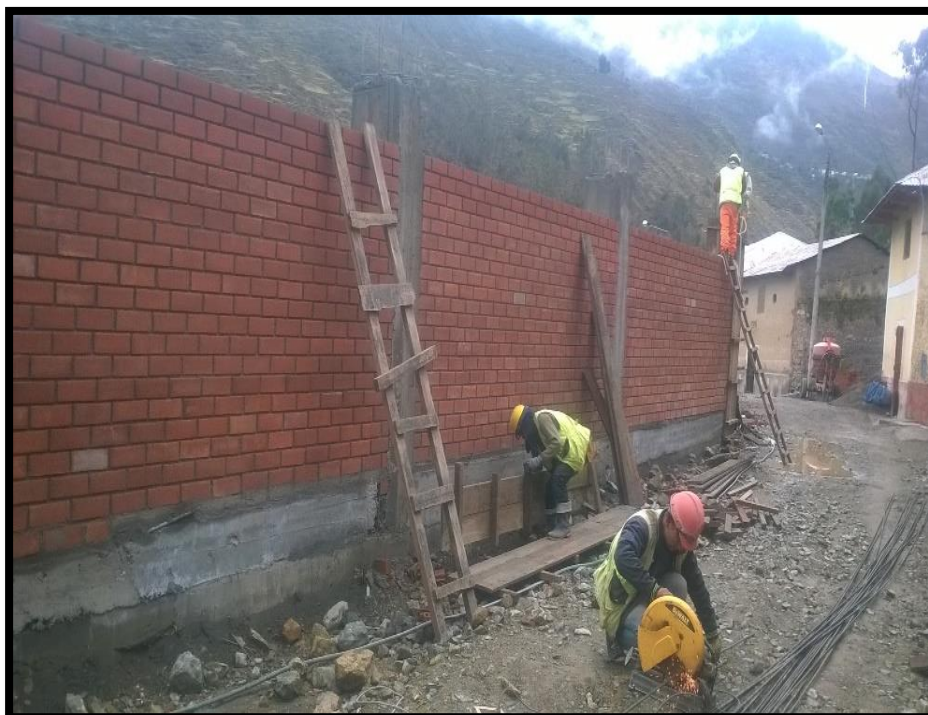
FOTO N°41: TERMINADO DEL MURO DE ALBAÑILERIA DEL EJE 5-5
