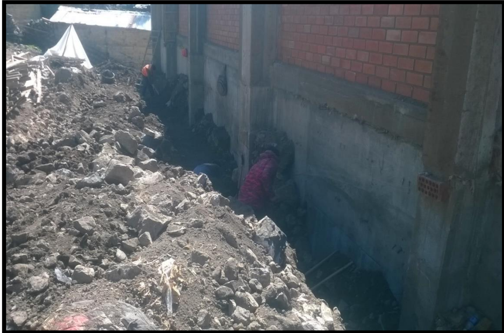
FOTO N°29: EXCAVACIONES PARA EL TENDIDO DE LAS TUBERÍAS DE DESAGÜE DE 4"
