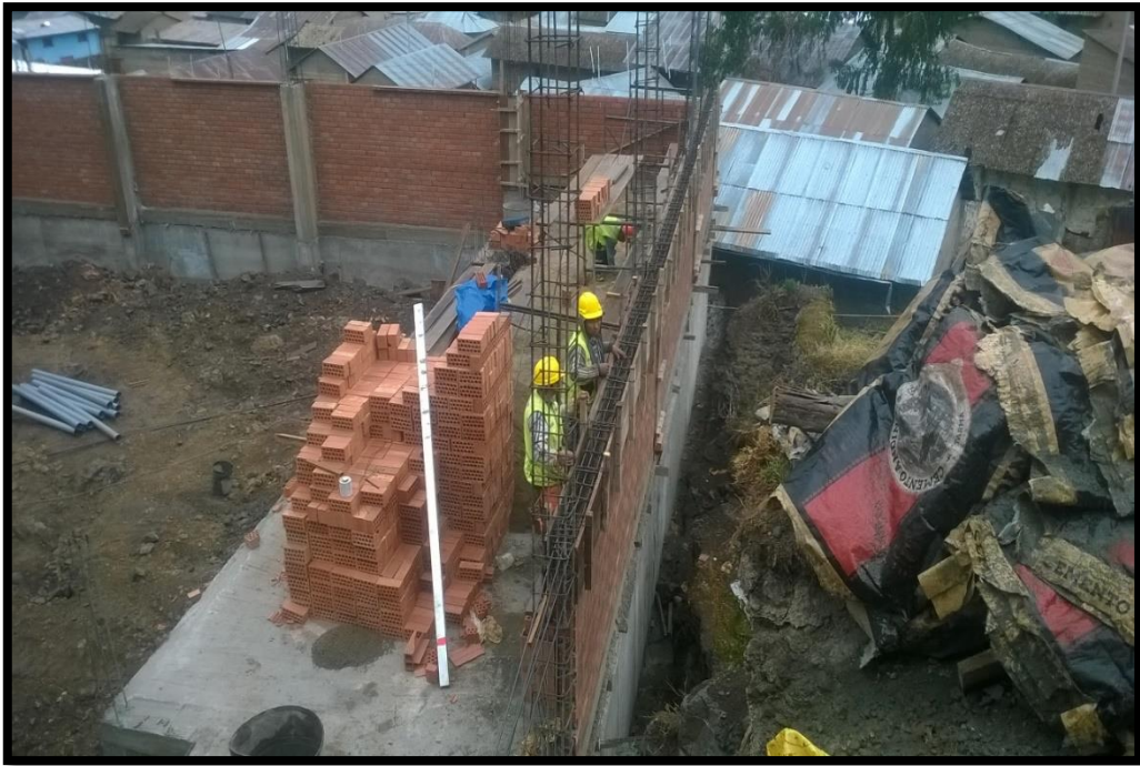
FOTO N° 32: HABILITADO DEL ACERO DE REFUERZO DE LA VIGA CONSIGUIENTE DE ESCENARIO
