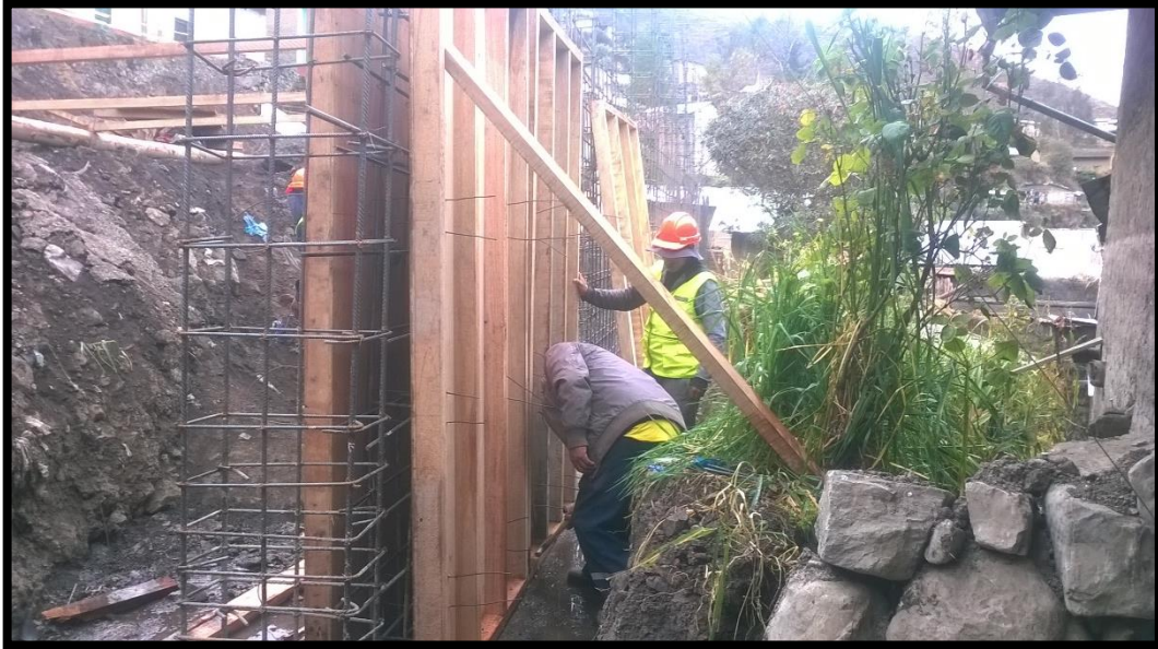
FOTO N° 14: VACIADO DE LAS ZAPATAS DEL MURO DE CONTENCIÓN
