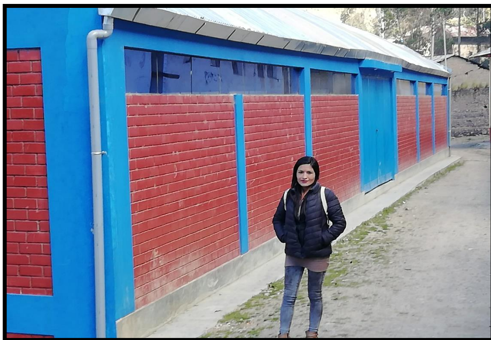
FOTO N° 66 Y 67: SE PUEDE APRECIAR EL PINTADO CULMINADO TANTO DE MUROS, COLUMNAS Y VIGAS EXTERIORES
