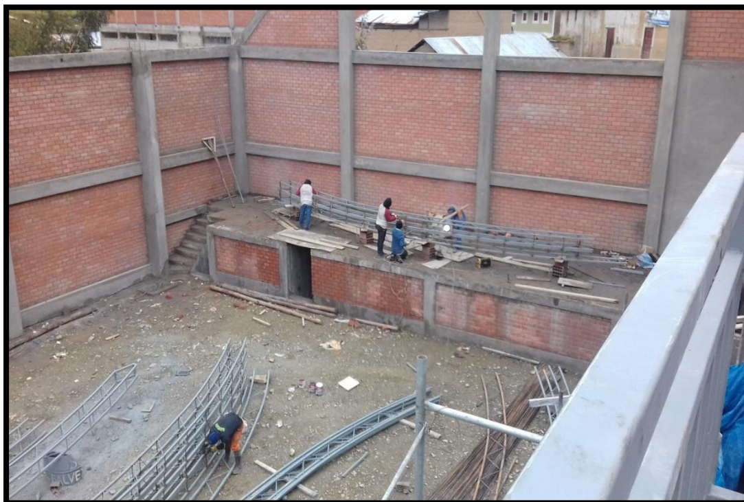
FOTO N° 55: HABILITACION DE TIJERALES PARA COBERTURA DE TECHO
