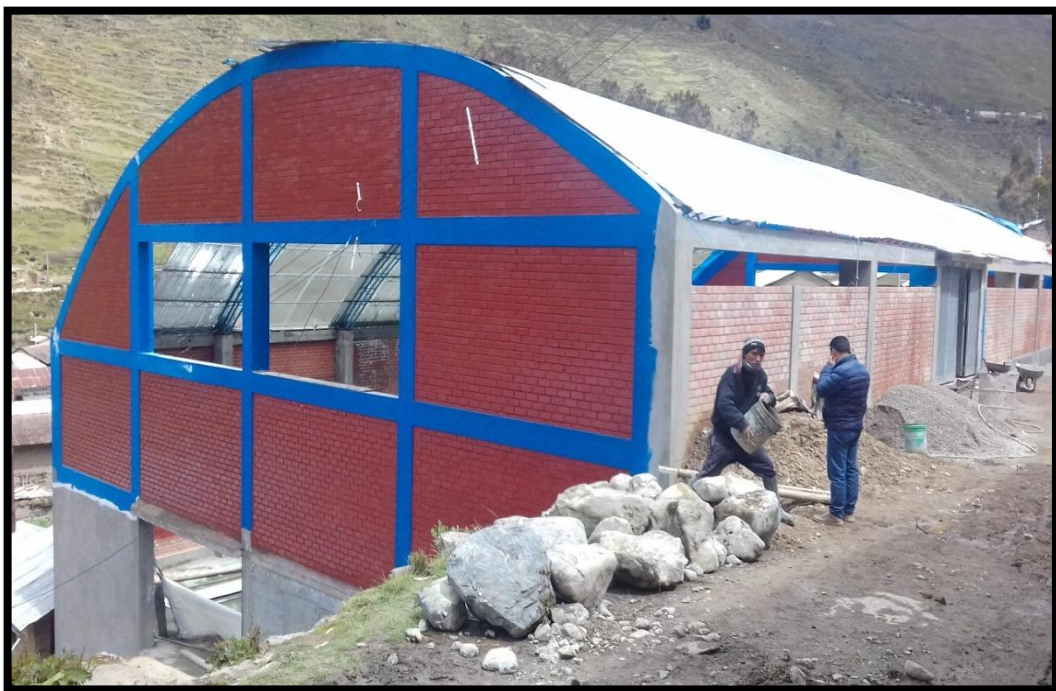
FOTO N° 63: CONTINUANDO CON LOS TRABAJOS DE ARQUITECTURA SE REALIZA EL RESPECTIVO PINTADO DE MUROS, COLUMNAS Y VIGAS EXTERIORES
