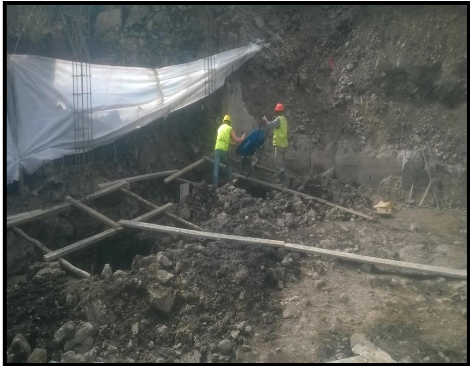
FOTO N° 21: VACIADO DE LAS ZAPATAS
