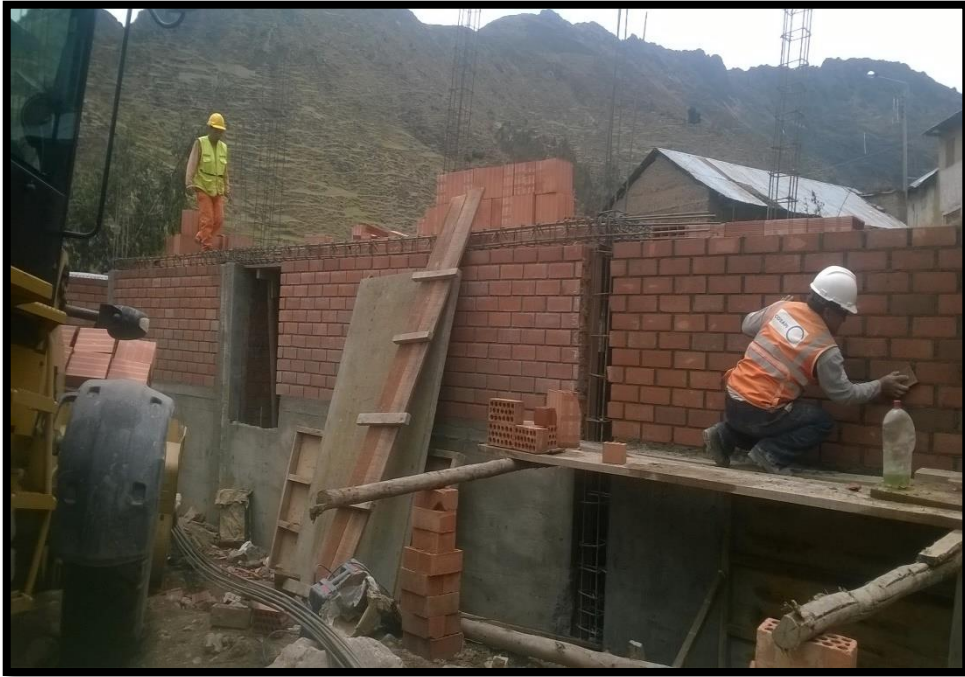
FOTO N° 23: CONSTRUCCION DE LOS MUROS DE TABIQUERIA DE LOS SS.HH.
