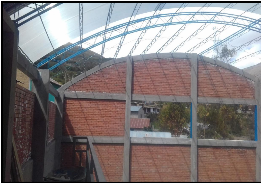
FOTO N° 59: COLOCACION DE LAS CALAMINAS DE LA COBERTURA DE TECHO
