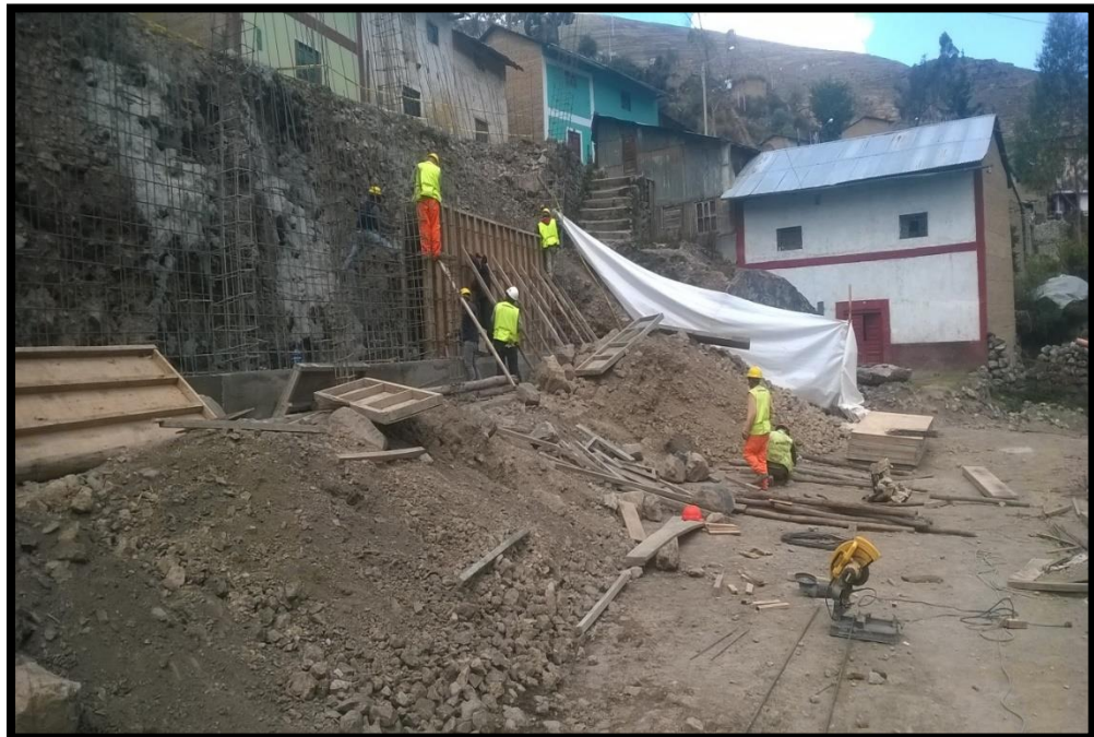
FOTO N°30: CONTINUACIÓN DEL ENCOFRADO DE LA PANTALLA DEL MURO DE CONTENCIÓN.
