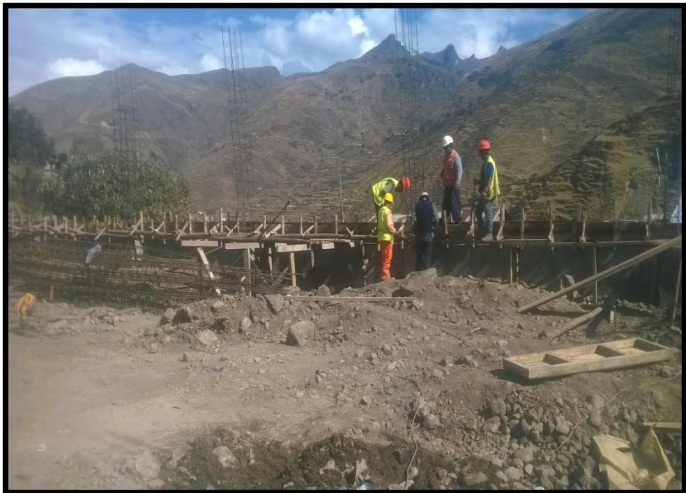
FOTO N° 22: ENCOFRADO DE VIGAS PERIMETRALES
