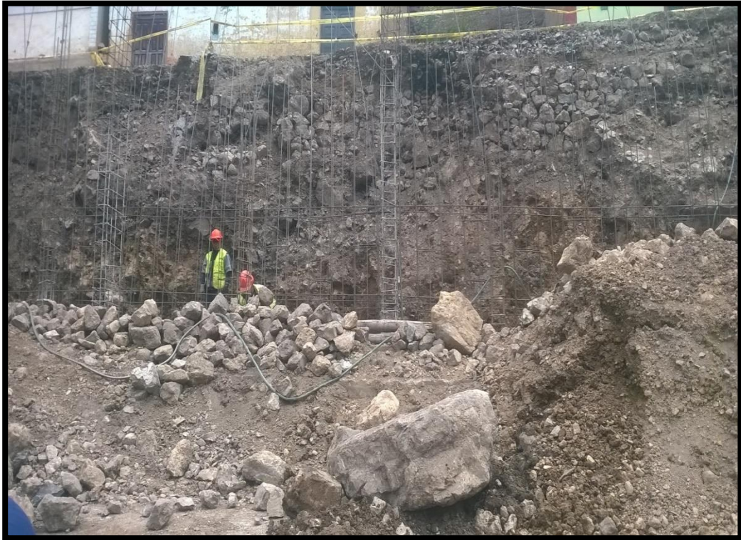
FOTO N°27: HABILITADO DEL ACERO DE REFUERZO DE LA PANTALLA DEL MURO DE CONTENCIÓN
