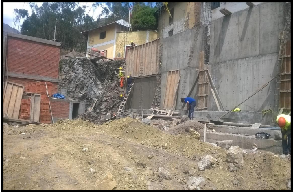
FOTO N°38: CONTINUACIÓN DEL VACIADO DEL ÚLTIMO TRAMO DEL MURO DE CONTENCIÓN
