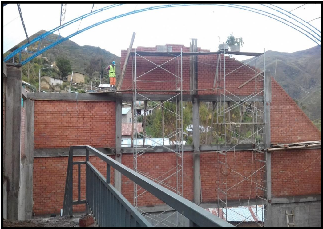
FOTO N° 57: CULMINACION DE LOS TRABAJOS DE ALBAÑILERIA DEL EJE A-A
