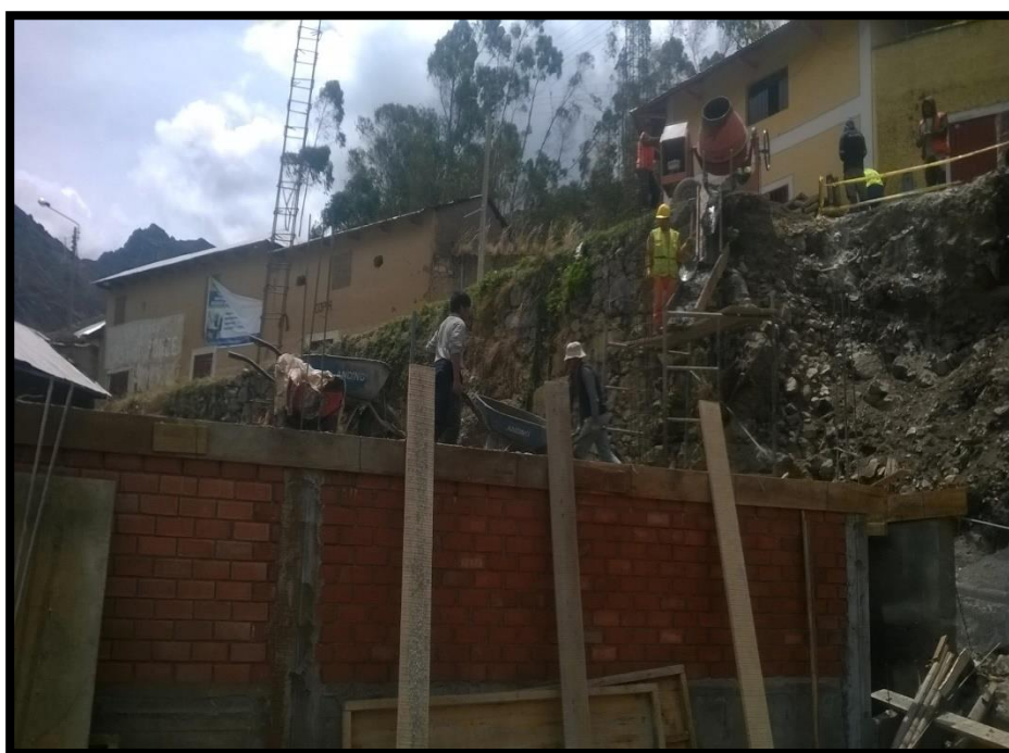
FOTO N° 26: VACIADO DE LA LOSA ALIGERADA
