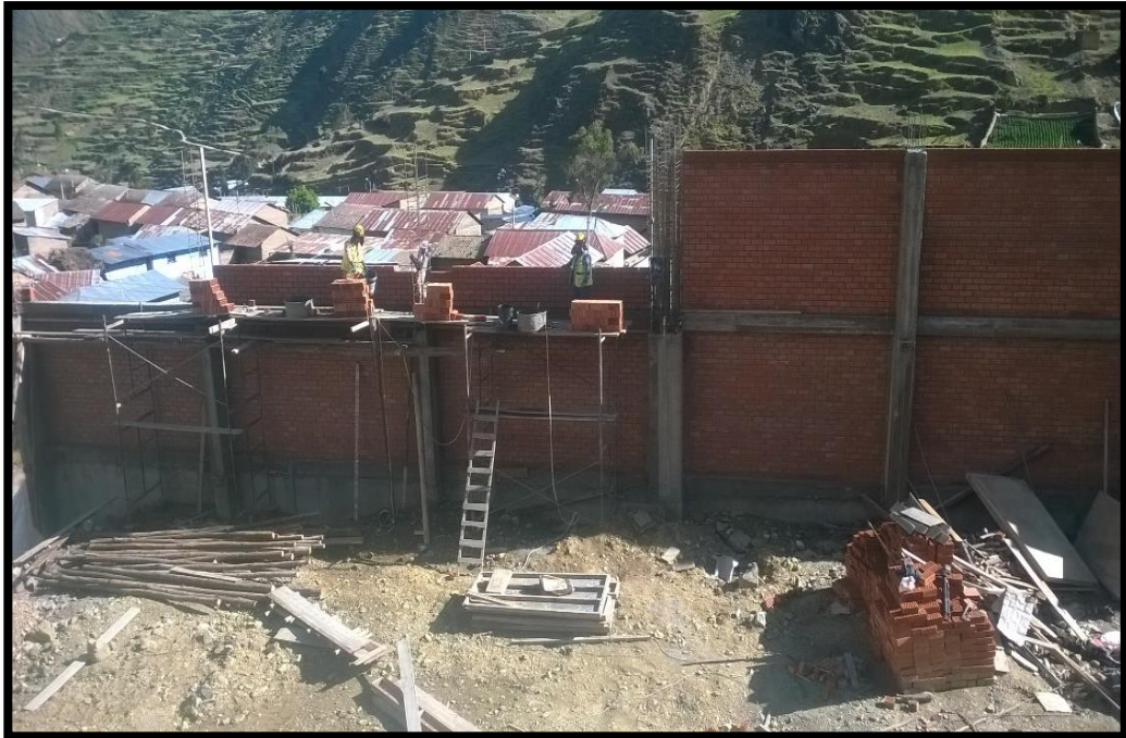
FOTO N° 42: CONTINUACION DEL MURO DE ALBAÑILERIA DEL EJE 1-1
