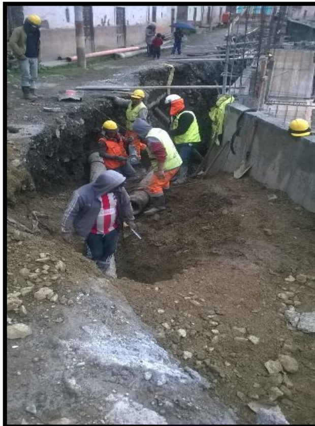
FOTO N° 39: RELLENO AL COSTADO DEL MURO DE CONTENCIÓN DEL EJE 1-1
