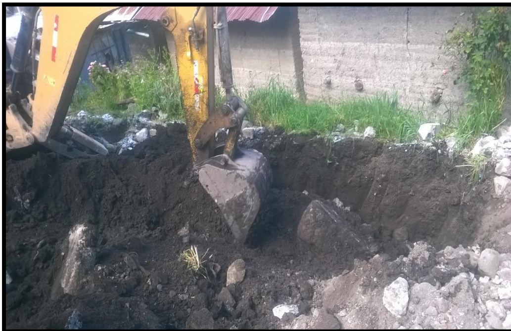
FOTO N° 04: EXCAVACION PARA ZANJAS DE CIMENTACION DEL MURO DE CONTENCION
