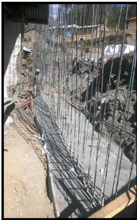
FOTO N° 15: VACIADO DE LOS CIMIENTOS DEL MURO DE CONTENCIÓN
