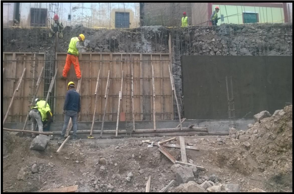
FOTO N° 34: DESENCOFRADO DE LA PANTALLA DEL MURO DE CONTENCIÓN
