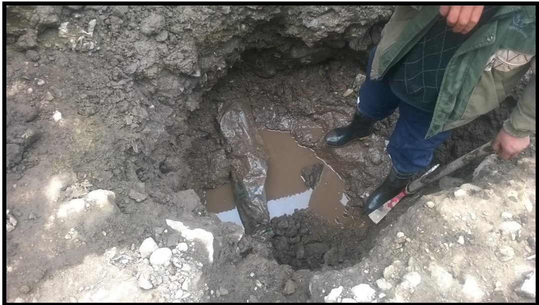
FOTO N° 06: REPARACION DE LAS TUBERIAS DAÑADAS EN LA CALLE JOSE OLAYA (PRINCIPAL EL ACCESO DE VIA A LA OBRA)
