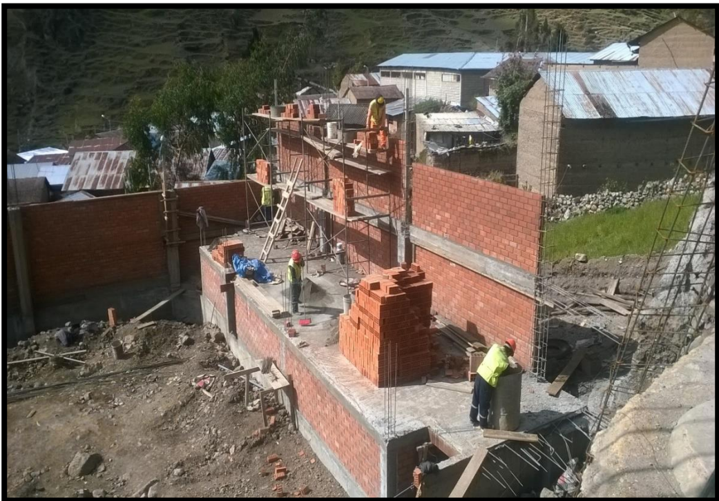
FOTO N° 35: CONTINUACIÓN DEL MURO DE TABIQUERÍA DEL EJE A-A'
