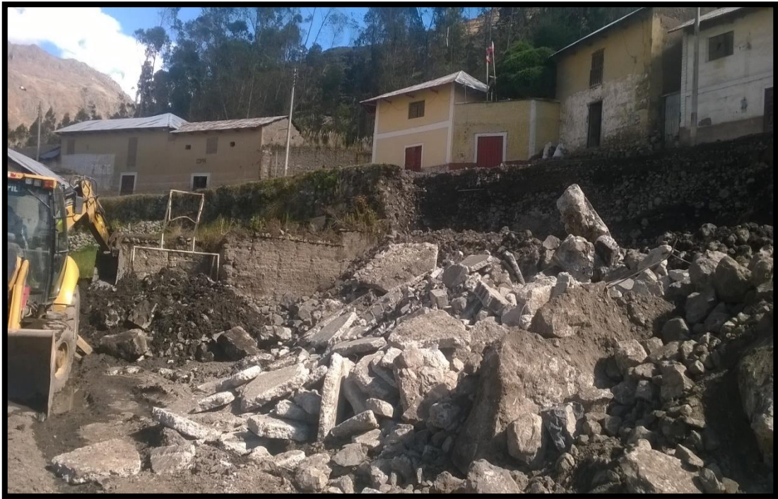
FOTO N° 01: DEMOLICION DE LA CONSTRUCCION EXISTENTE
