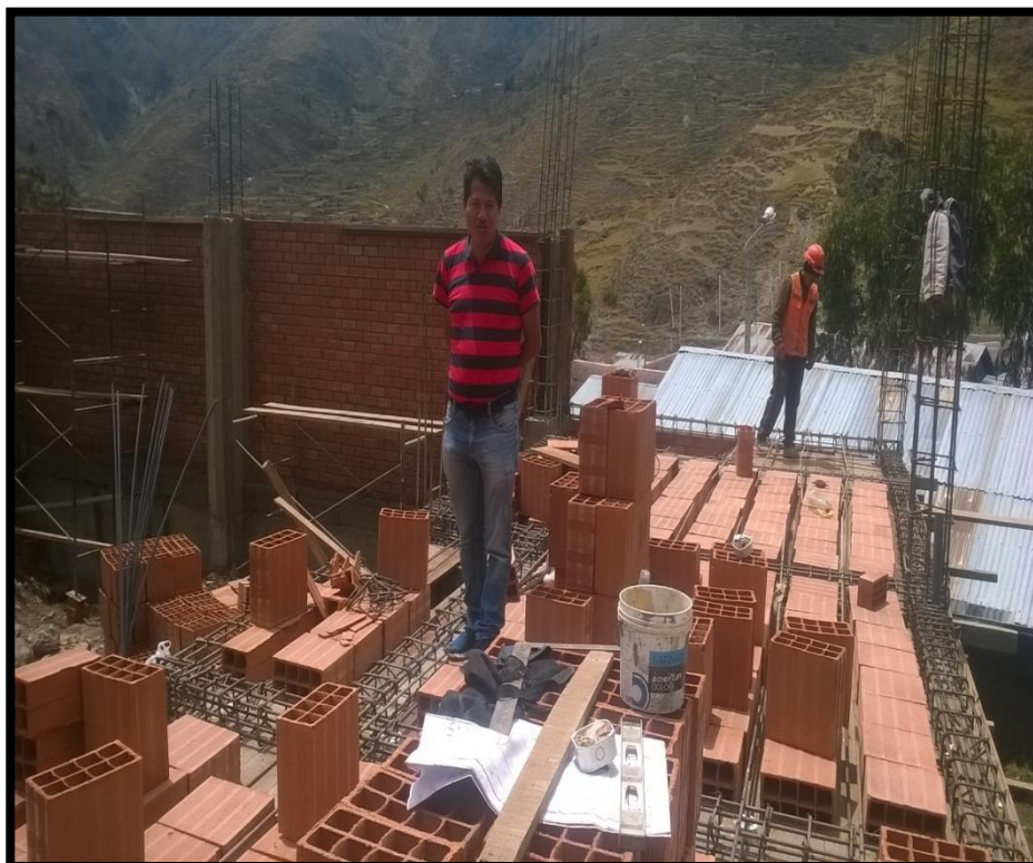
FOTO N° 25: HABILITADO DE LA LOSA ALIGERADA
