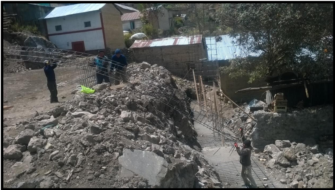
FOTO N° 11: IZADO DEL ACERO PARA LAS COLUMNAS
