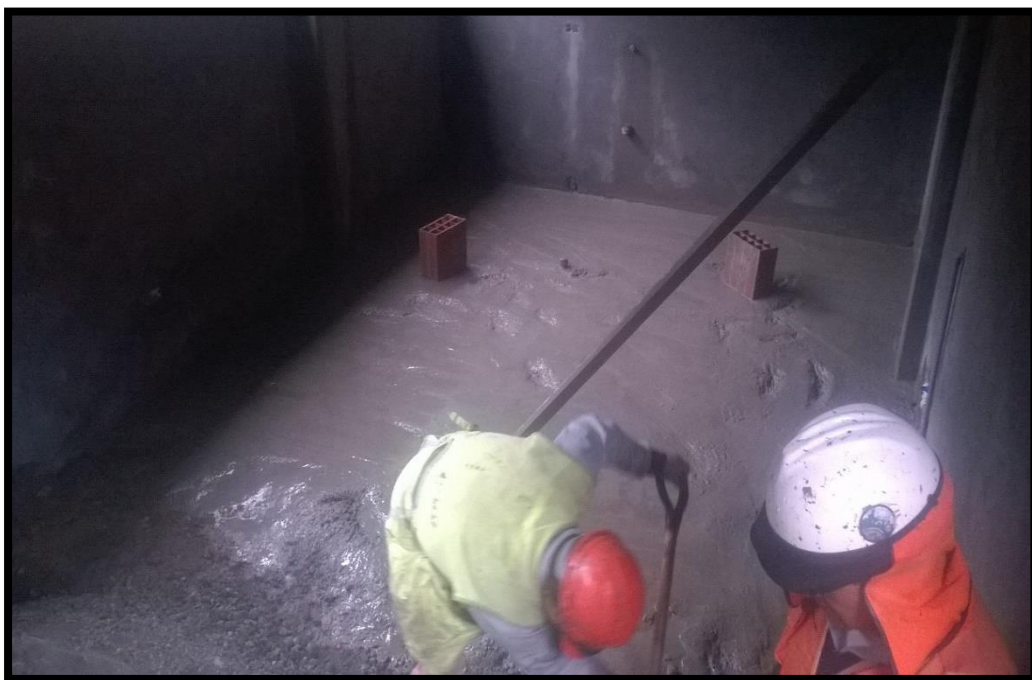
FOTO N° 48: VACIADO DEL FALSO PISO DE LOS AMBIENTES DEL CAFETIN Y SS.HH.
