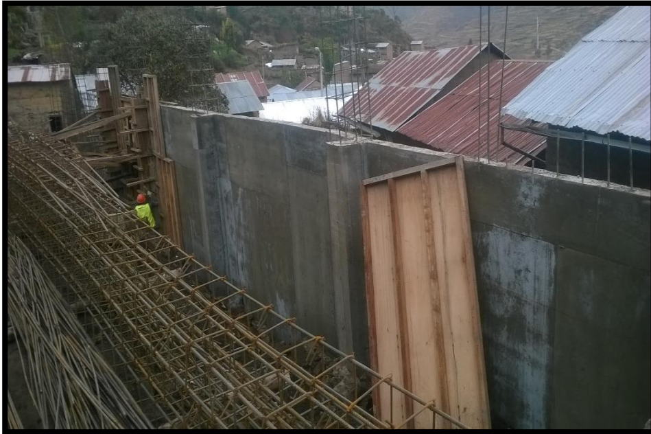
FOTO N° 17: PANTALLA DEL MURO DE CONTENCION DEL LADO SUR DESENCOFRADAS
