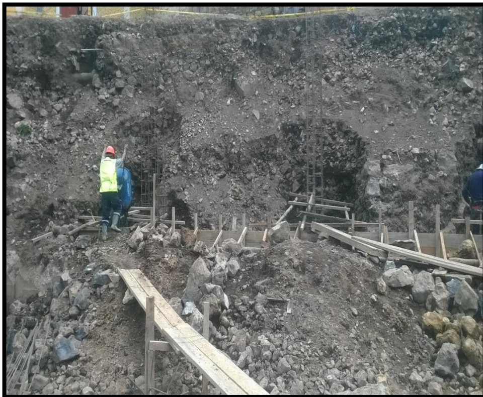
FOTO N° 24: VACIADO DE LAS ZAPTAS DEL EJE 5-5
