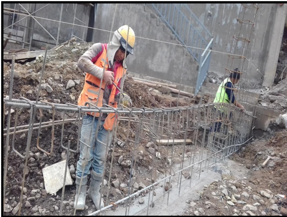
FOTO N° 52 Y 53: HABILITACION DEL ACERO PARA EL ULTIMO EJE
