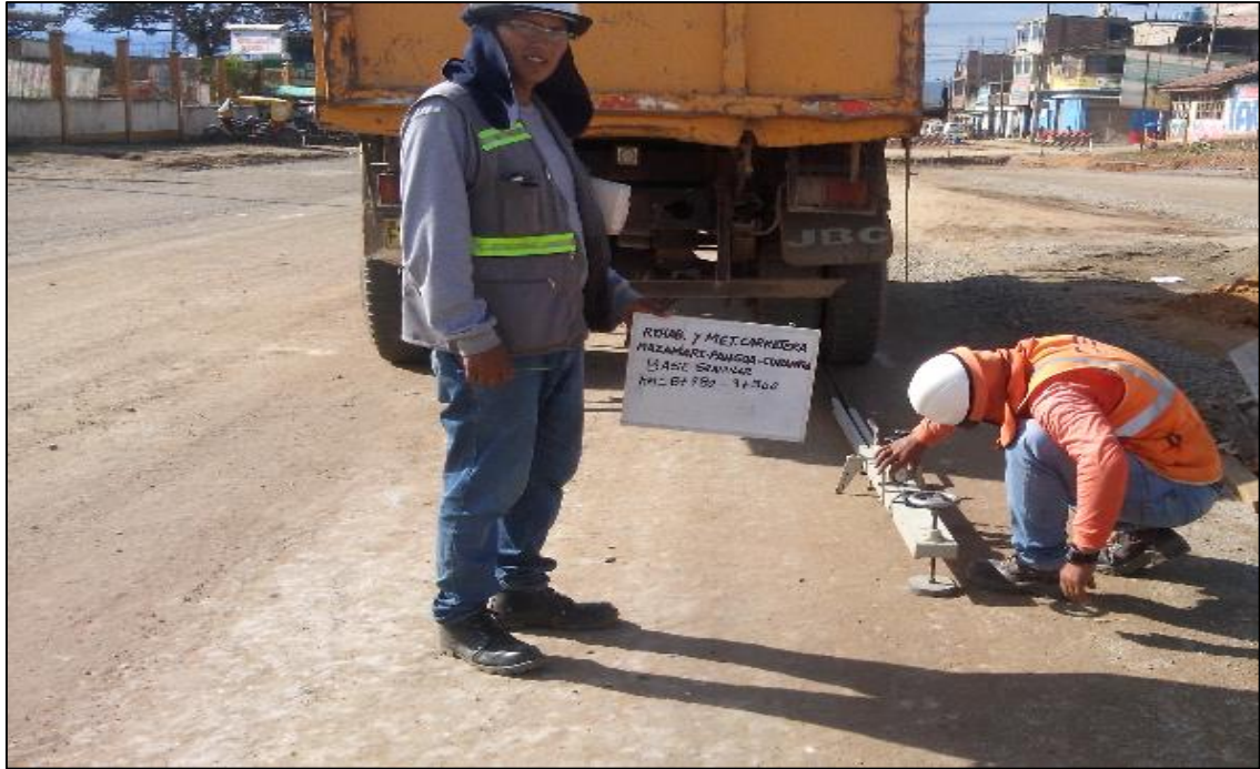
Figura N° 15: Deflectometría a nivel de base Km 8+980 – 9+360, plataforma completa.
