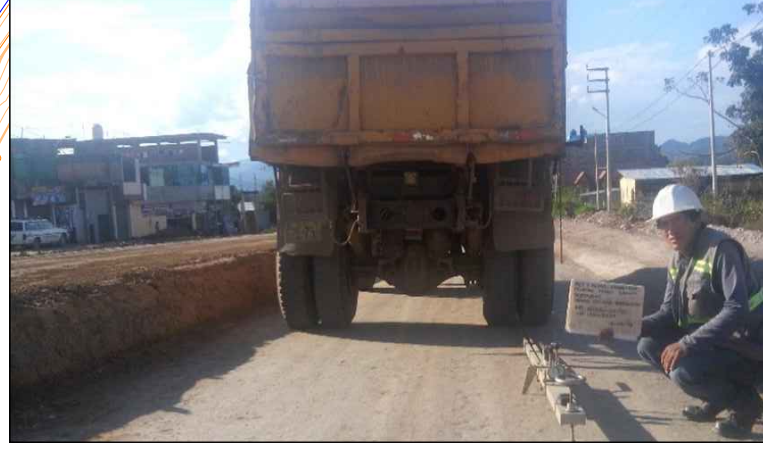
LIBERACION POR DEFLEXION SUBBASE KM 8+970-9+360 PLATAFORMA COMPLETA
