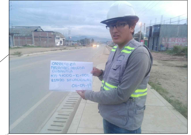
ESTADO SITUACIONAL (06/09/19) PAVIEMTO FLEXIBLE KM 9+800
