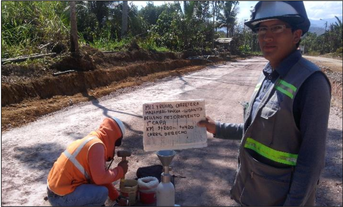
Figura N° 07: Mejoramiento, control de calidad (densidades) Km 9+200 – 9+420 carril derecho.
