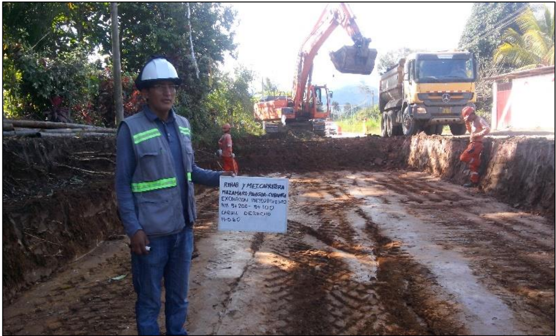
Figura N° 01: Mejoramiento, excavación por carriles km 9+100-9+200.
