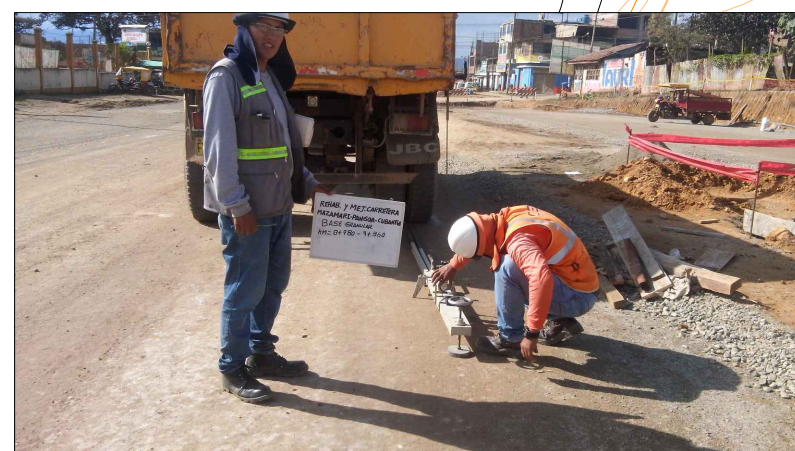
LIBERACION POR DEFLEXION BASE KM 8+980-9+360 PLATAFORMA COMPLETA
