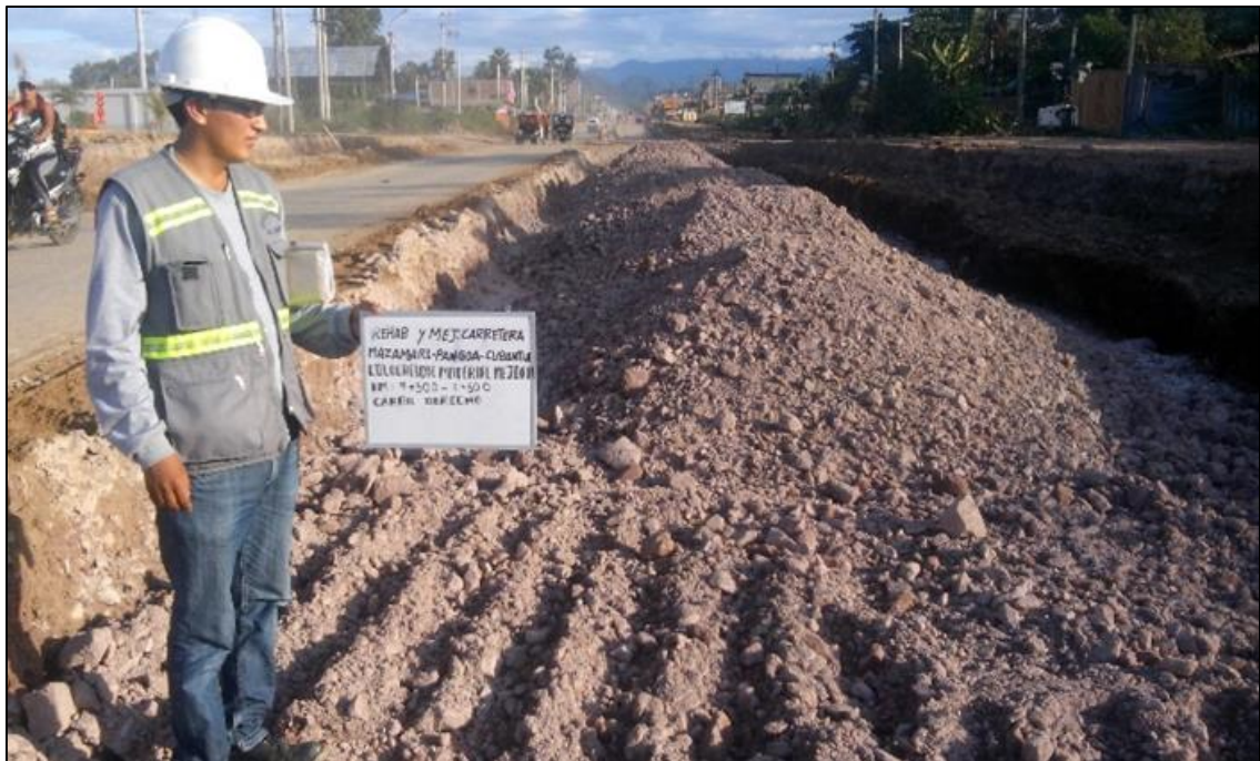
Figura N° 06: Mejoramiento, material de cantera km 9+000-10+000.
