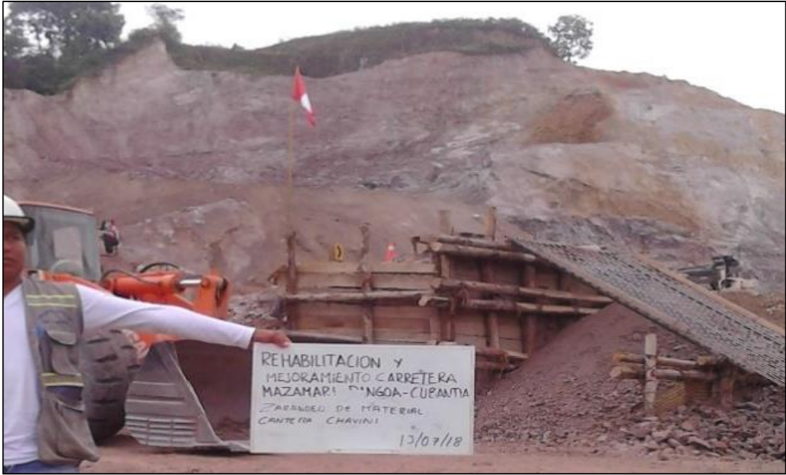
Figura N° 05: Mejoramiento, cantera Chavini zarandeo de material km 11+840
