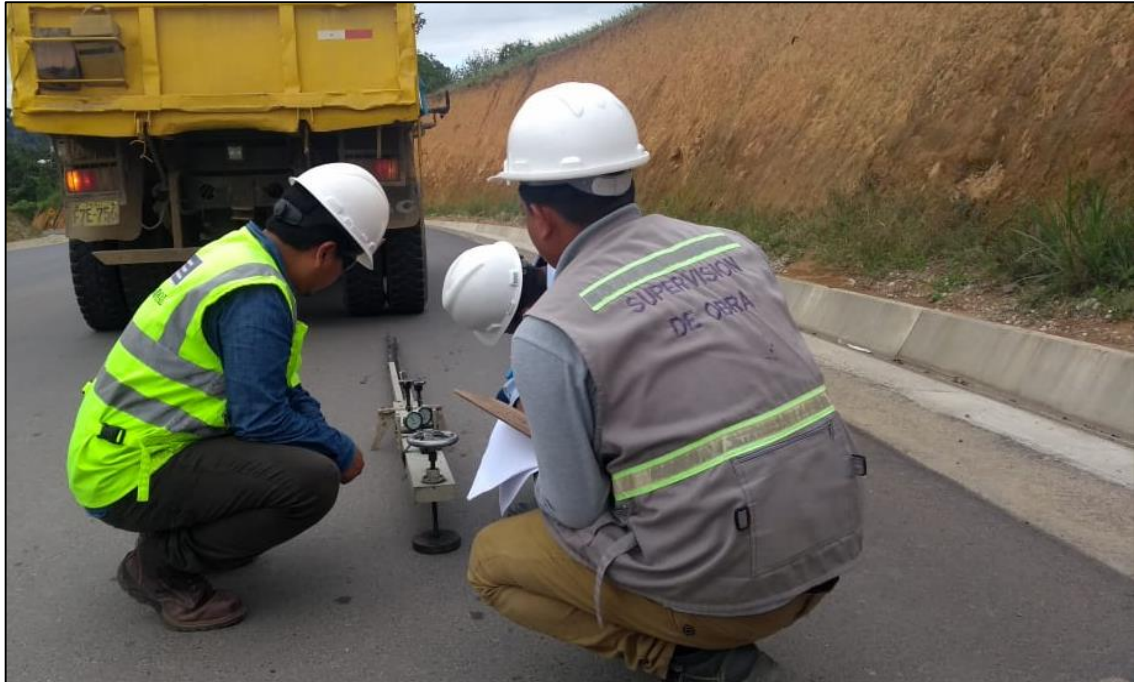
Figura N° 18: Deflectometría a nivel de carpeta asfáltica Km 9+000 – 10+000 plataforma completa.
