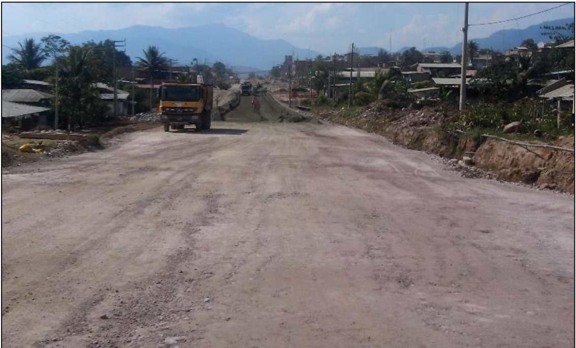
Figura N° 12: Volquete cargado neummatizando los puntos observados por presentar deflexiones que sobrepasan ligeramente.
