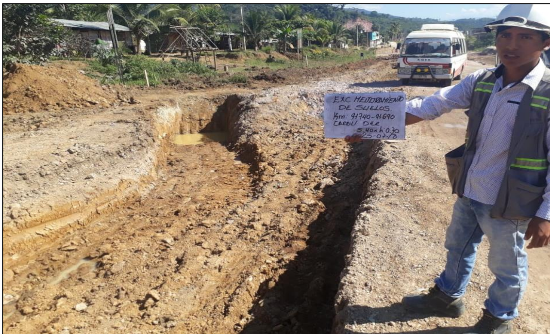
Figura N° 04: Mejoramiento, espolón para drenar la filtración de agua km 9+690-9+740 lado derecho.
