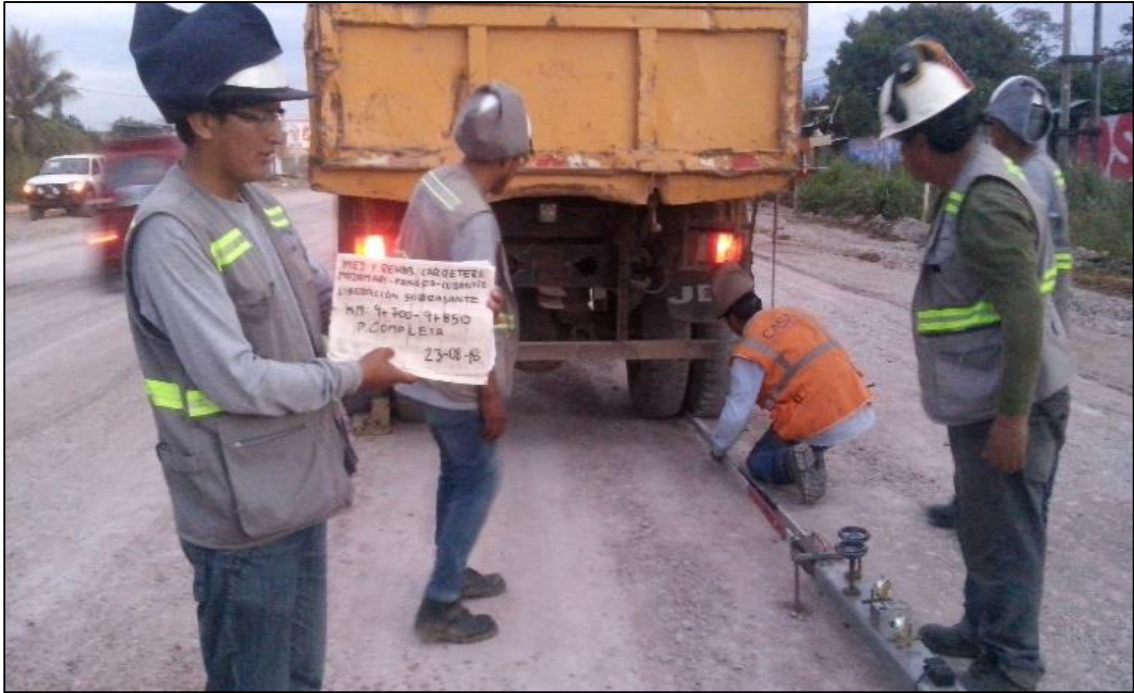
Figura N° 09: Deflectometría a nivel subrasante Km 9+700 – 9+850 plataforma completa.
