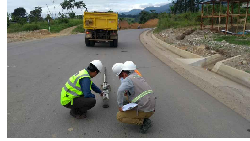
LIBERACION POR DEFLEXION CARPETA ASFALTICA KM 9+000-10+000 PLATAFORMA COMPLETA
