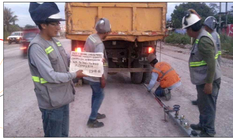
LIBERACION POR DEFLEXION SUBGRANTE KM 9+700-9+850 PLATAFORMA COMPLETA
