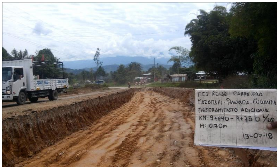
Figura N° 02: Mejoramiento, excavación por carriles km 9+640-9+750.
