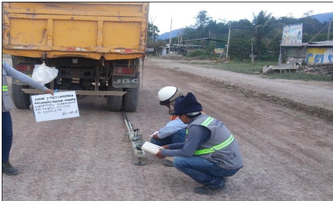
Figura N° 10: Deflectometría a nivel subrasante Km 9+850 – 10+000, plataforma completa.
