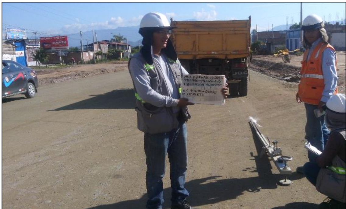
Figura N° 14: Deflectometría a nivel subbase Km 9+690 – 10+030, plataforma completa.
