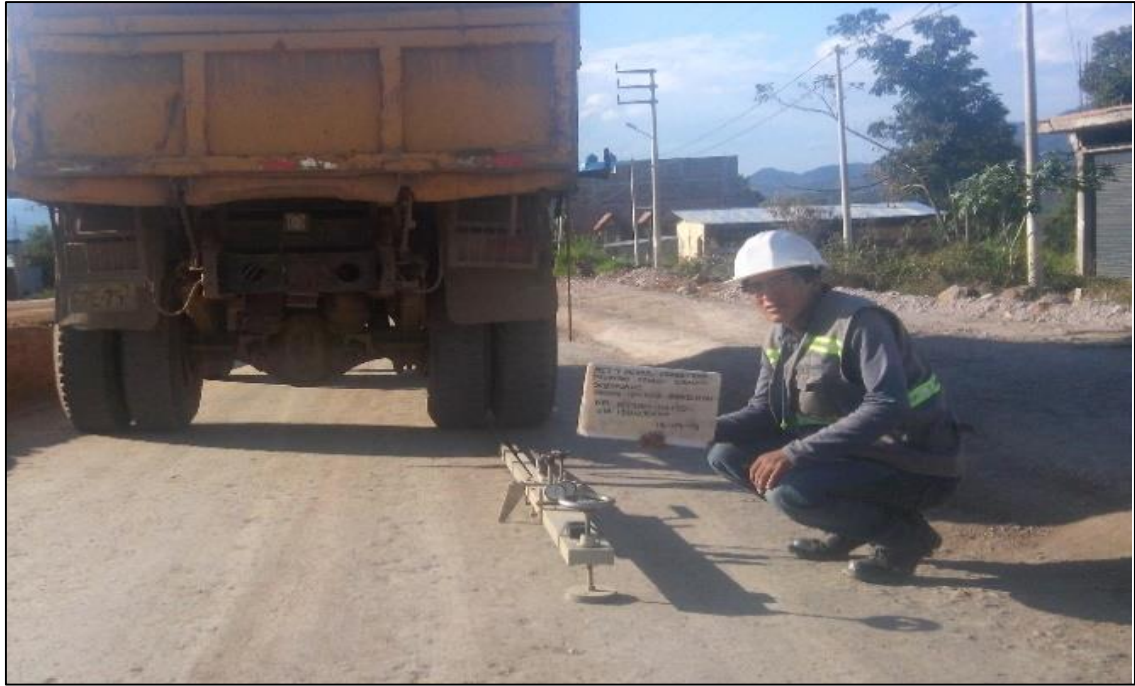
Figura N° 13: Deflectometría a nivel subbase Km 8+970 – 9+360, plataforma completa.
