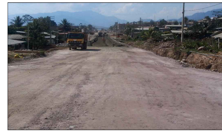
CAMION ENCARGADO DE NEUMATIZAR LOS PUNTOS OBSERVADOS KM 9+000- 10+000
