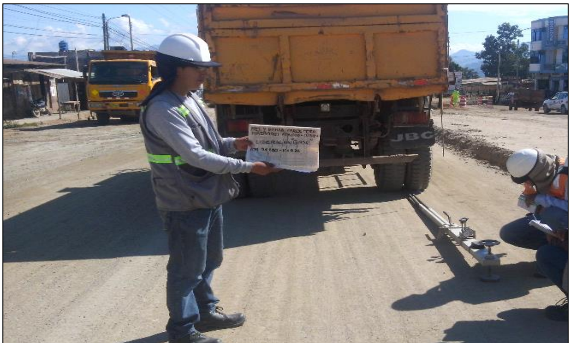
Figura N° 16: Deflectometría a nivel de base Km 9+680 – 10+020, plataforma completa.
