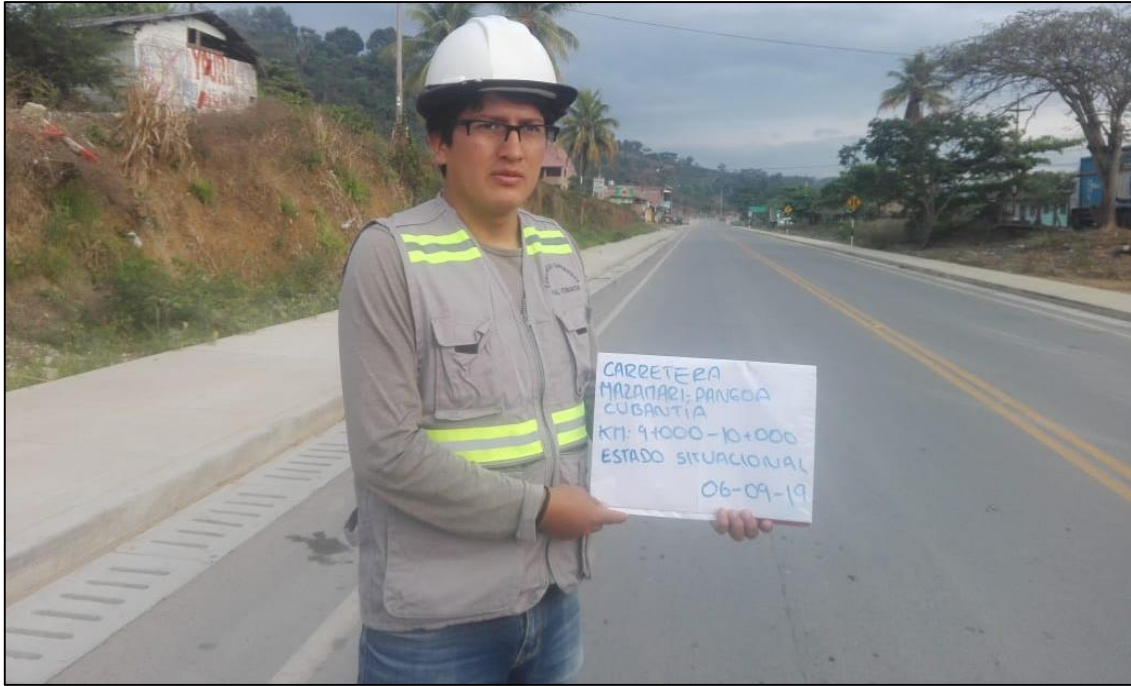
Figura N° 19: Estado situacional de la carretera Mazamari – Pangoa – Cubantía fecha 06/09/19, Km 9+250.
