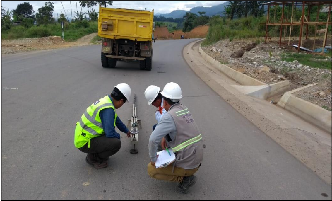
Figura N° 17: Deflectometría a nivel de carpeta asfáltica Km 9+000 – 10+000 plataforma completa.
