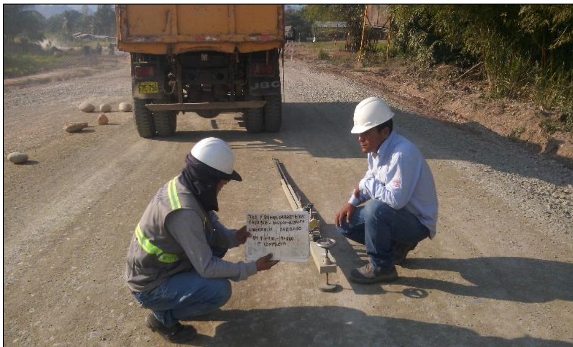
Figura N° 08: Deflectometría a nivel subrasante Km 9+400 – 9+700 plataforma completa.
