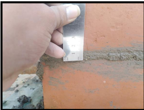
Figura N° 21 El espesor de cada pila fue de 1cm a 1.5 cm según indica la norma técnica.
