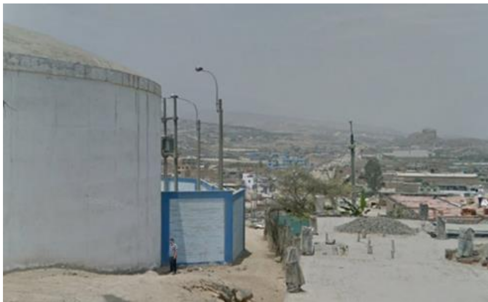
Figura 3.16: Visita del reservorio para aforo de caudal
