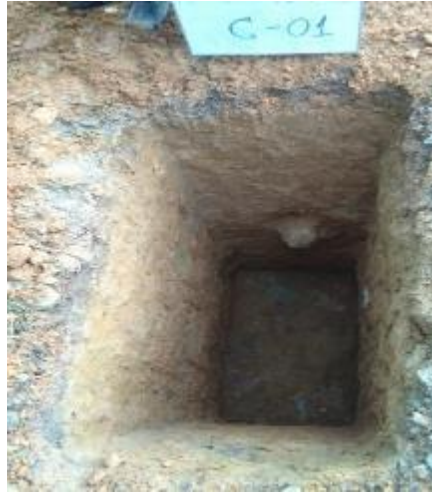
Figura 3.14: Calicata N° C-01
