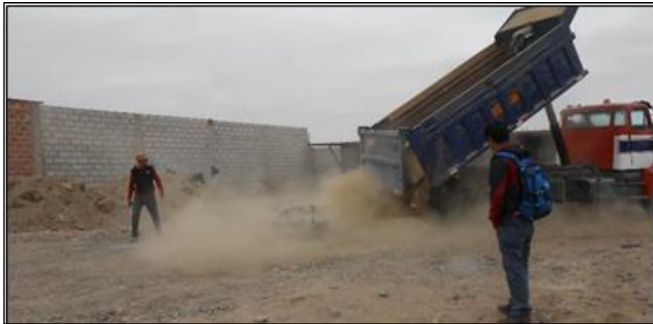
Fotografía 4. Vista de colocación en botadero del material excedente de construcción.
