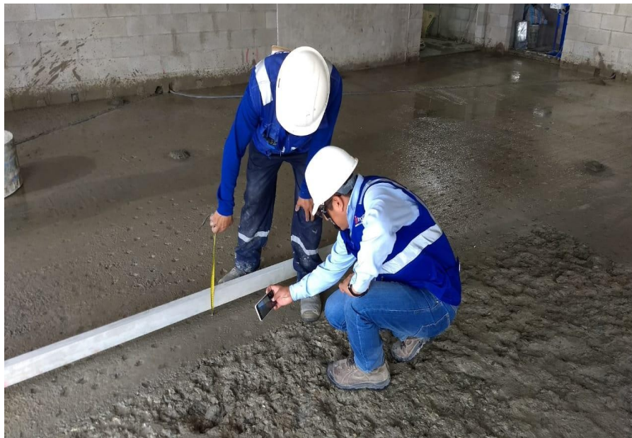
Fig. N° 16. Controlando la horizontalidad del contrapiso.
