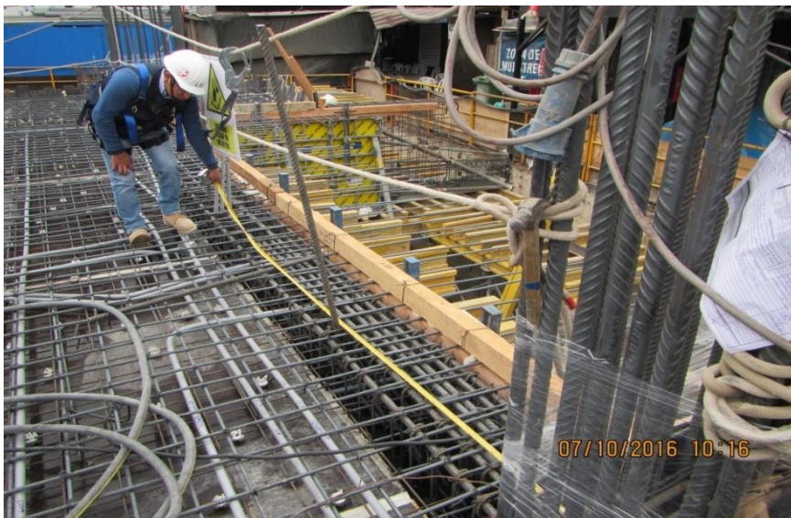
Fig. N° 18. Control de acero en vigas.
