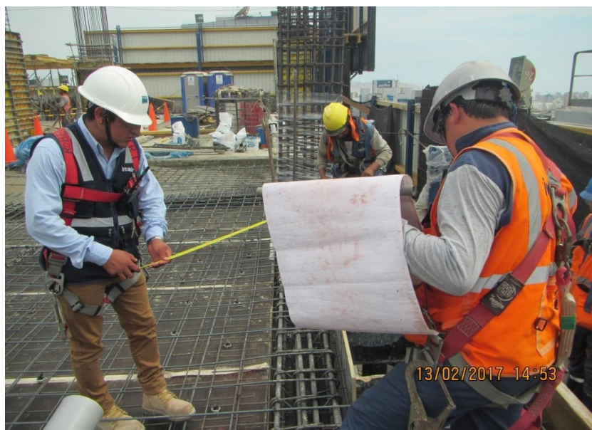
Fig. N° 43. Revisando los fierros de las vigas.
