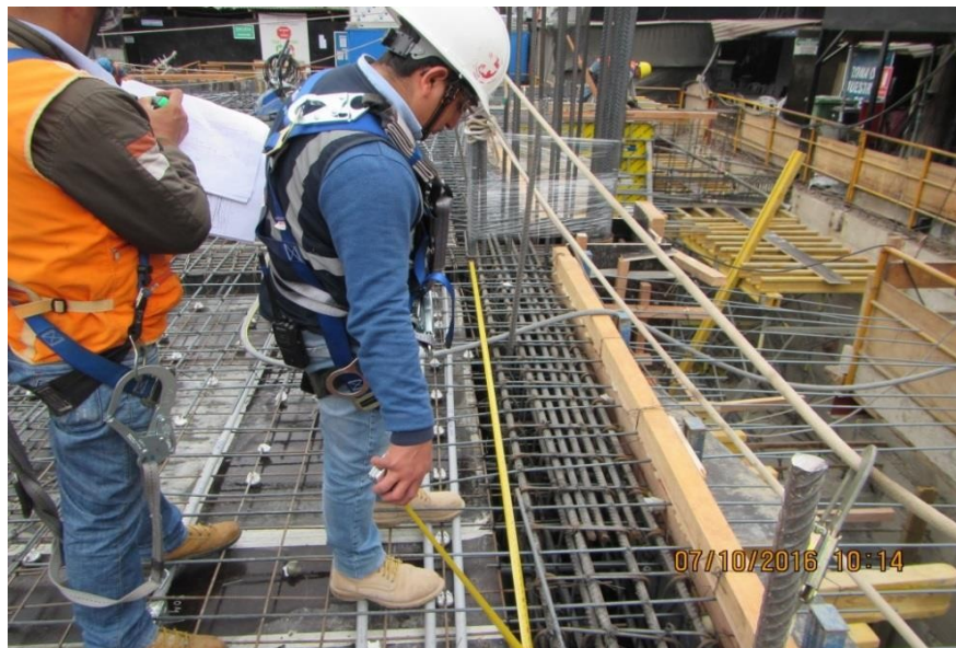
Fig. N° 49. Verificación de armado del acero de refuerzo.
