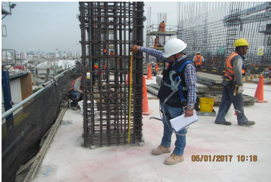
Fig. N° 45. Verificando los traslapes y los estribos de la columna.
