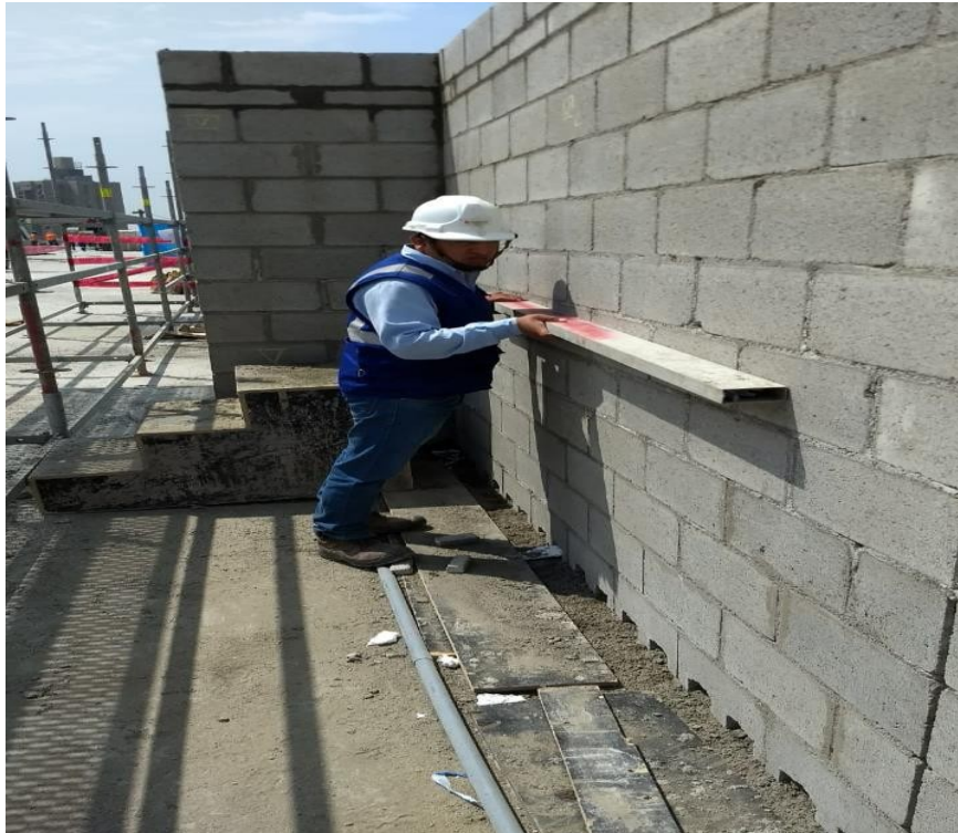
Fig. N° 15. Verificando la verticalidad de los muros. Fuente propia.
