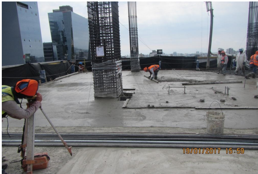
Fig. N° 47. Controlando con el nivel de concreto en la losa maciza.
