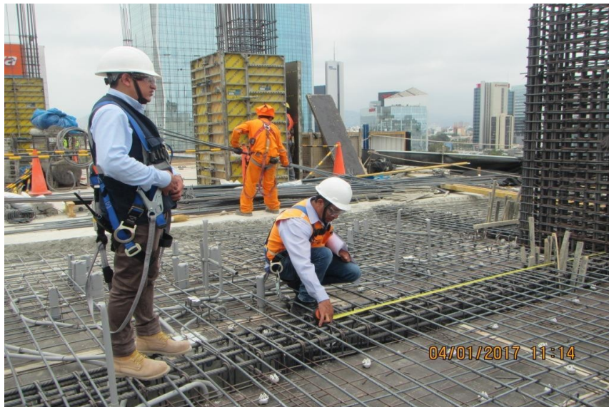
Fig. N° 46. Recubrimiento en la losa maciza
