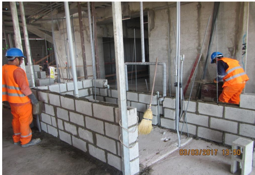
Fig. N° 48. Asentado de ladrillo sillico calcáreo, en los extremos el escantillón.
