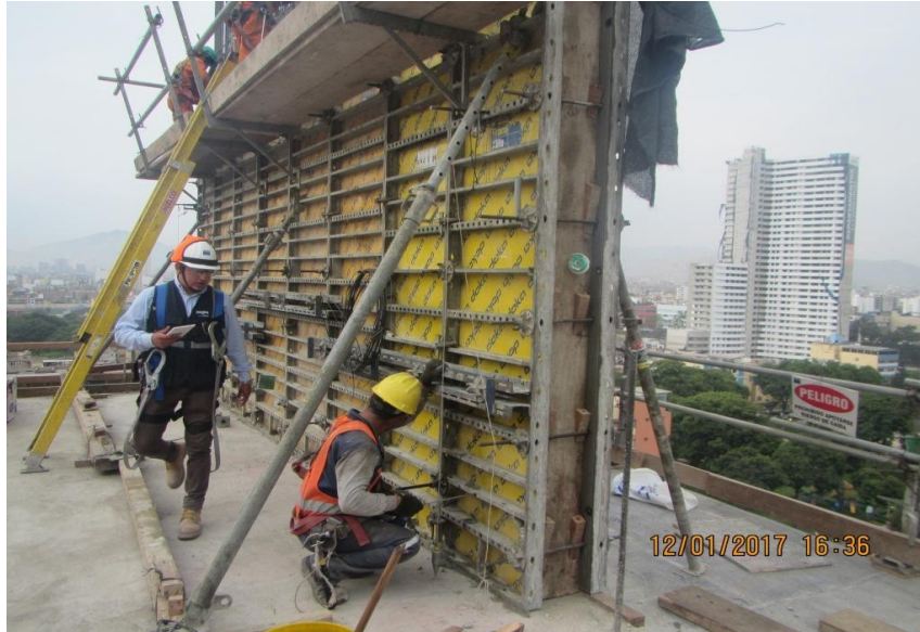
Fig. N° 44. Encofrado de muro de concreto armado.
