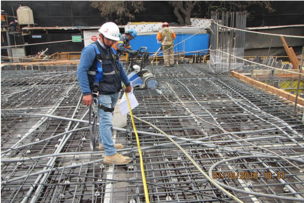
Fig. N° 50. Verificando los traslapes de fierro en losa maciza.
