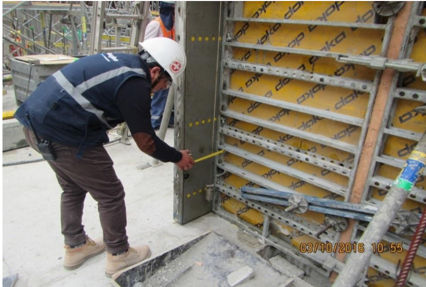
Fig. N° 19. Verificando el ancho del encofrado de muro concreto armado.
