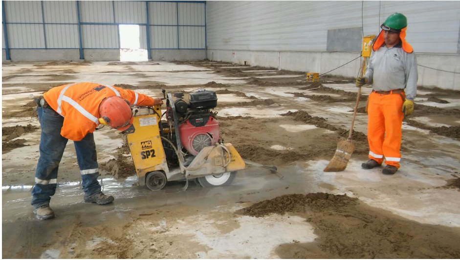
Figura 13. Corte de juntas.
