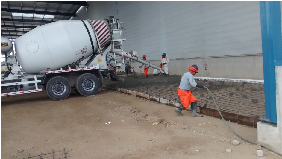
Figura 11. Colocación de concreto.
