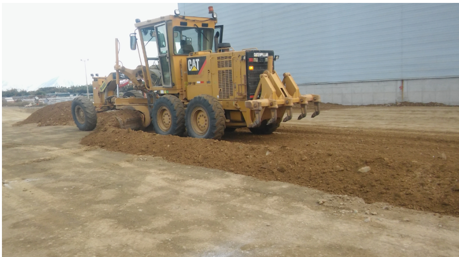
Figura 6. Relleno de material.
