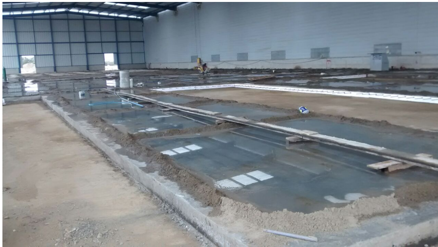
Figura 12. Curado de concreto.
