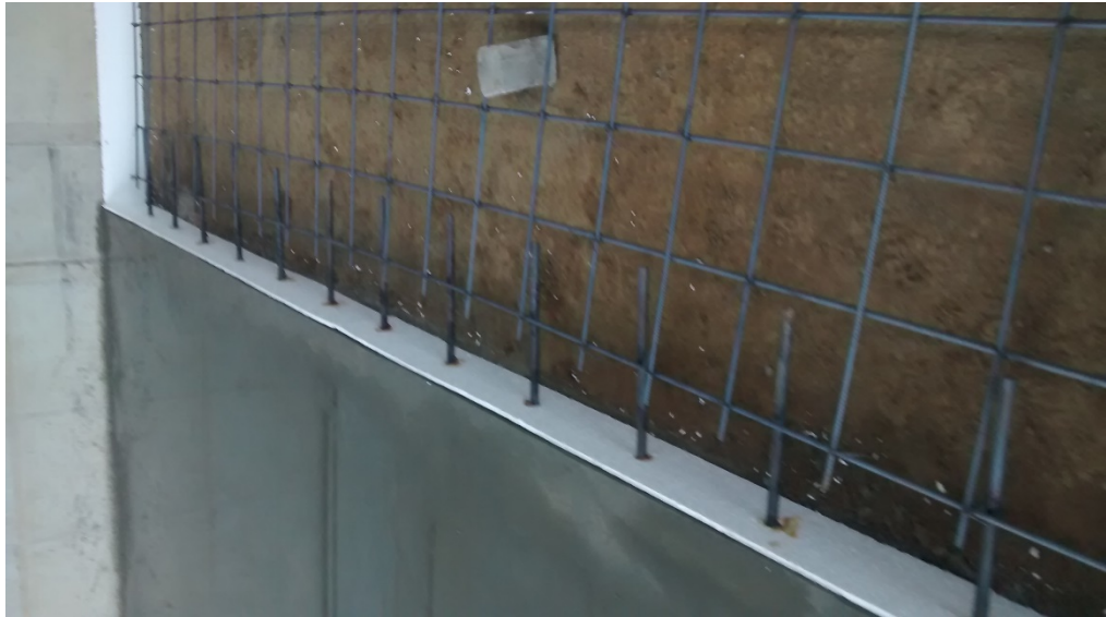
Figura 9. Encofrado para la losa.
