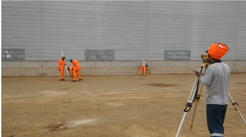
Figura 5. Trazo y replanteo topográfico durante la ejecución del proyecto.
