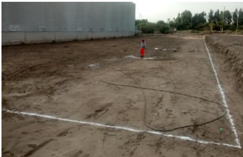
Figura 4. Replanteo topográfico al inicio de la ejecución del proyecto.
