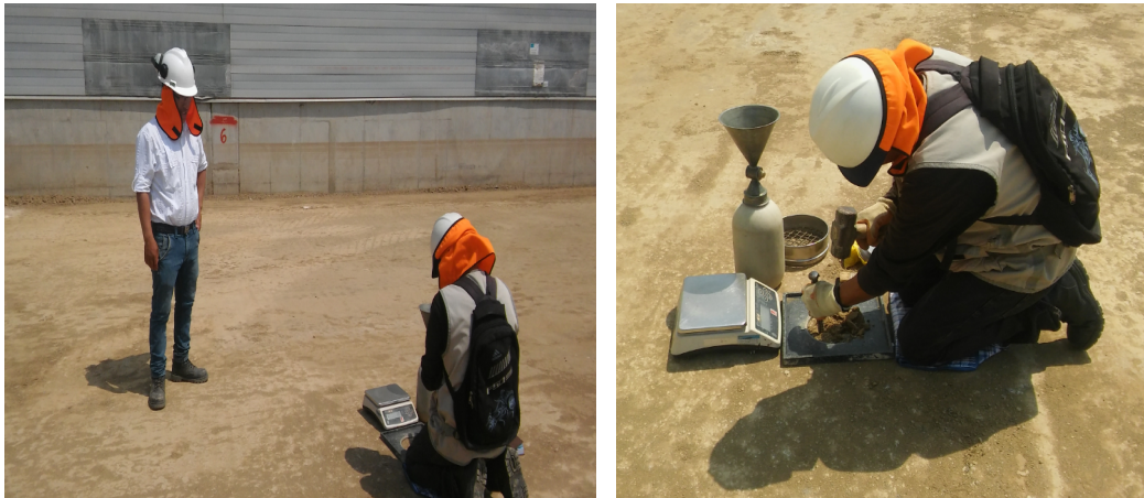
Figura 8. Verificación de la compactación mediante la densidad de campo.
