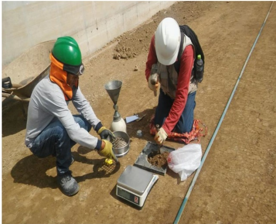
El primer ensayo realizado en la segunda capa de la plataforma que se realizó el día 29 – abril del 2017 con el apoyo de un trabajador
