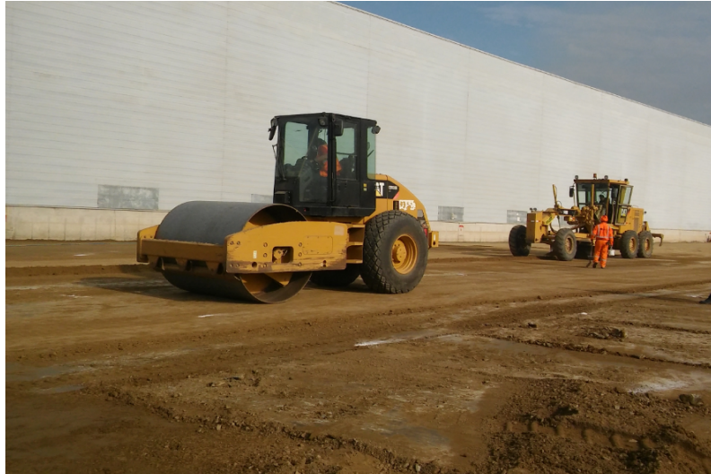
Figura 7. Compactado de material.
