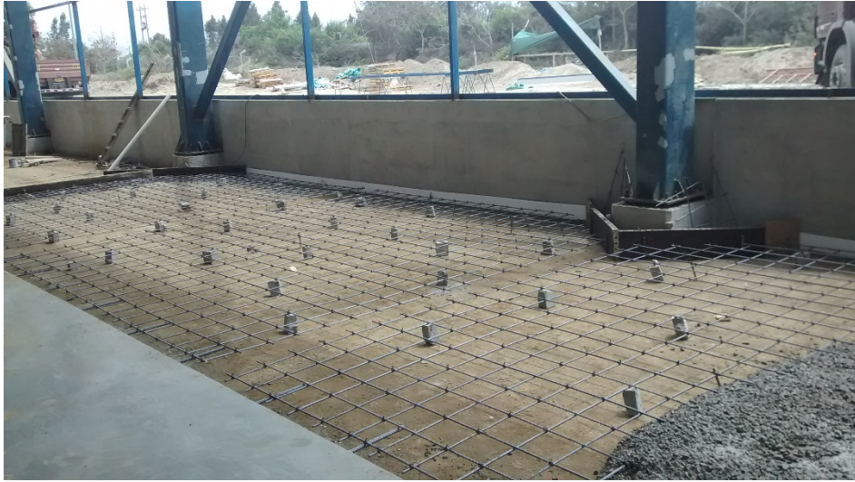
Figura 10. Habilitado y colocación de acero.
