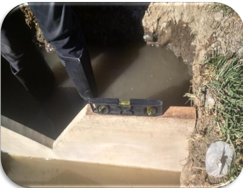
EN LA COLOCACIÓN DEL VERTEDERO TRIANGULAR SE OBSERVA QUE ESTA BIEN NIVELADO, HACIENDO USO DE L NIVEL TUBULAR Y SEGUIR CON EL TRABAJO EN CAMPO.
