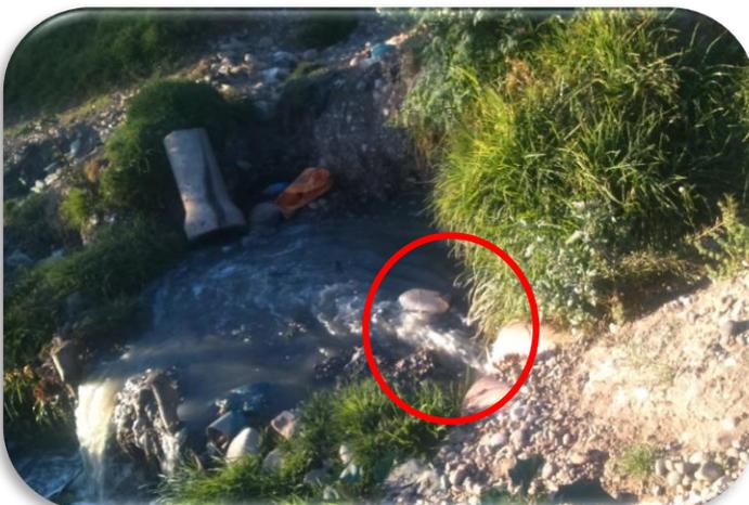
DESEMBOCADURA DEL AGUA RESIDUAL EN EL ANEXO DE AUQUIMARCA DONDE SE OBSERVA LA SALIDA DEL DESAGUE MEDIANTE UN TUBO DE 8 PULGADAS DE PVC.
