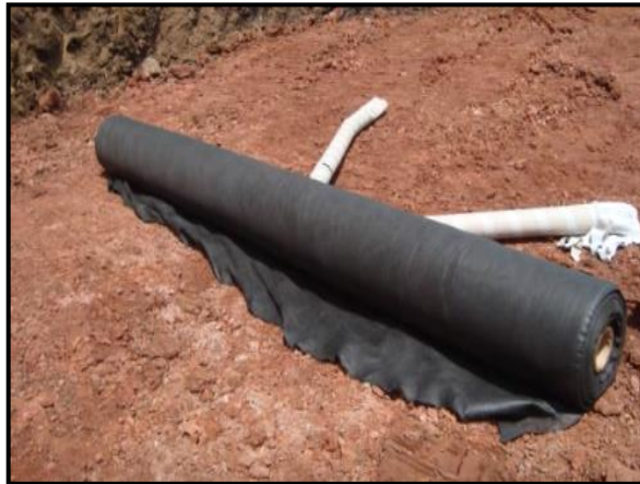
Figura 22: Colocación del geotextil tipo NW024.
