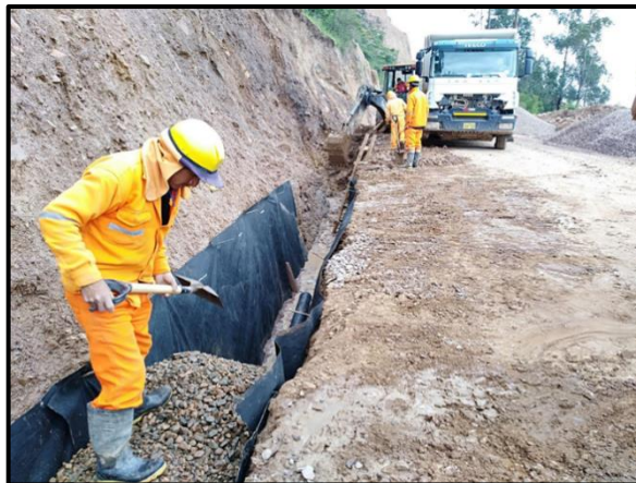
Figura 23: Colocación del material drenante.
