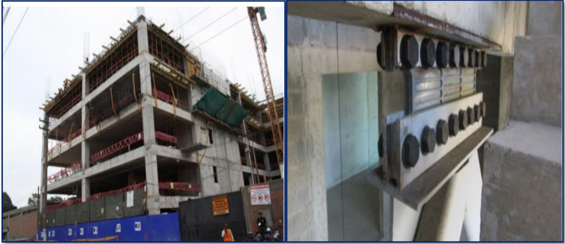
Figura 2.29: Fabrica NETTALCO (PERÚ ,2015), con Disipadores Metálicos Fuente: http://luisbozzo.com/wpcontent/uploads/2018/05/Dossier_disipadores_2017_V6.pdf
