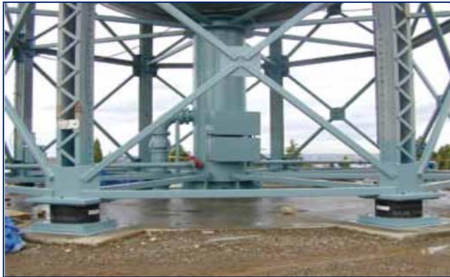
Figura 2.8: Aplicación de Apoyo Elastomérico en Tanque de Agua – EE. UU Fuente: Documento Técnico N° 29 -Cámara Chilena de la Construcción,2011
