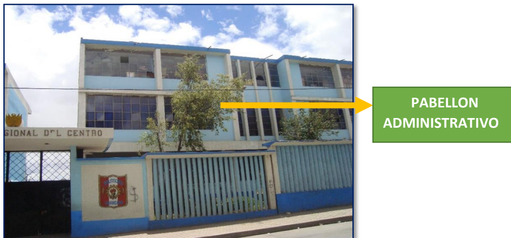
Figura 4.2: Fachada principal ubicada en la Av. Alejandro Deustua (ELTAMBO) Fuente: Expediente Técnico del Proyecto “MEJORAMIENTO INTEGRAL DEL SERVICIO EDUCATIVO DE LA I.E.P. POLITECNICO REGIONAL DEL CENTRO EL TAMBO-HUANCAYO”
