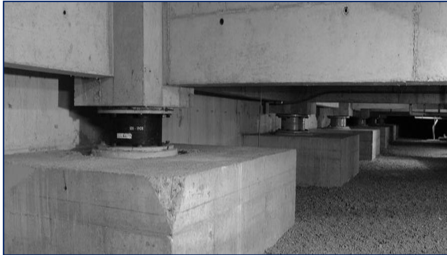
Figura 2.6: Aislador Elastomérico Edificio San Agustín -CHILE Fuente: Documento Técnico N° 29 -Cámara Chilena de la Construcción,2011
