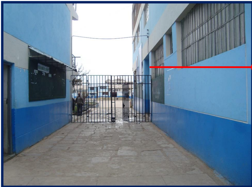
VISTA LATERAL DEL PABELLON ADMINISTRATIVO
