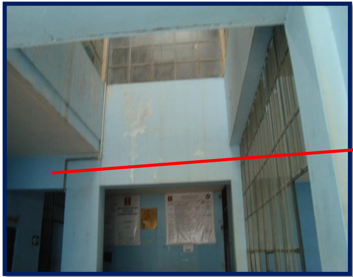
VIGAS PRINCIPALES 45 cm X 90 cm EN LA DIRECCION XX
