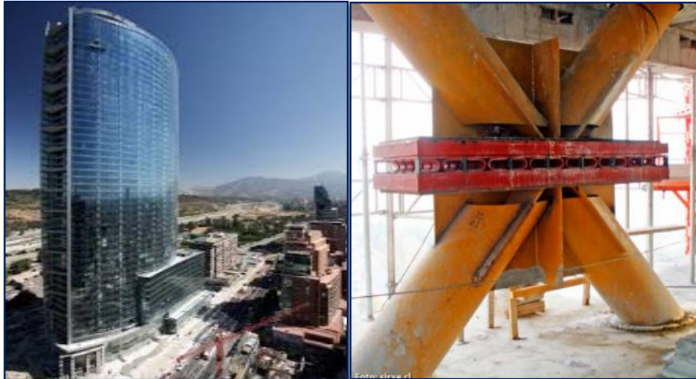
Figura 2.32: Disipador Friccionante Aplicada en la Torre TITANIUM, (CHILE) Fuente: Seismic Protection Technologies (SIRVE,2010)
