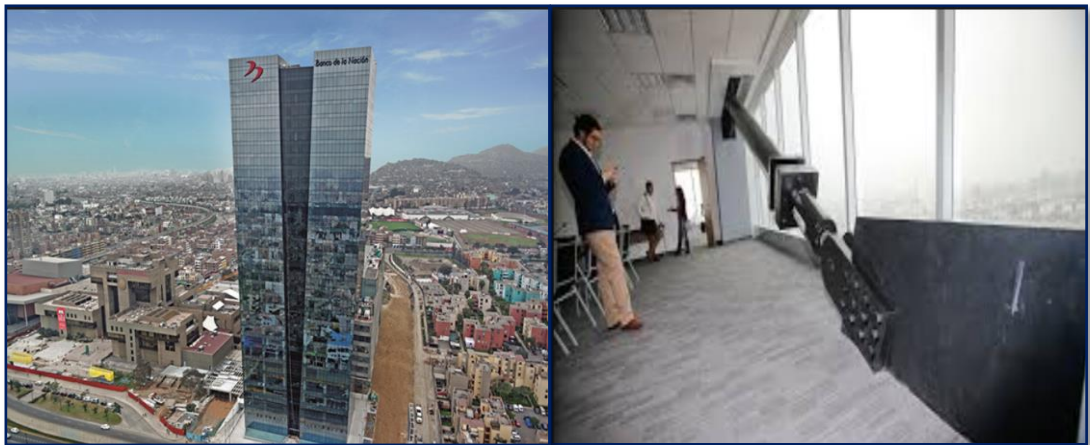
Figura 2.34: Nueva Sede BANCO DE LA NACION (PERÚ ,2015), con sistemas de protección Sísmica mediante los Disipadores tipo fluido Viscoso Fuente: https://cdvperu.com/nuestrosproyectos/
