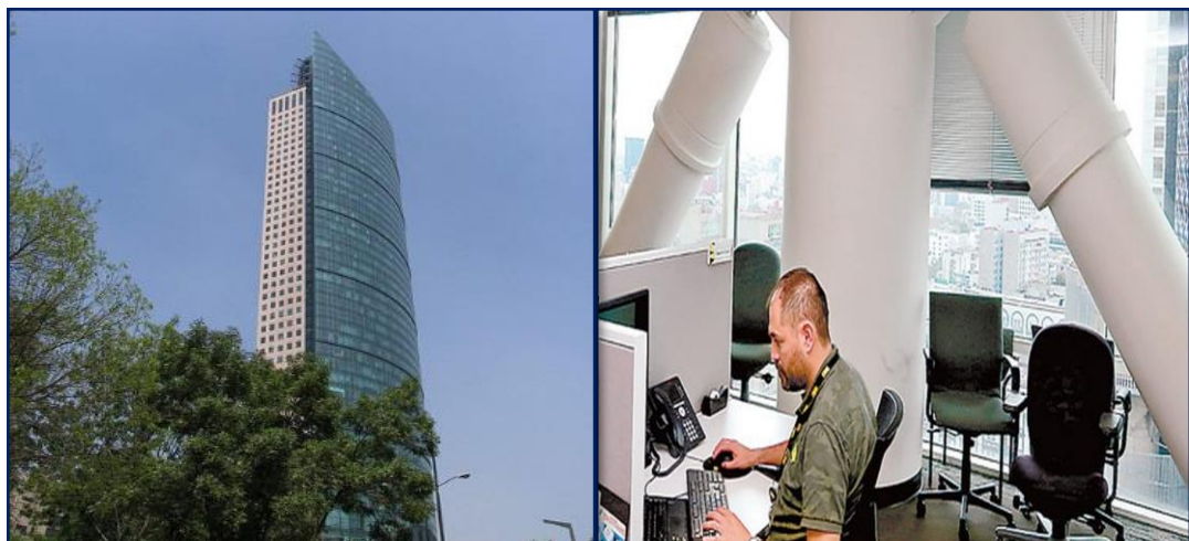
Figura 2.35: Edificio TORRE MAYOR (MÉXICO), 55 pisos uno de los más importantes del mundo, implementada con 98 Disipadores tipo fluido Viscoso Fuente: https://cdvperu.com/nuestrosproyectos/
