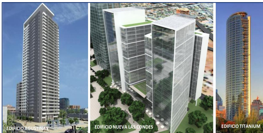
Figura 2.12: Edificios Protegidos con Disipación de Energía de SIRVE S.A, CHILE Fuente: Seismic Protection Technologies (SIRVE,2010)
