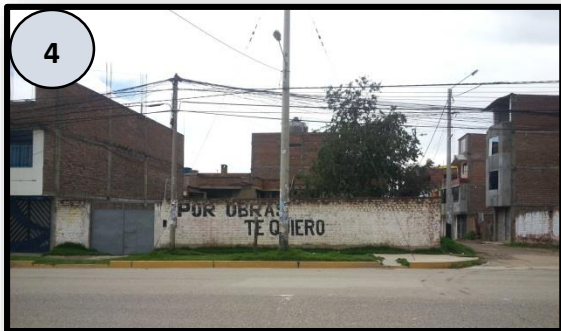
VISTA POR EL OESTE
