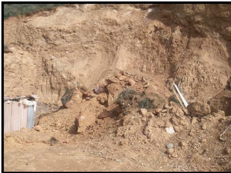
La fotografía muestra el deslizamiento de tierra.
