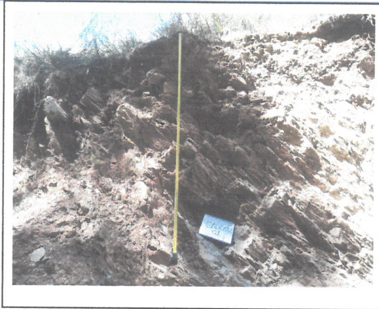
FOTO 01.- UBICACIÓN DE LA CALICATA C-01 CORRESPONDIENTE AL PROYECTO: “FACTORES INFLUYENTES EN LA ESTABILIDAD DE TALUD PARA EVALUAR EL GRADO DE VULNERABILIDAD”
