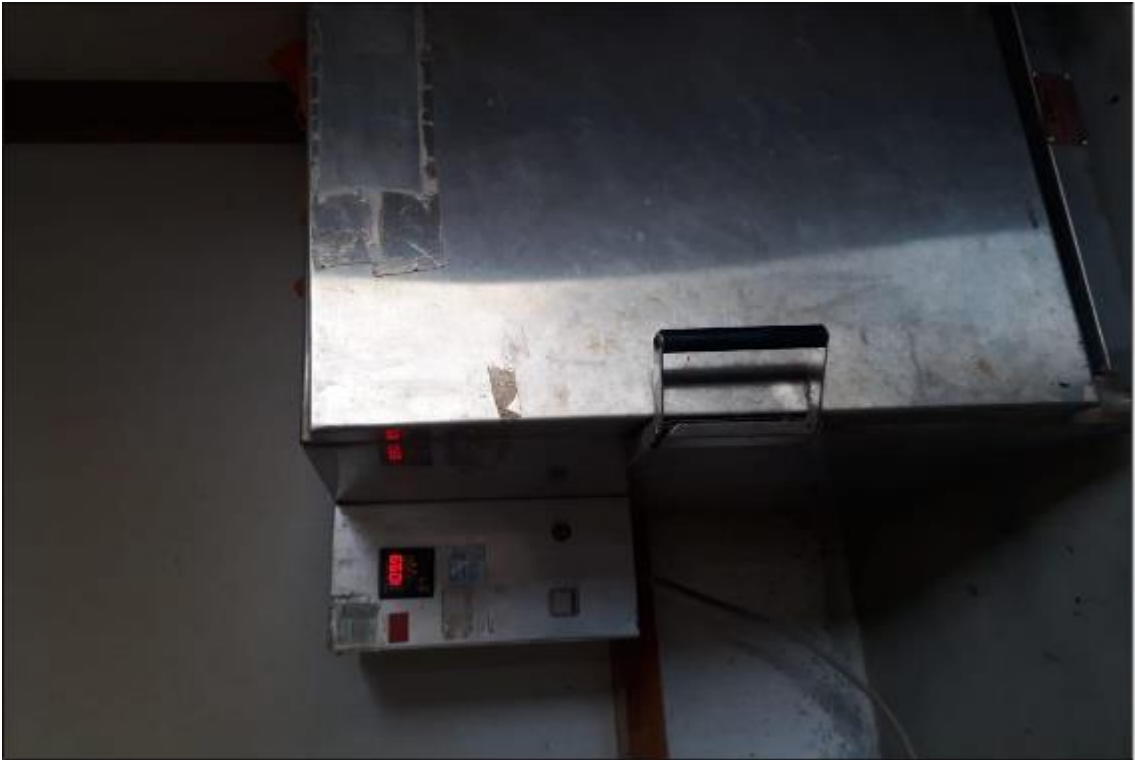
Figura N° 23: Control de temperatura de asfalto
