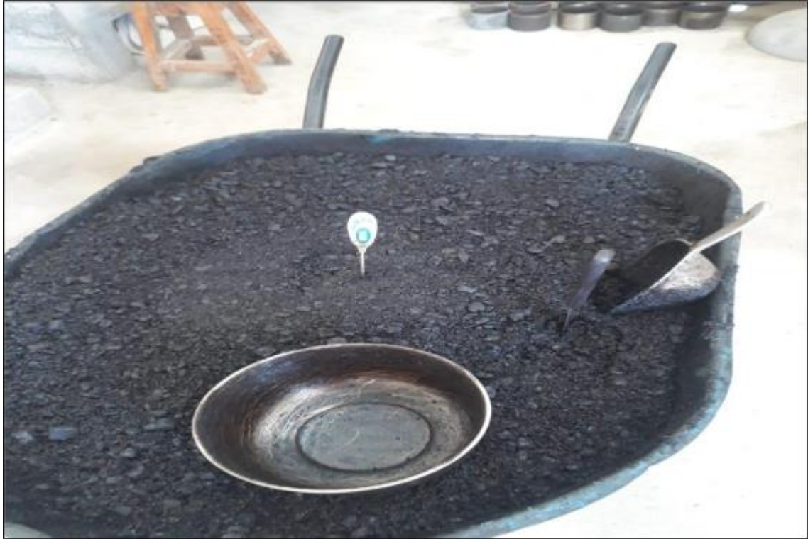
Figura N° 21: Muestreo de mezcla asfáltica y control de temperatura
