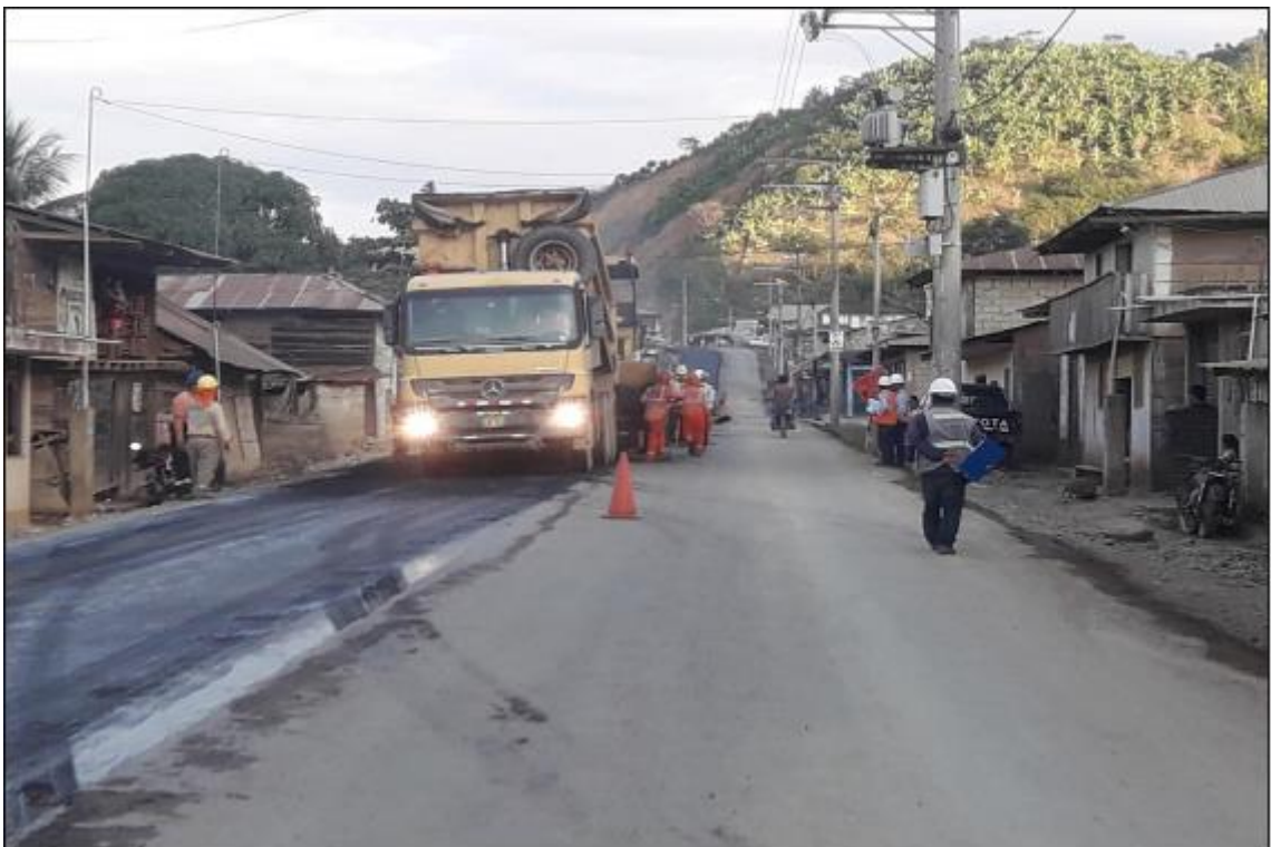
Figura N° 26: Colocación del asfalto producido con material de la cantera Satipo
