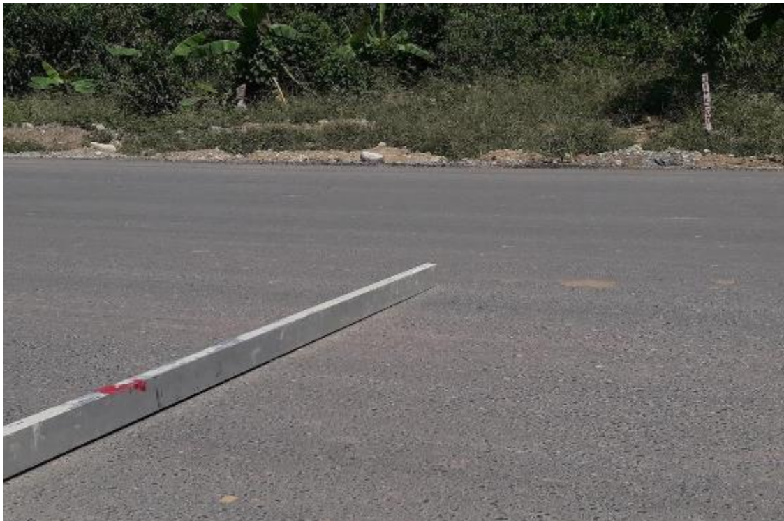
Figura N° 28: Ensayo de lisura, verificación de la uniformidad de la colocación del asfalto.
