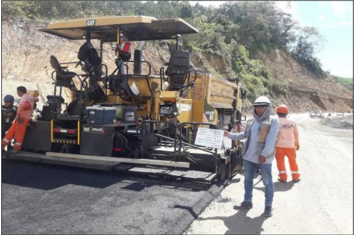
Figura N° 27: Colocación del asfalto producido con material de la cantera Satipo
