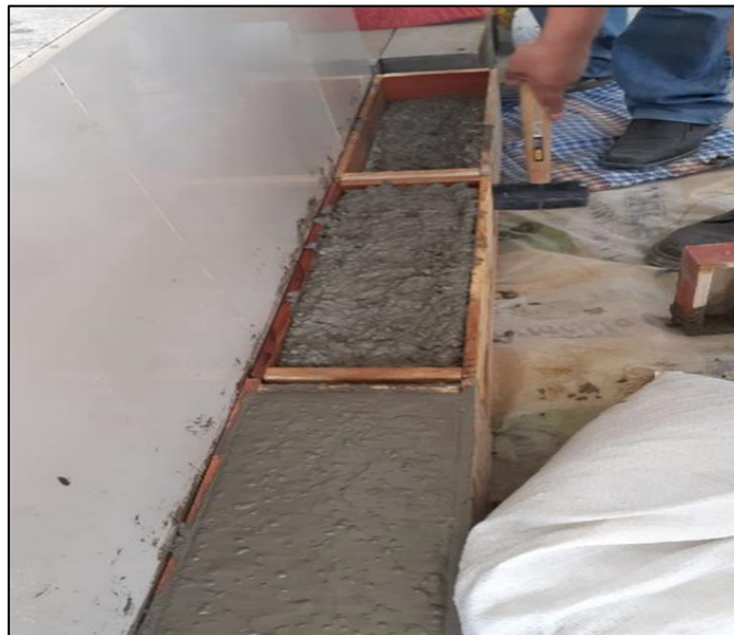
Figura 23. Elaboración de vigas de concreto
