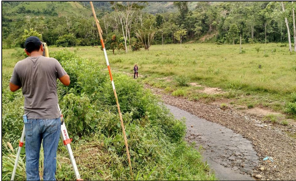
Fotografía 5. Reconocimiento de la zona de alcantarilla
