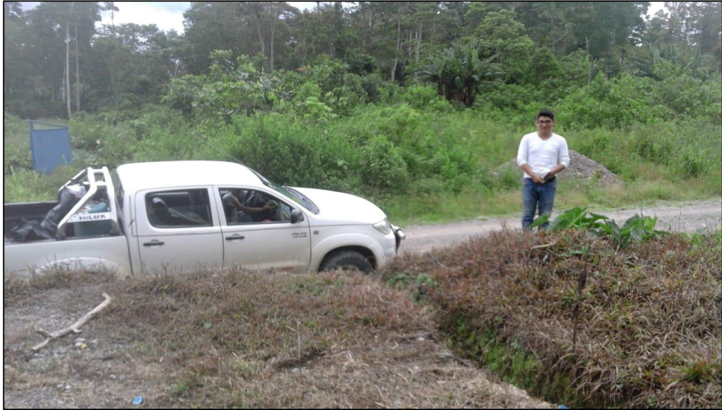
Fotografía 9. Corte de Talud
