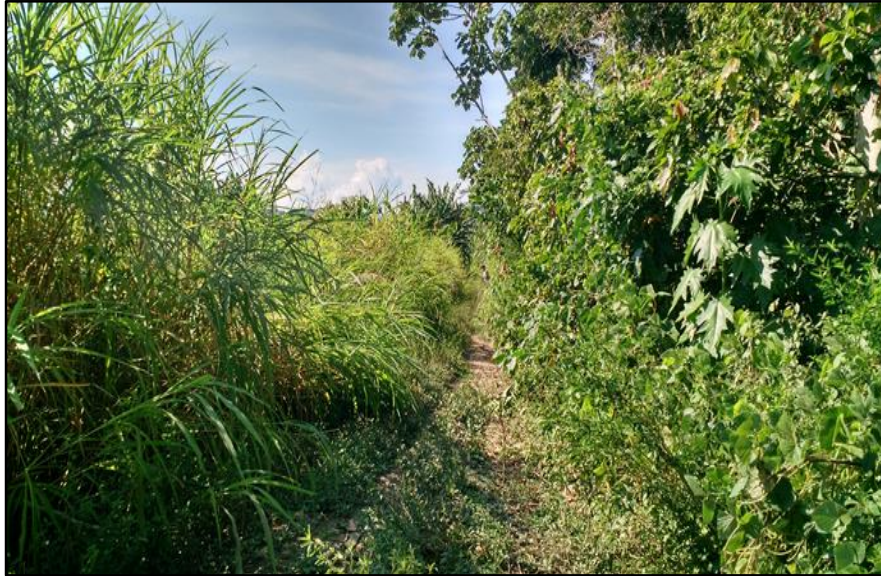
Fotografía 3. Estado actual de la vía
