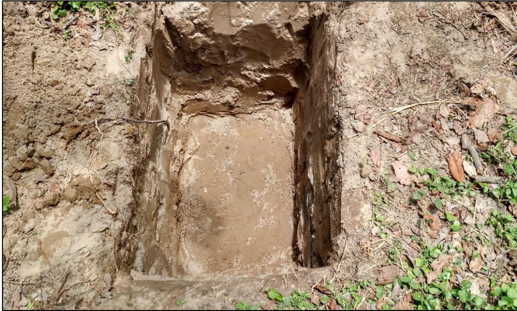
Fotografía 7. Estudio de mecánica de suelos
