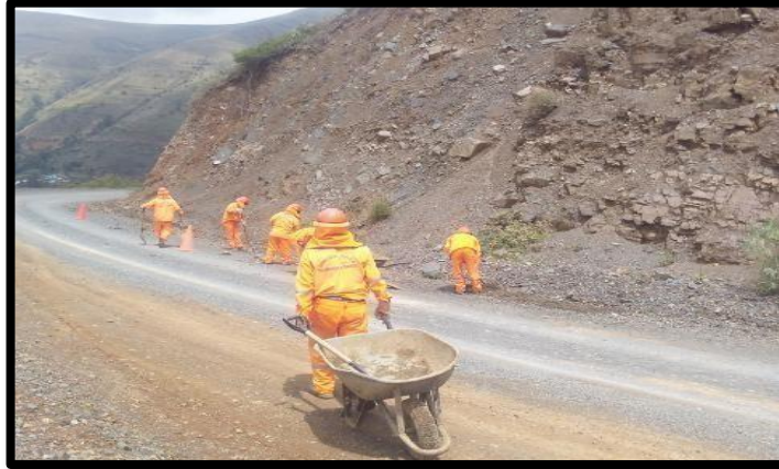
LIMPIEZA DE PLATAFORMA TRAMO PARIACC-PUTACCA KM 0+800
