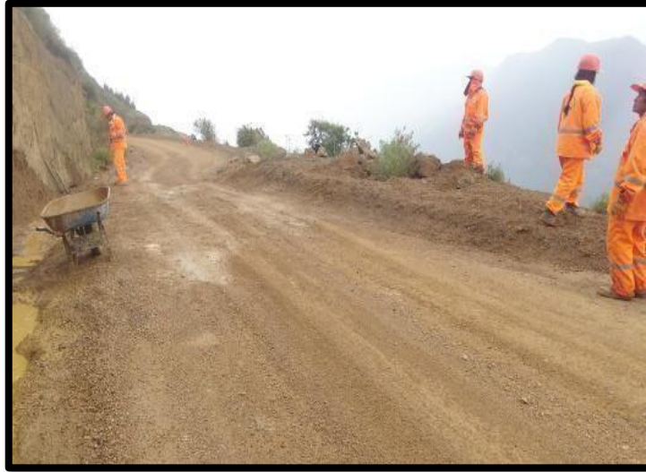
REMOCION DE PEQUEÑOS DERRUMBES KM 4+350 TRAMO PARIACC - PUTACCA
