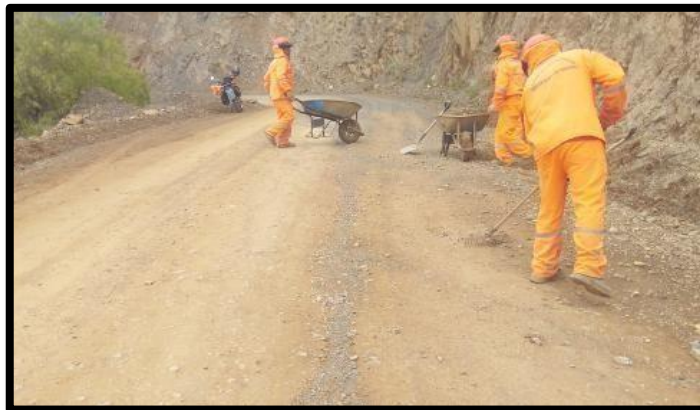
LIMPIEZA DE PLATAFORMA TRAMO PARIACC-PUTACCA KM 5+800
