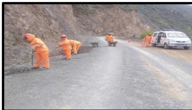
LIMPIEZA DE PLATAFORMA TRAMO PARIACC-PUTACCA KM 8+800
