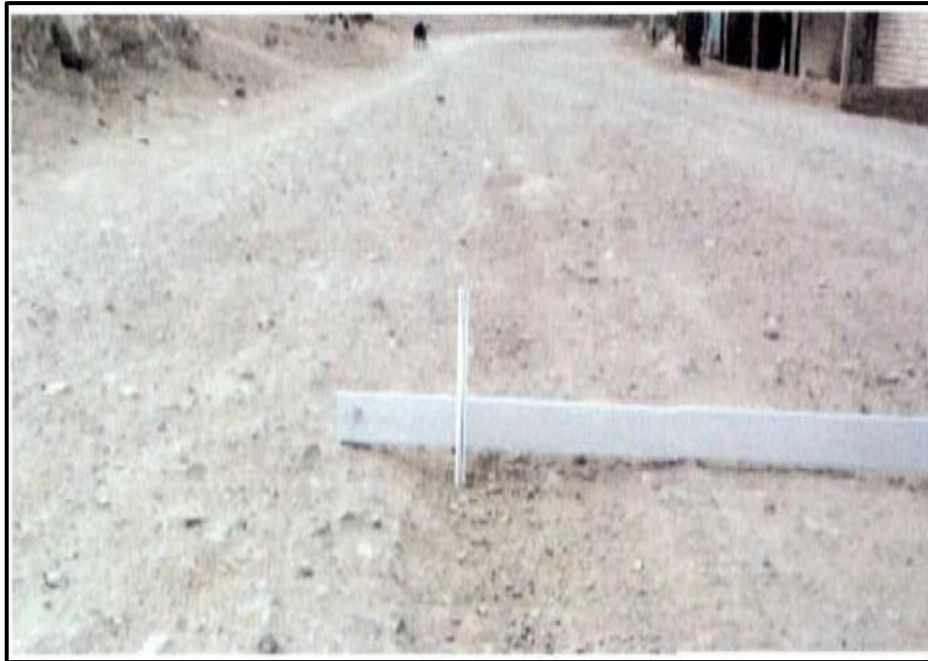
Figura 2: Huellas / hundimientos perceptibles al usuario, pero < 5 cm Fuente: "Manual de carreteras Mantenimiento o Conservación vial 2018"
