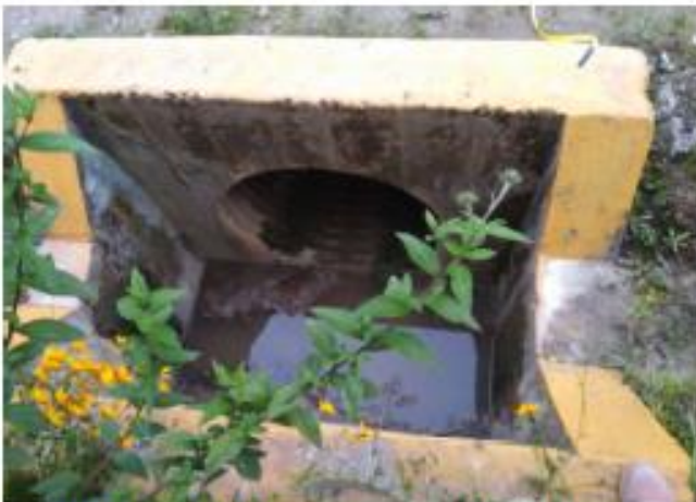
foto 021: Alcantarilla tipo TMC de \varnothing 36" Km: 3+860
