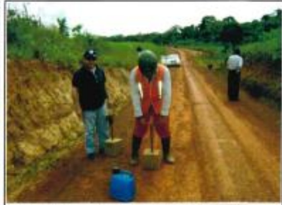
foto 02: Compactación de Baches (Bacheo), en un Mantenimiento Rutinario.
