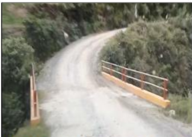
Foto 041: Puente Entrada a Huaripampa progresiva 7+600
