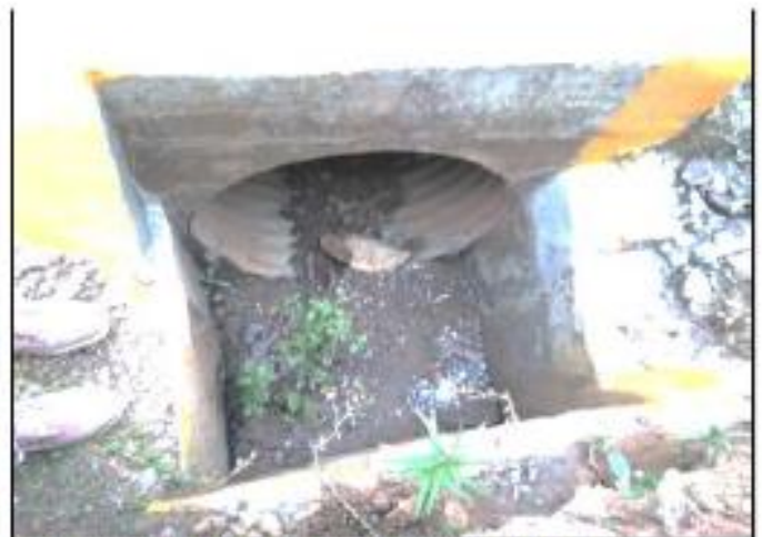
foto 036: Alcantarilla tipo TMC de Ø 36" Km: 6+560
