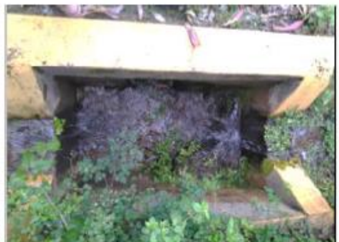
Foto 054: Alcantarilla tipo TMC de \varnothing 36"; Km: 10+980
