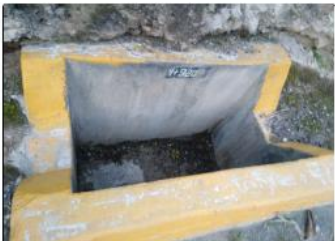
Foto 029: Alcantarilla tipo TMC de \varnothing 36" Km: 4+920
