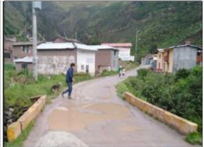
Foto 044: Pontón Huaripampa L=6.15m
