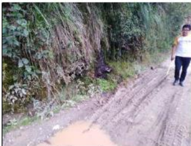
Foto 057: Lodazal en la progresiva 11+070
