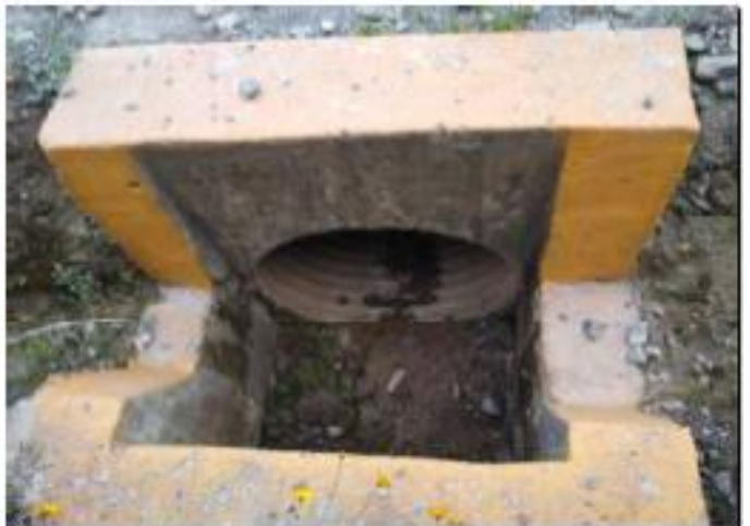
foto 028: Alcantarilla tipo TMC de \varnothing 36" Km: 4+520
