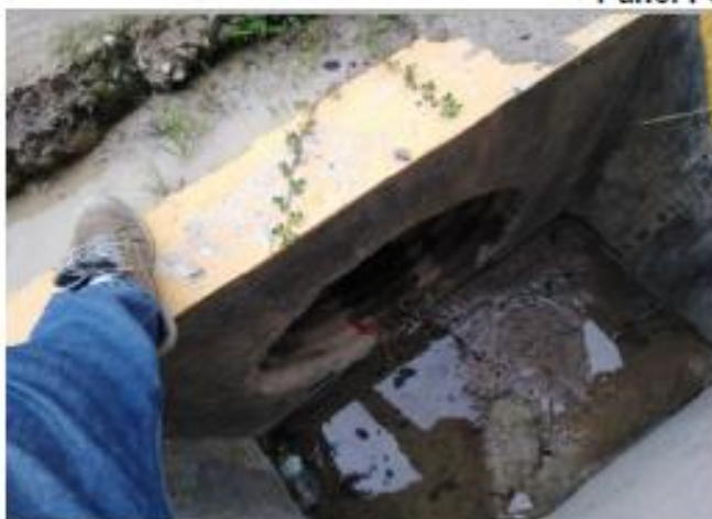
Foto 073: Alcantarilla tipo TMC de \varnothing 36"; Km: 13+500
