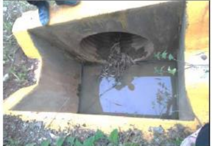
foto 032: Alcantarilla tipo TMC de Ø 36" Km: 5+680
