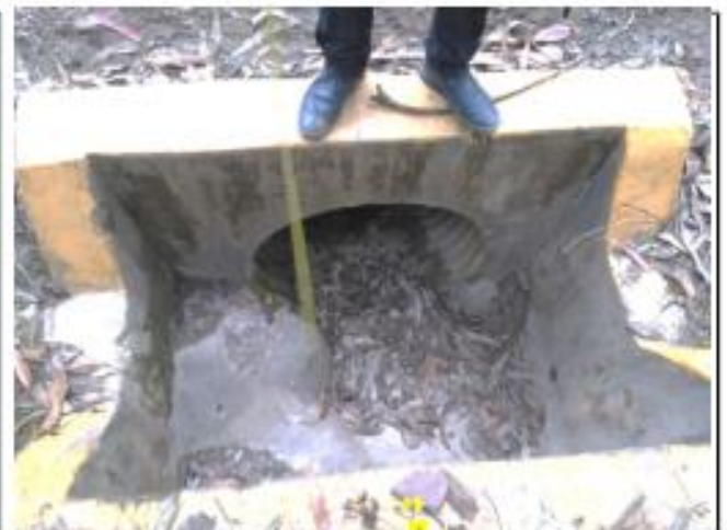
Foto 046: Alcantarilla tipo TMC de \varnothing 36"; Km: 9+340
