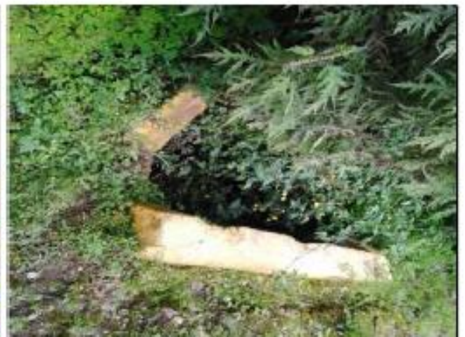
Foto 066: Alcantarilla tipo TMC de Ø 36"; Km: 12+370
