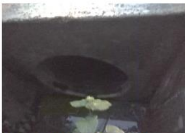
foto 005: Alcantarilla tipo TMC de Ø 36" Km: 0+700
