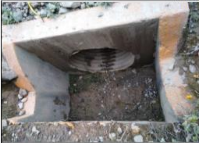
foto 019: Alcantarilla tipo TMC de \varnothing 36" Km: 3+195
