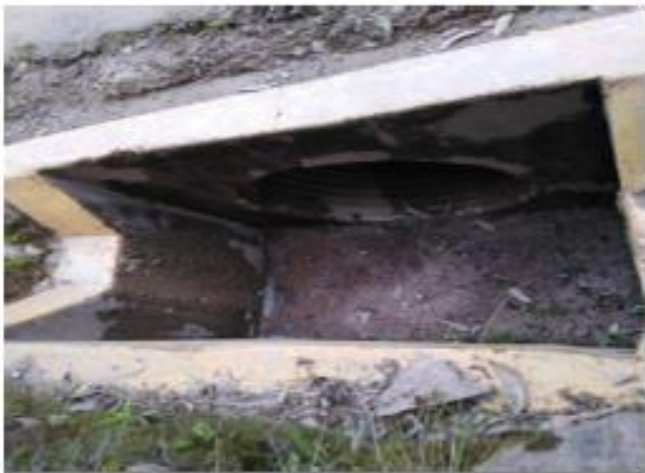
Foto 051: Alcantarilla tipo TMC de \varnothing 36"; Km: 10+450
