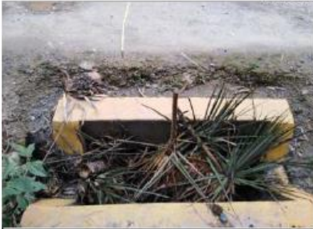
Foto 049: F Alcantarilla tipo TMC de \varnothing 36"; Km: 9+950
