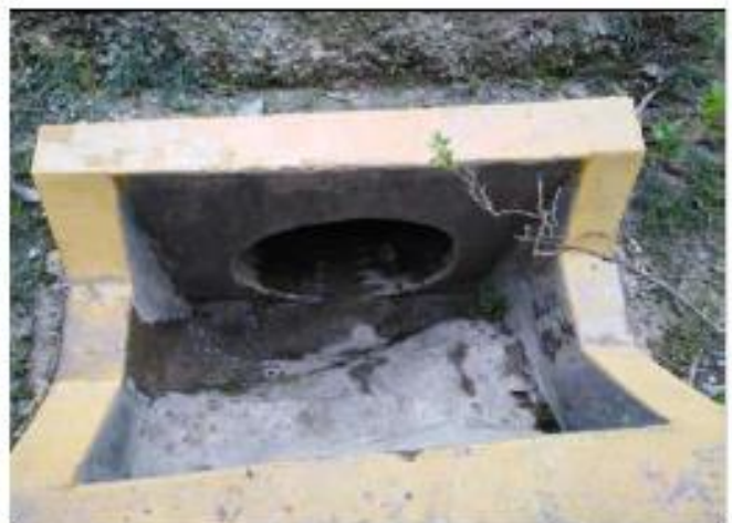
Foto 052: Alcantarilla tipo TMC de \varnothing 36"; Km: 10+840
