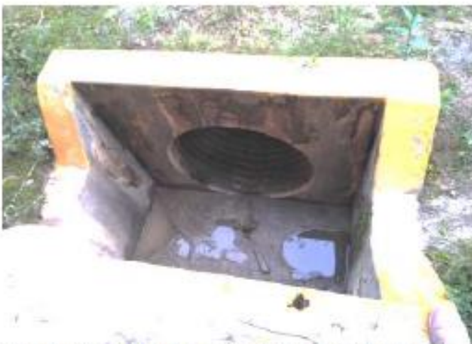
Foto 035: Alcantarilla tipo TMC de Ø 36" Km: 6+275
