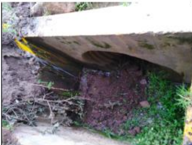
Foto 065: Alcantarilla tipo TMC de Ø 36"; Km: 12+220
