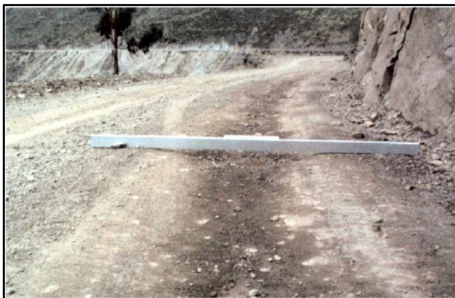
Figura 4: Huellas/ hundimientos \geq 10 cm
