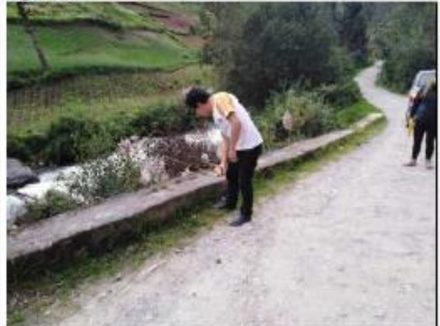
Foto 056: Muro de contención 20x0.85x1.85m en la progresiva 11+030
