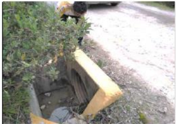
Foto 094: Alcantarilla tipo TMC de \phi 36"; Km: 15+650
