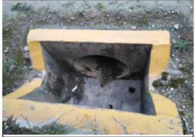
foto 026: Alcantarilla tipo TMC de \varnothing 36" Km: 4+220
