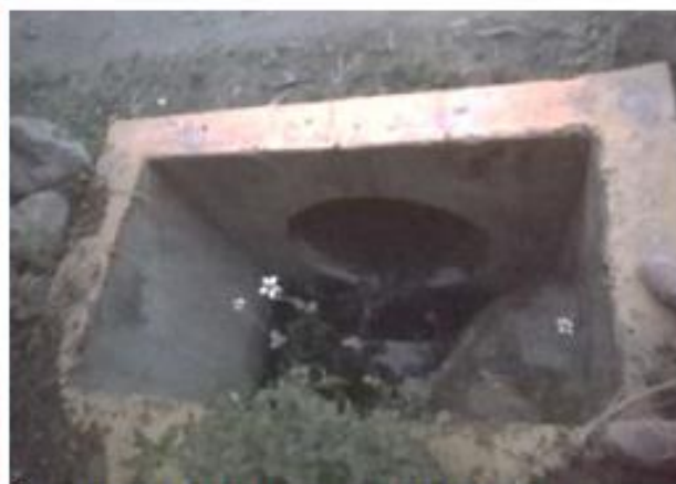
foto 004: Alcantarilla tipo TMC de Ø 24" Km: 0+640
