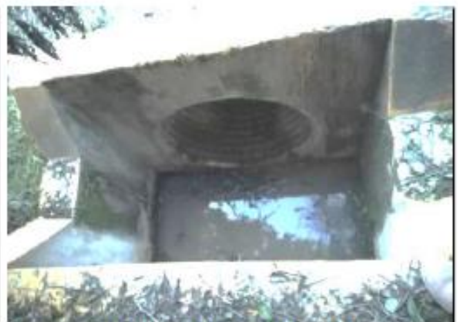
Foto 012: Alcantarilla tipo TMC de \varnothing 36" Km: 1+720
