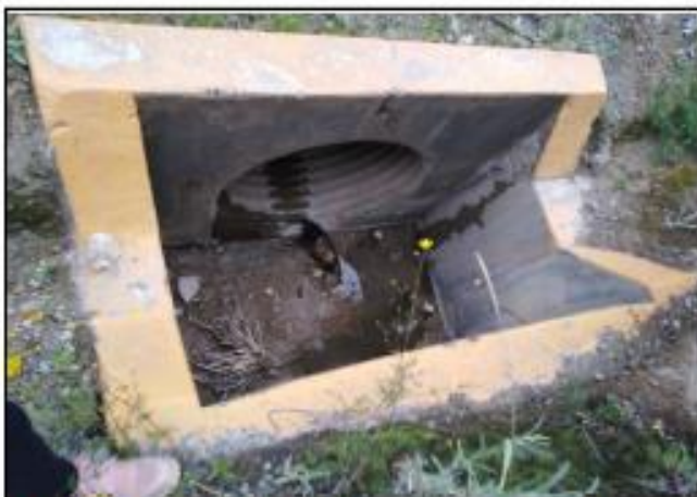
Foto 039: Alcantarilla tipo TMC de \varnothing 36"; Km: 7+065
