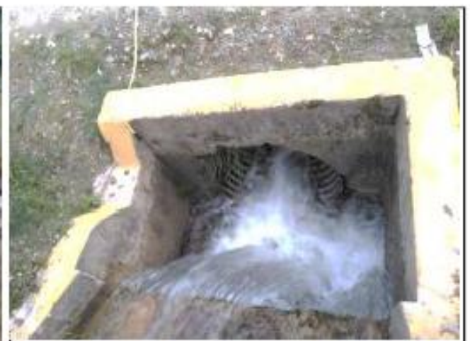
Foto 048: Alcantarilla tipo TMC de \varnothing 36"; Km: 9+880
