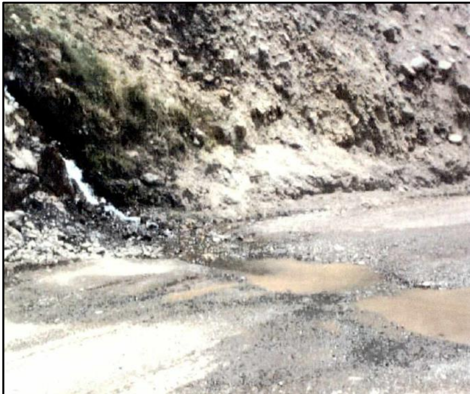
Figura 13: Cruce De Agua
