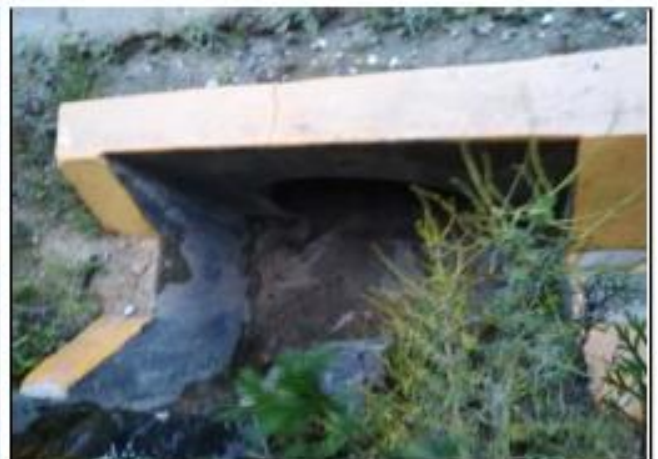
Foto 016: Alcantarilla tipo TMC de Ø 36" Km: 2+500
