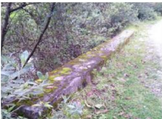
Foto 053: Muro de contención de 10m x 0.50m; Km: 10+890
