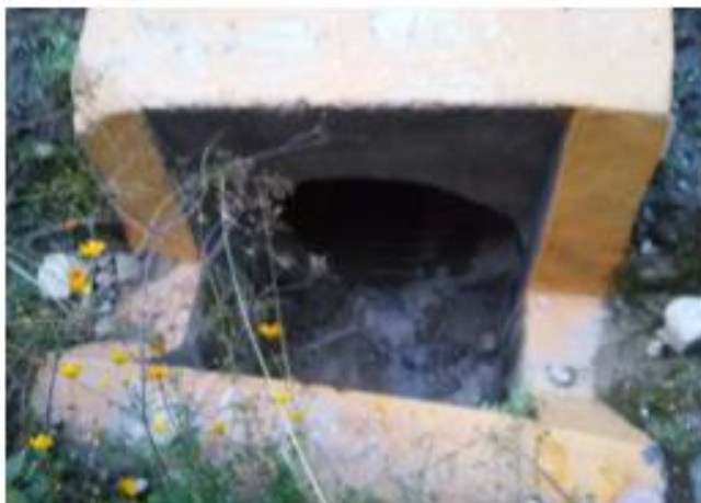
Foto 015: Alcantarilla tipo TMC de Ø 36" Km: 2+170
