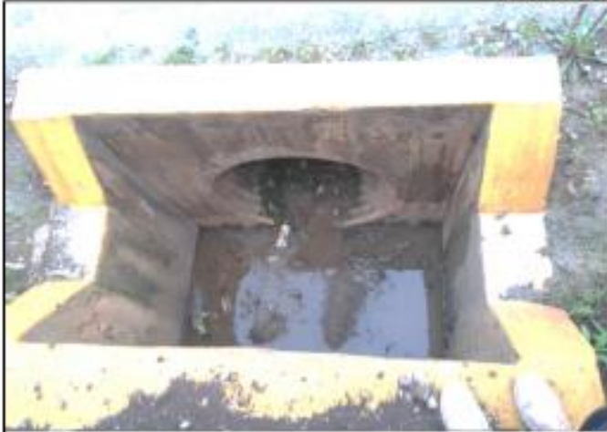
Foto 031: Alcantarilla tipo TMC de Ø 36" Km: 5+400
