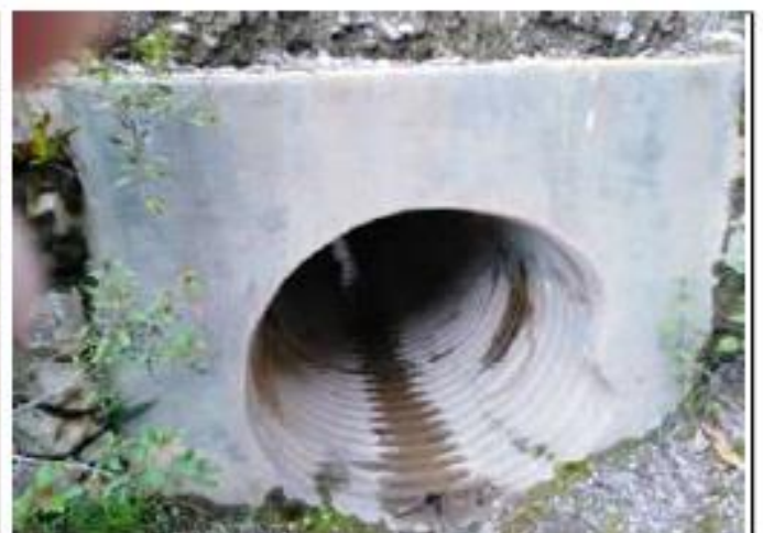
Foto 084: Alcantarilla tipo TMC de Ø 36"; Km: 14+320
