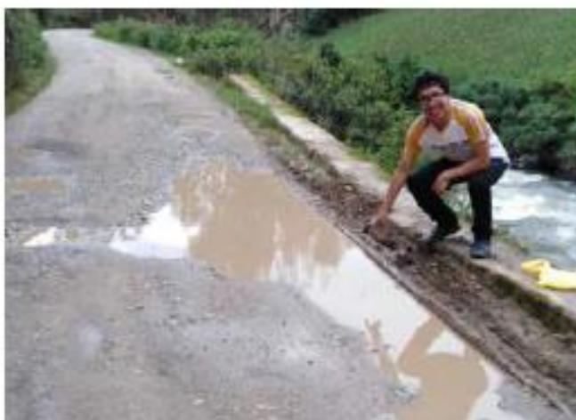
Foto 077: Muro de contención de 25.40 x 0.5 x 2.35m en la progresiva 13+840
