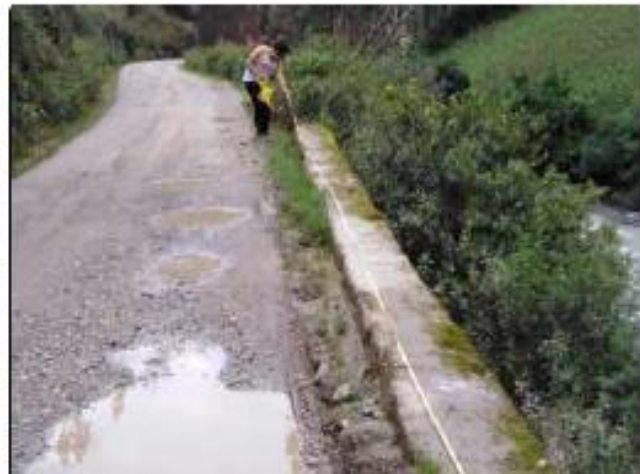
Foto 072: Muro de contención 20.10 x 0.50x 2.25m en la progresiva 13+450
