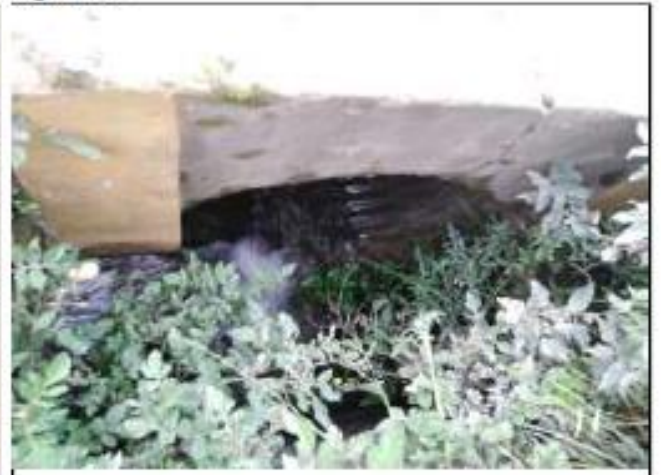
Foto 062: Alcantarilla tipo TMC de Ø 36"; Km: 11+710
