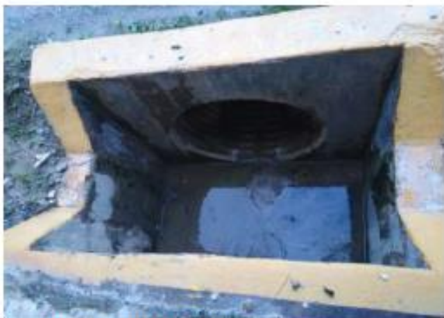
Foto 017: Alcantarilla tipo TMC de Ø 36" Km: 2+850
