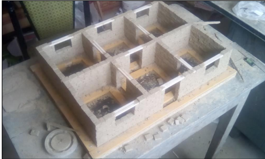
Figura 15. Colocación de dinteles en los vanos.
