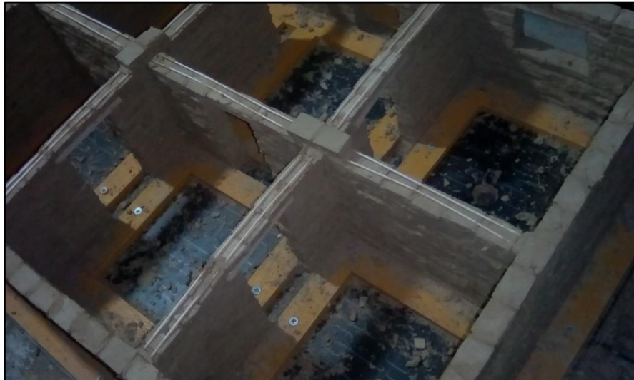
Figura 14. Disposición de refuerzos de madera en los muros.
