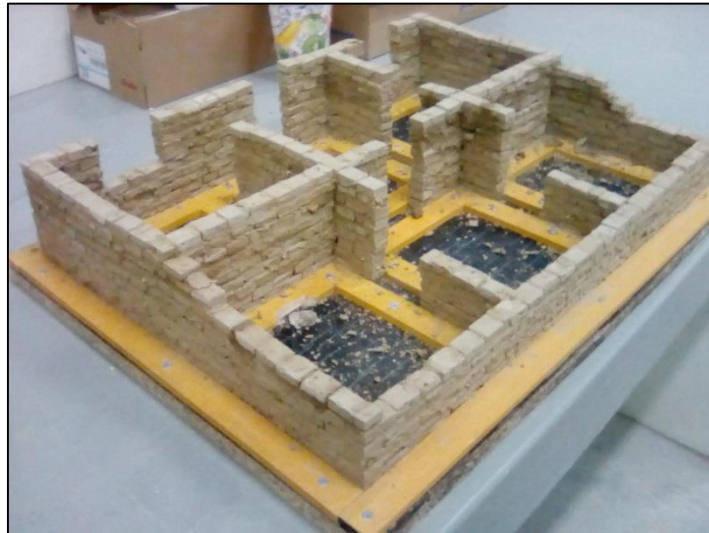
Figura 12. Proceso constructivo de muros.
