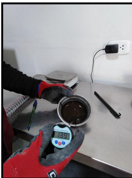
Figura 10: Temperatura de la Emulsión imprimante PRIMETEC Fuente: Fuente propia
