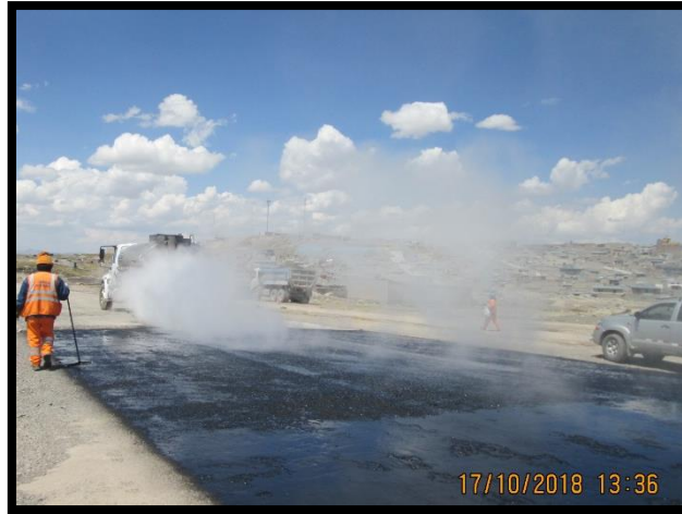
Figura 27: Base granular en obra aplicando el imprimante. Fuente propia
