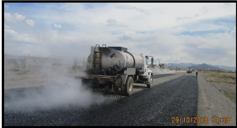
Figura 3: imprimación asfáltica en campo. Fuente: propia
