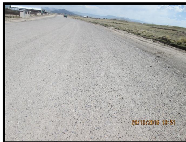
Figura 26: Base granular en obra sin imprimante, barrido y limpiado Fuente propia
