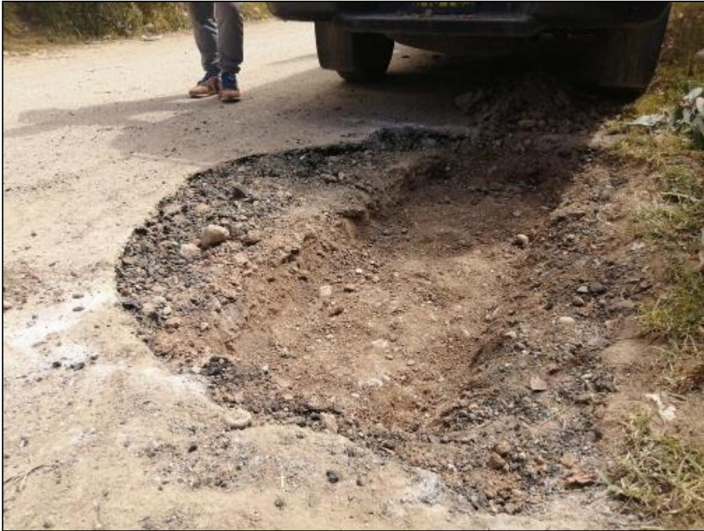
Fotografía 5. Extracción de base granular deteriorada.
