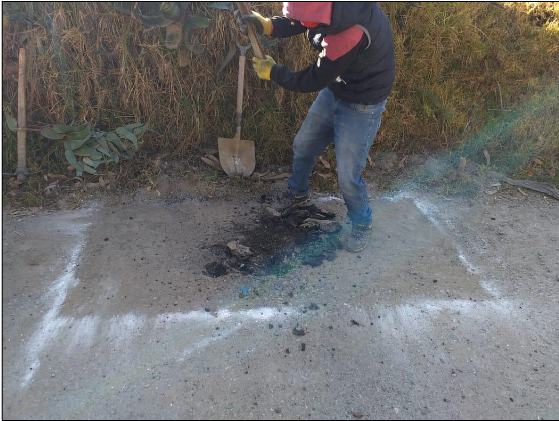
Fotografía 3. Delimitación del área para extraer la carpeta asfáltica y base granular.
