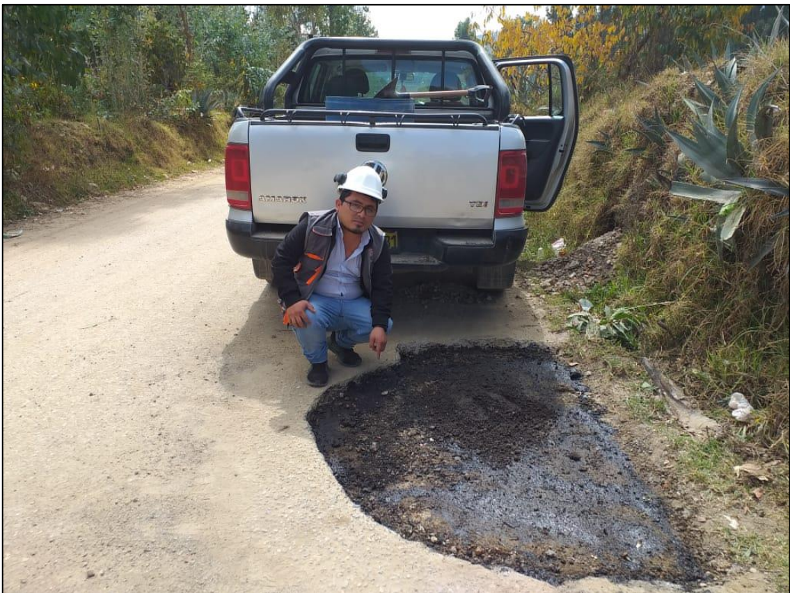
Fotografía 10. Resane del área donde se extrajo la carpeta asfáltica.
