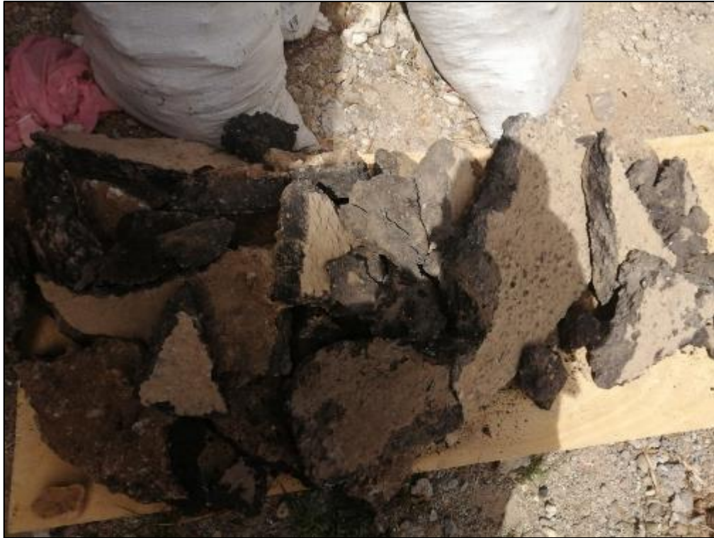
Fotografía 7. Vista de la carpeta asfáltica extraída.
