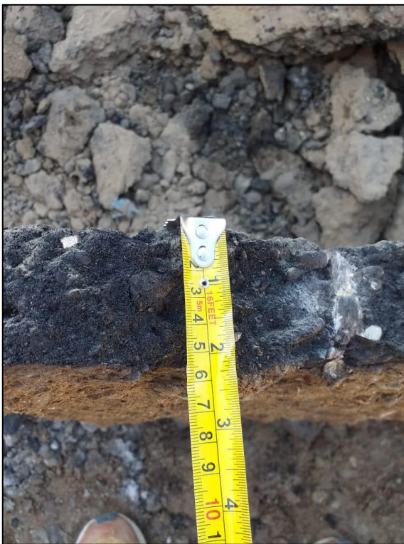
Fotografía 6. Espesor de la carpeta asfáltica existente.
