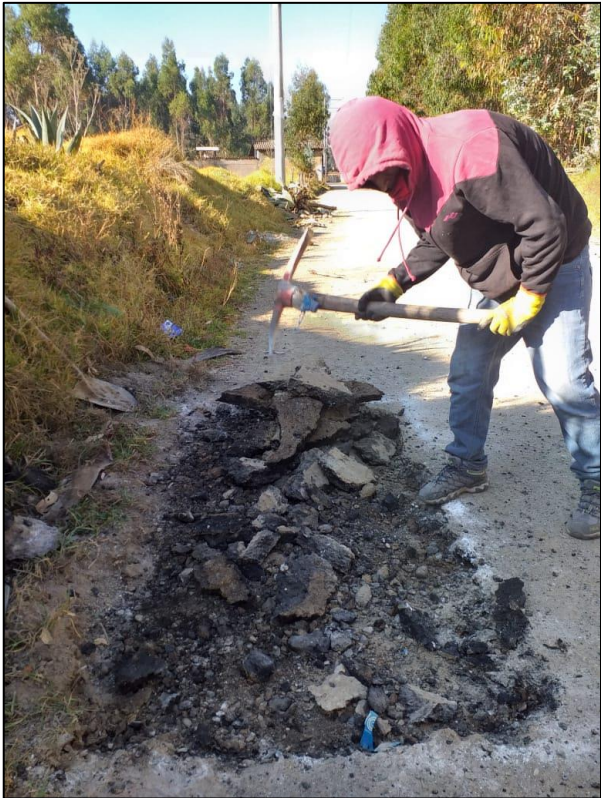
Fotografía 4. Extracción de la carpeta asfáltica.
