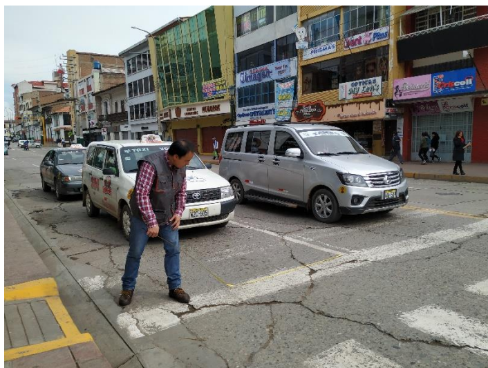
Figura 104. Medición de carriles en la intersección, Loreto y Real
