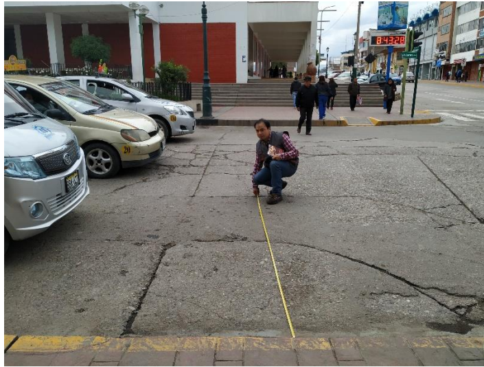
Figura 105. Medición de carriles en la intersección, Loreto y Real
