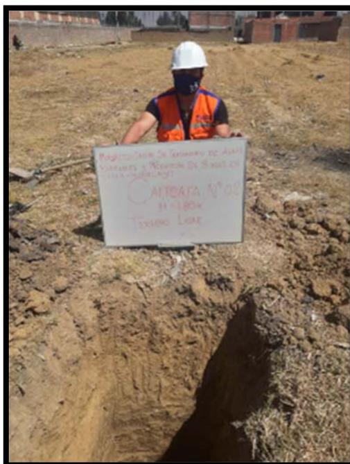
FOTOGRAFIA 02: CALICATA N° 02, TRAMO: Terreno libre (cerca al Jr. Estadio comunal cuadra 01.-PTAR Y BIODIGESTOR.
