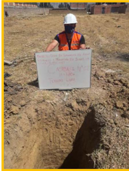
Figura 7: Calicata N° 02, para la construcción de la PTAR.
