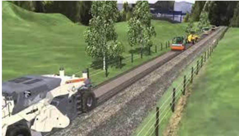
Figura 21. Estabilización del suelo
