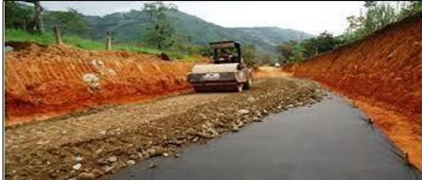
Figura 12. Imagen del afirmado de una sub base
