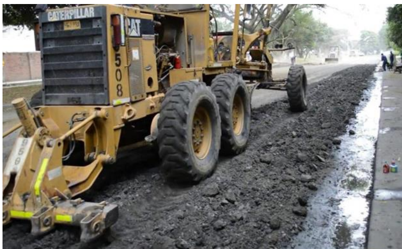
Figura 22. Estabilización del suelo con ceniza
