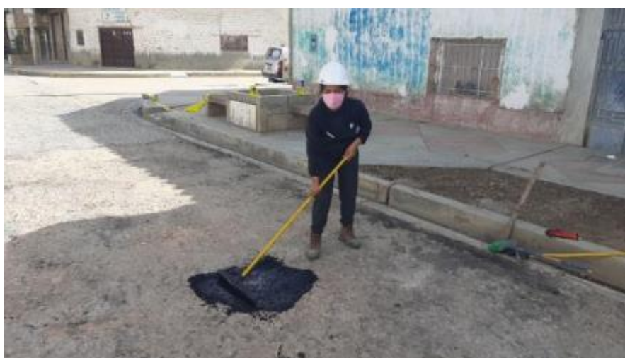
Figura 32 Aplicación y esparcido de la emulsión asfáltica Fuente: Elaboración propia
