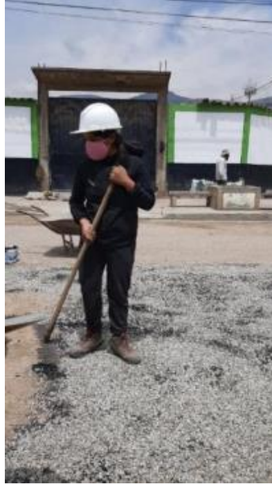
Figura 28 Esparcido del agregado pétreo para los tratamientos superficiales Fuente: Elaboración propia
