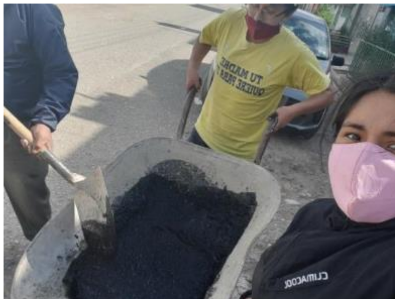
Figura 31 Preparación del mortero asfáltico - slurry seal Fuente: Elaboración propia
