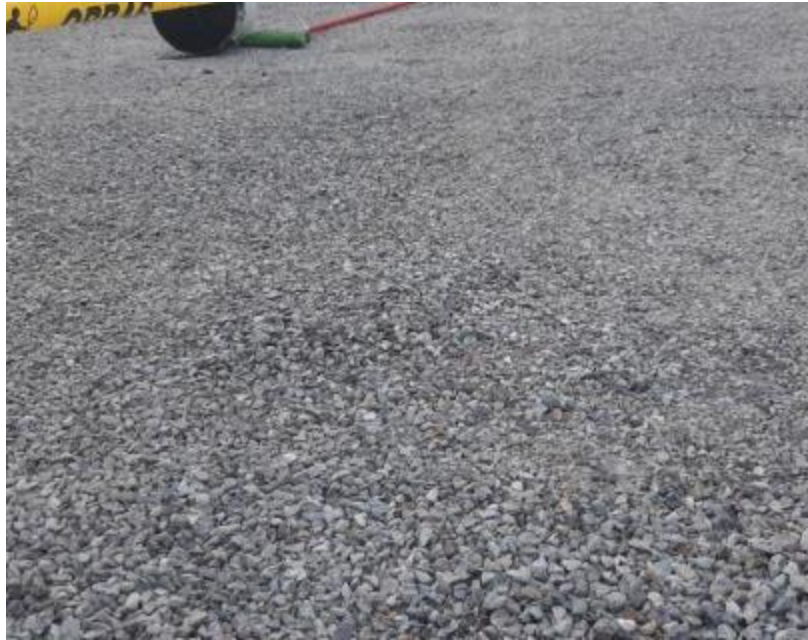
Figura 30 Trabajo final después de la aplicación de los tratamientos superficiales Fuente: Elaboración propia
