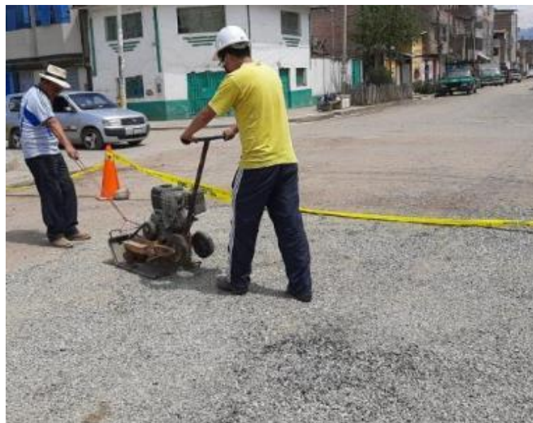
Figura 29 Compactación de los agregados en los tratamientos superficiales Fuente: Elaboración propia
