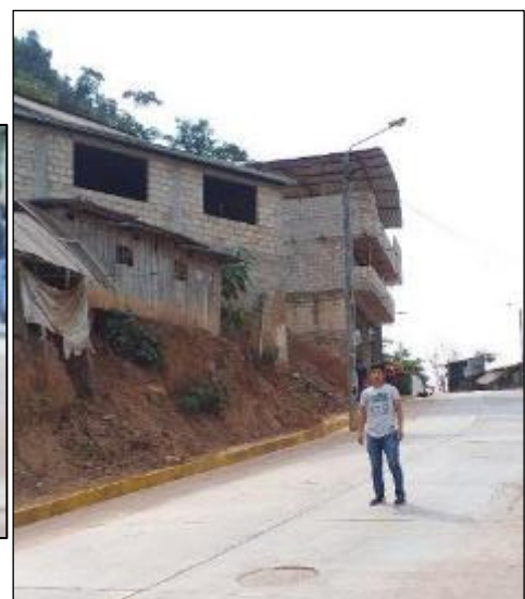
Figura 02: Pavimento rígido concluido el año 2020.
