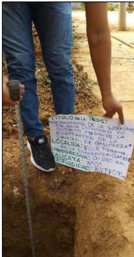
Figura 21: Profundidad de excavación.
