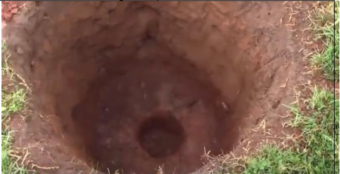
Excavación para la colocación de los Biodigestores
