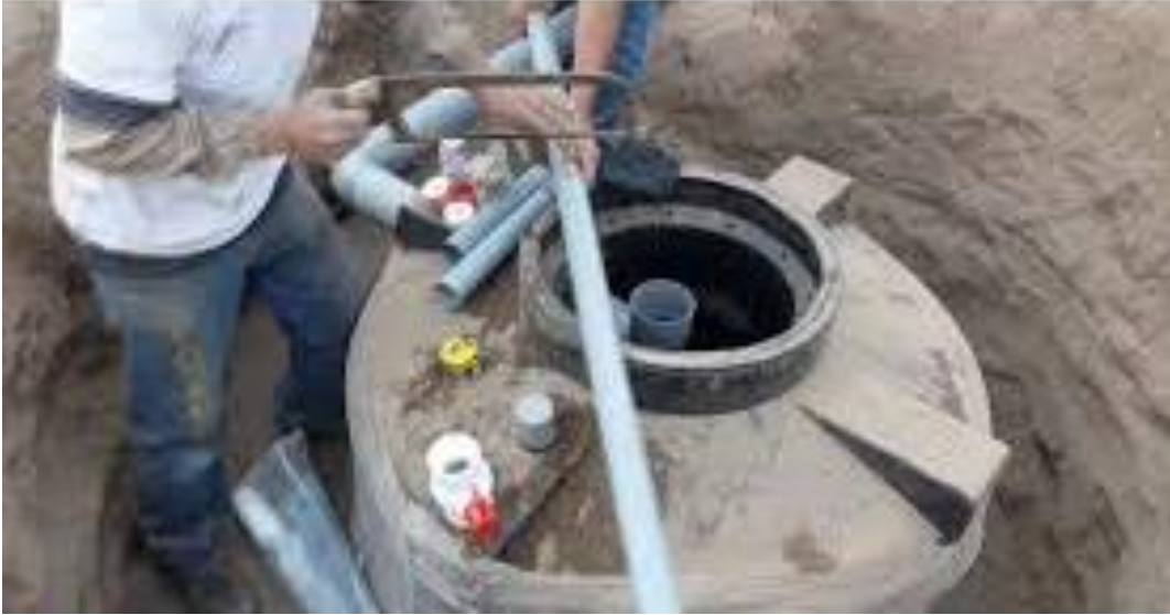
Instalación de conexión al Biodigestor
