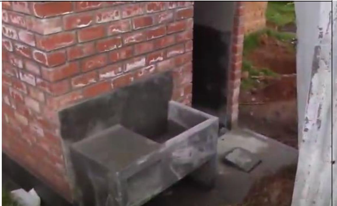
Construcción de los unidades básicas de Saneamiento
