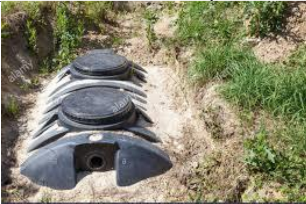
Colocación de los Biodigestores
