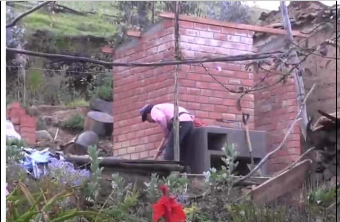
Construcción de los unidades básicas de Saneamiento
