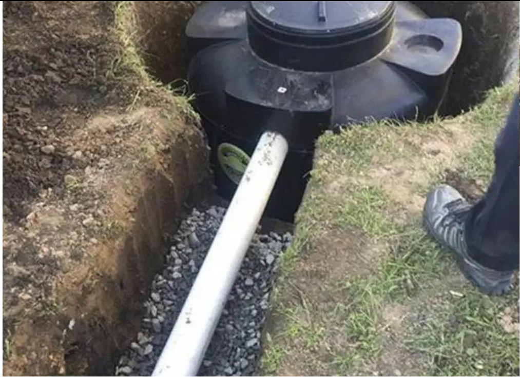
Instalación de conexión al Biodigestor
