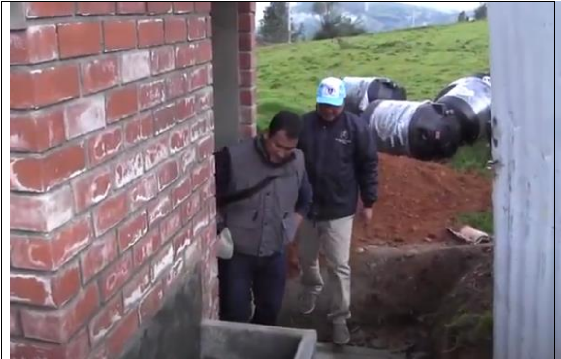
Verificación de las unidades básicas de almacenamiento
