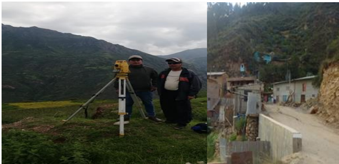
Levantamiento topográfico y control de la pendiente
