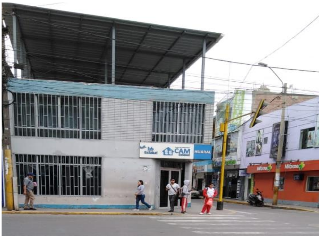
Foto N°6: Centro del Adulto Mayor de Huaral – EsSalud, ubicado en Calle Derecha N° 400, provincia de Huaral, Departamento de Lima.
