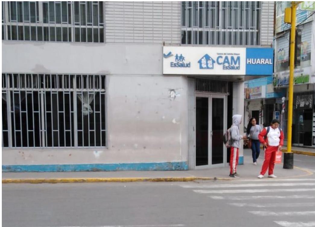
Foto N°7: Centro del Adulto Mayor de Huaral – EsSalud, ubicado en Calle Derecha N° 400, provincia de Huaral, Departamento de Lima.
