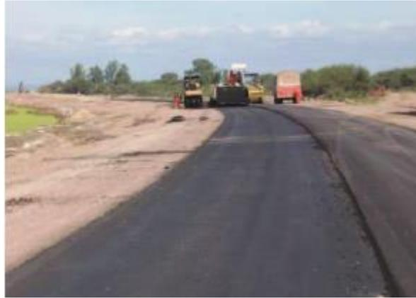
**Figura 19** Recapados Asfálticos
