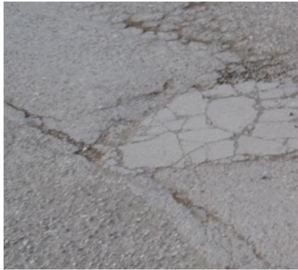
**Figura 11** Falla Grietas Parabólicas
