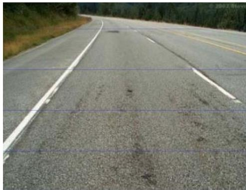
**Figura 12** Falla Meteorización
