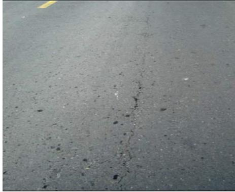
**Figura 7** Falla Grieta Longitudinal
