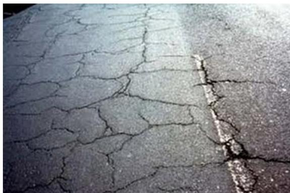
**Figura 4** Falla Agrietamiento en Bloque
