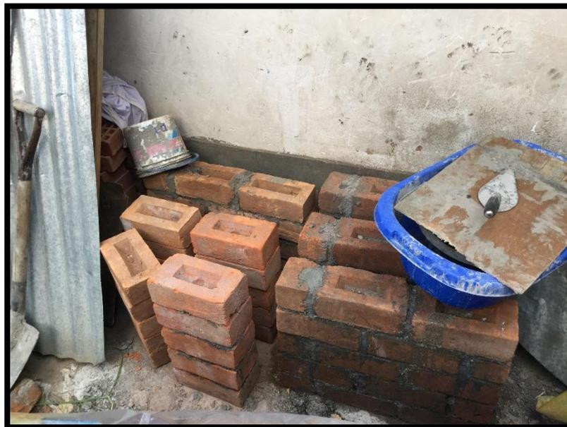
Reposo de las pilas de albañilería durante el periodo de 15 días.
