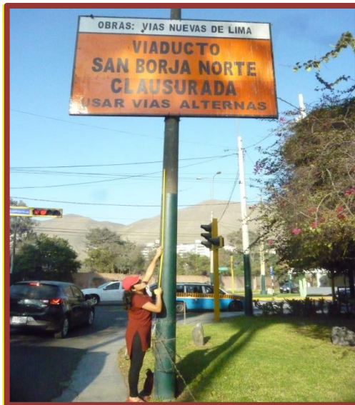
FIGURA 4.2.3.01 POSICION DE LAS SEÑALES EN ZONAS EN TRABAJO
