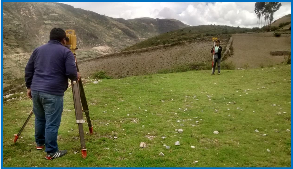
FOTO N.03: SE OBSERVA EL LEVANTAMIENTO TOPOGRAFICO DONDE SE VA DISEÑAR LA PLANTA DE TRATAMIENTO DE LA LAGUNA ANAEROBICA.
