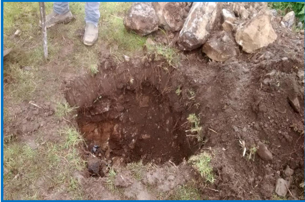
FOTO N. 07: SE OBSERVA LA EXCAVACION DE LA CALICATA A UNA PROFUNDIDAD 1.50 METROS PARA SU RESPECTIVO ESTUDIO DE LAS MUESTRAS.
