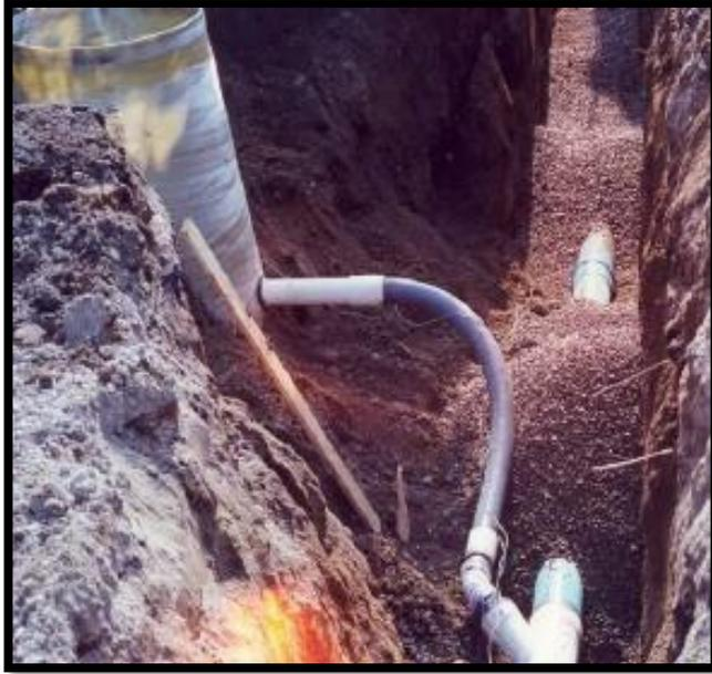
*Figura 5. Sistema de alcantarillado por vacío*
