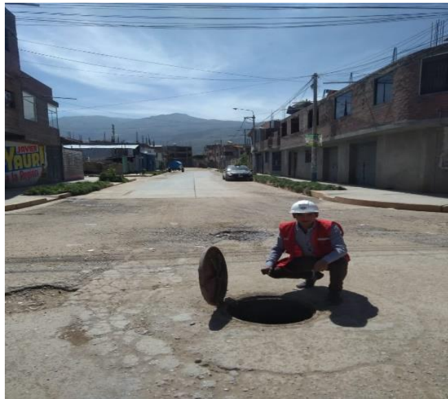
Imagen 50: Inspección de los buzones in situ.
