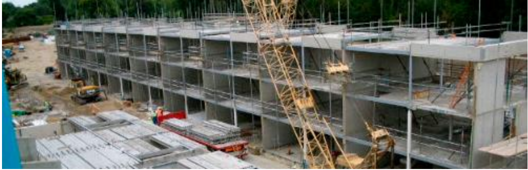
Figura 6. Aulas con sistema postensado.
