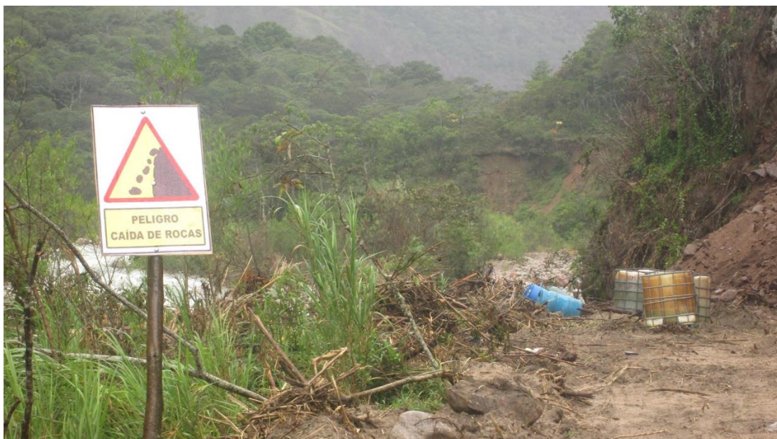
FOTOGRAFIA N° 14: Combustible dejado en una zona de inminente caída de rocas
