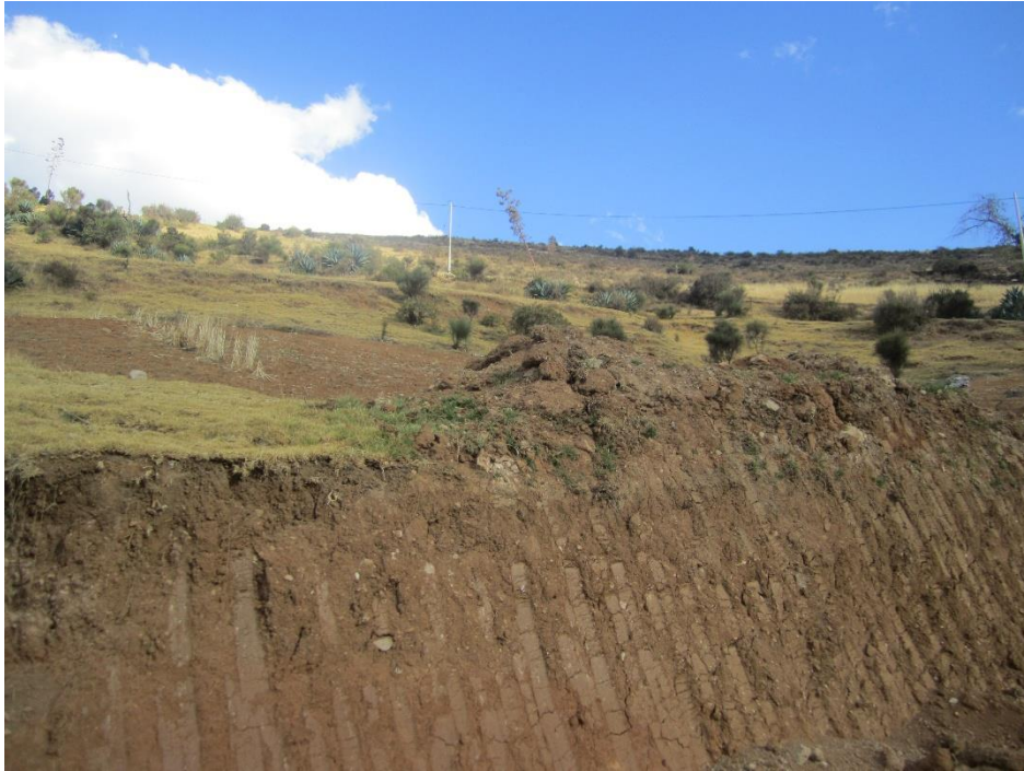
FOTOGRAFIA N° 11: Montículos de desmonte dejados en plena chacra de los pobladores
