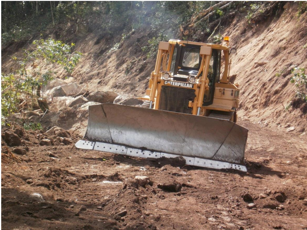
FOTOGRAFIA N° 22: ausencia de carteles informativos de prevención
