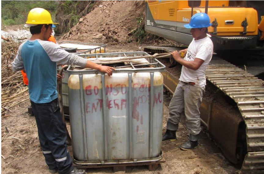
FOTOGRAFIA N° 3: En pleno trabajo de ensanchamiento y mejoramiento de la carretera y trabajadores sin EPP completo
