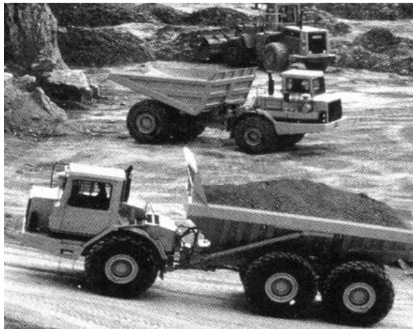
Fig. 6 Dumper y pala excavadora (al fondo)
