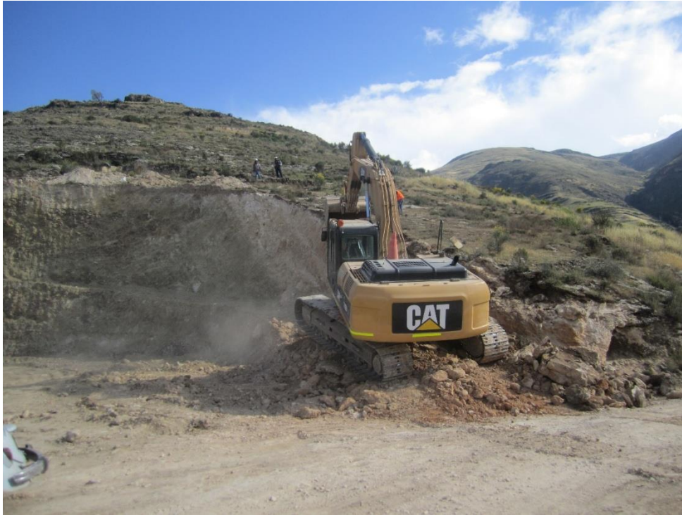
FOTOGRAFIA N° 1: En pleno trabajo de ensanchamiento y mejoramiento de la carretera
