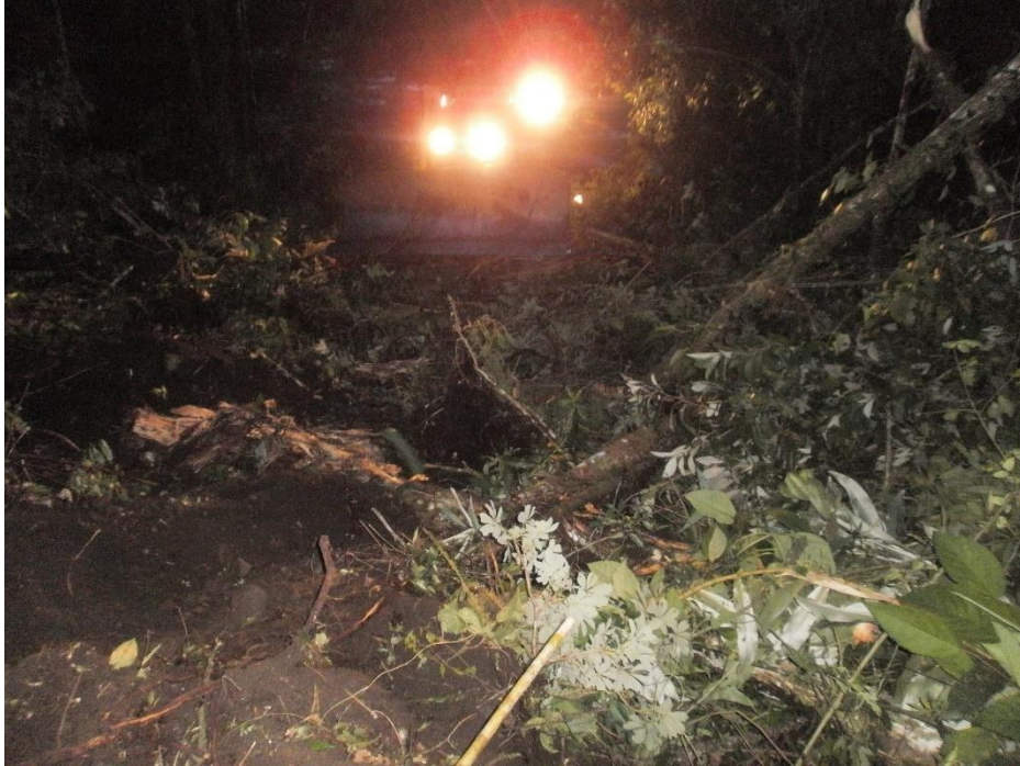
FOTOGRAFIA N° 25: trabajos nocturnos sin las condiciones mínimas de seguridad.
