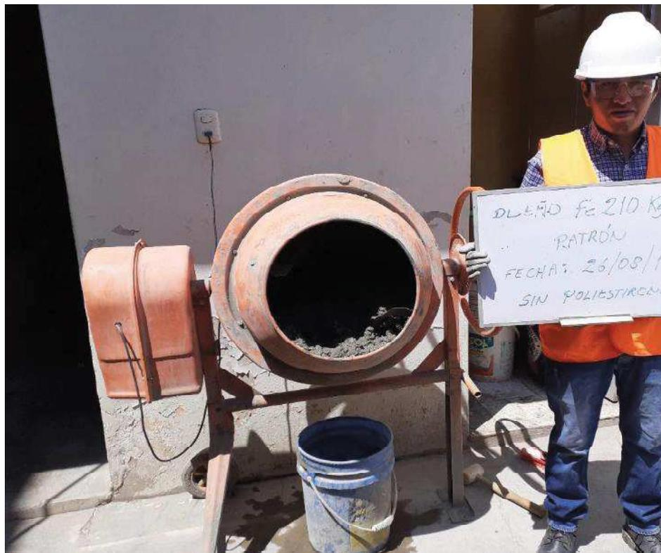
**Foto N° 06:** PREPARACION DEL CONCRETO FC 210, En la Fotografía se observa el mezclado del concreto del grupo de control  $F'c$  210 kg/cm<sup>2</sup>.
