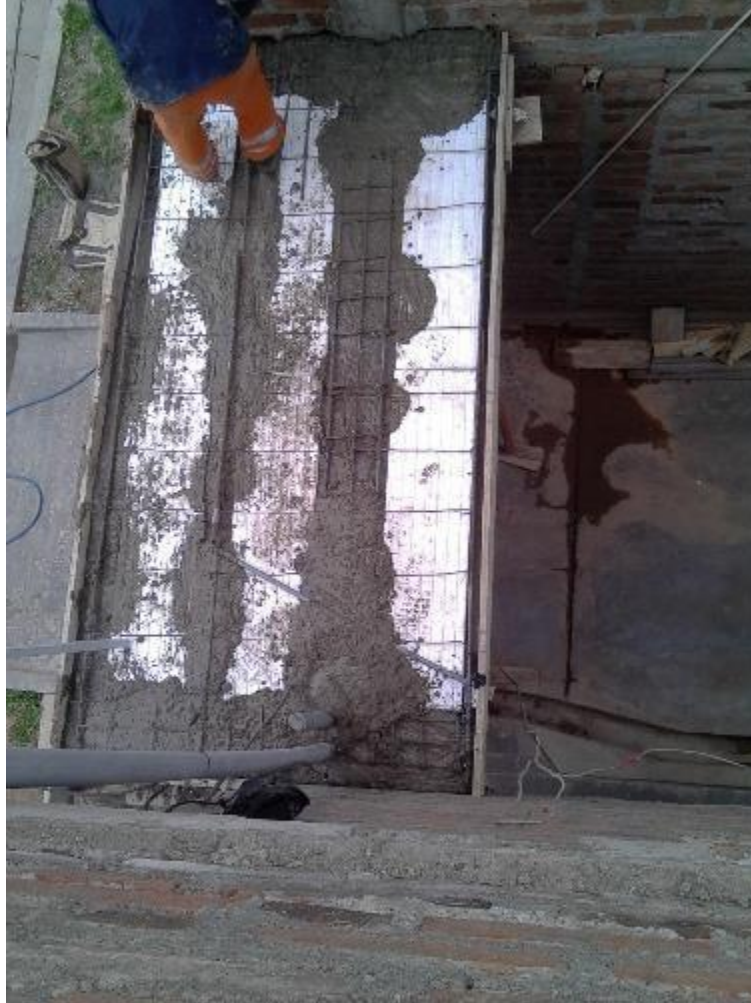
Imagen Nro. 49: Vaciado losa con del casetón con mortero en losa.
