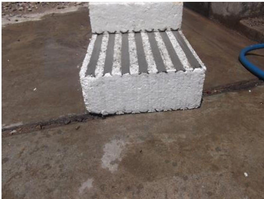
Imagen Nro. 47: Casetón acanalado relleno con mortero
