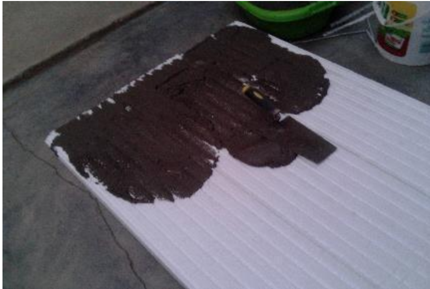
Imagen Nro. 46: Imagen Nro.: Rellenado del casetón – mortero
