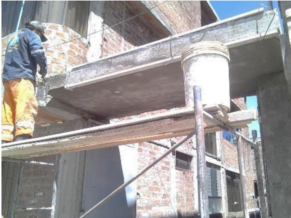
Imagen Nro. 52: Tarrajeo de casetón con mortero en losa - final.
