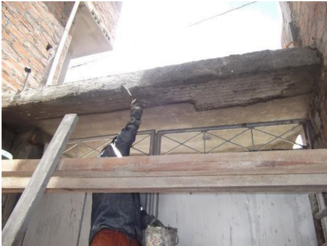
Imagen Nro. 51: Tarrajeo de casetón con mortero en losa.
