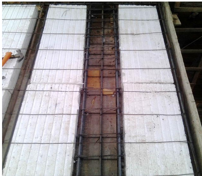
Imagen Nro. 48: Encofrado y aplicación del casetón con mortero en losa.
