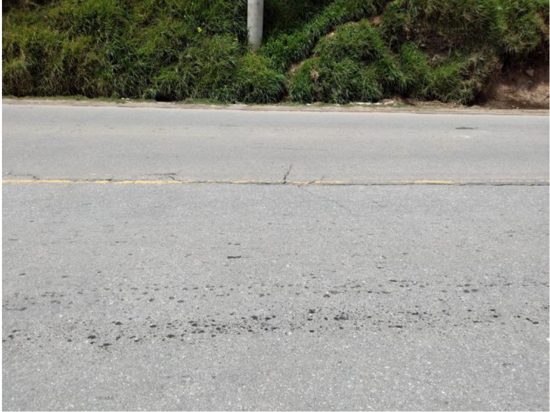
Fotografía 5. Vista del tramo II de estudio, carretera a Tupi hacia Acobamba.
