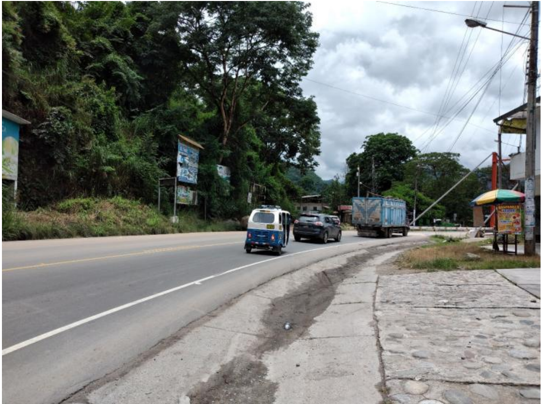
Fotografía 19. Vista de vehículos en el tramo V.
