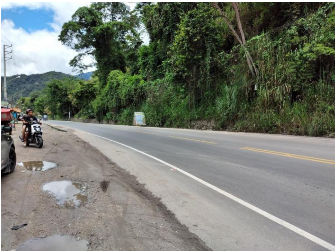
Fotografía 18. Vista del tramo V, desde San Ramón hacia La Merced.
