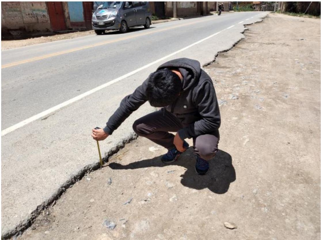
Fotografía 4. Vista de la carpeta asfáltica existente del tramo I.
