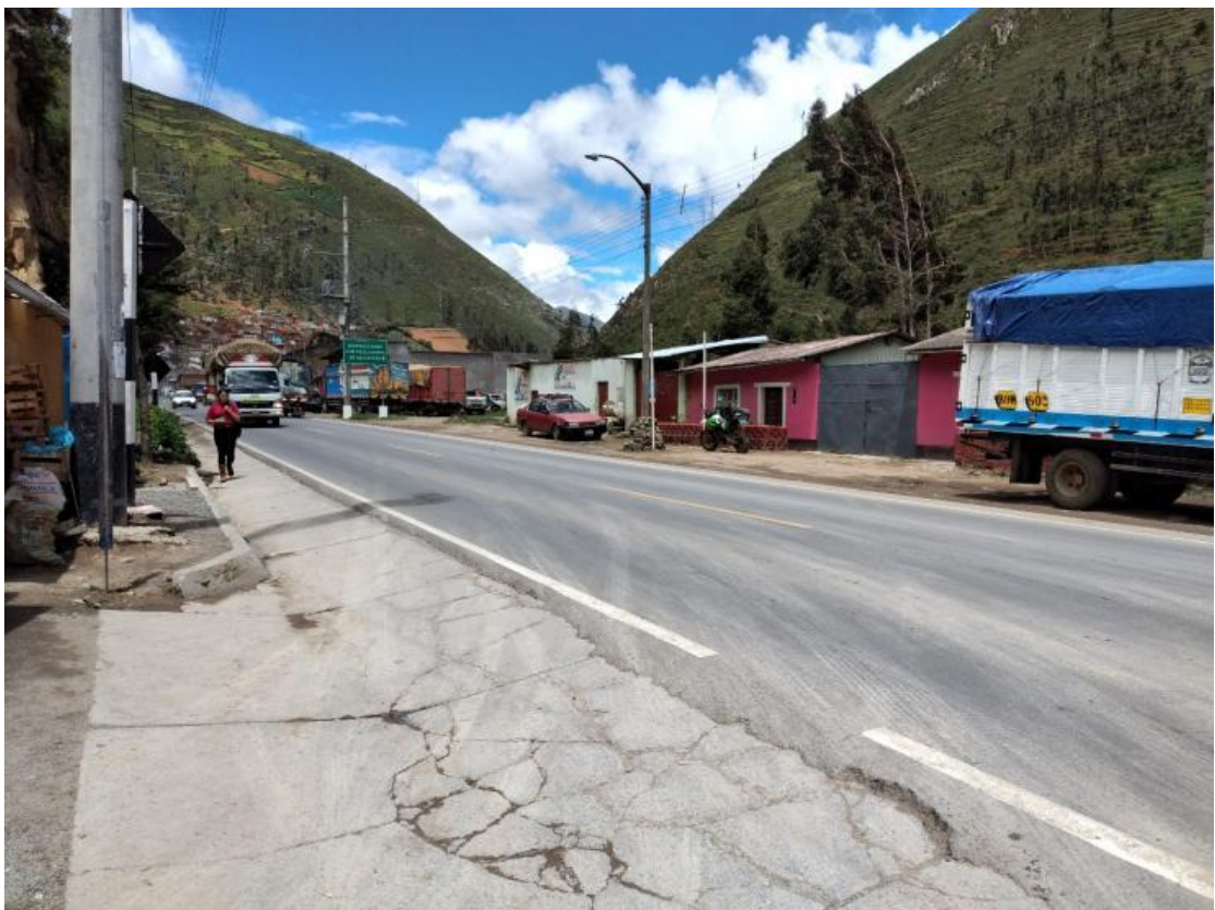
Fotografía 10. Vista del tramo III de estudio, de Acobamba hacia Palca.
