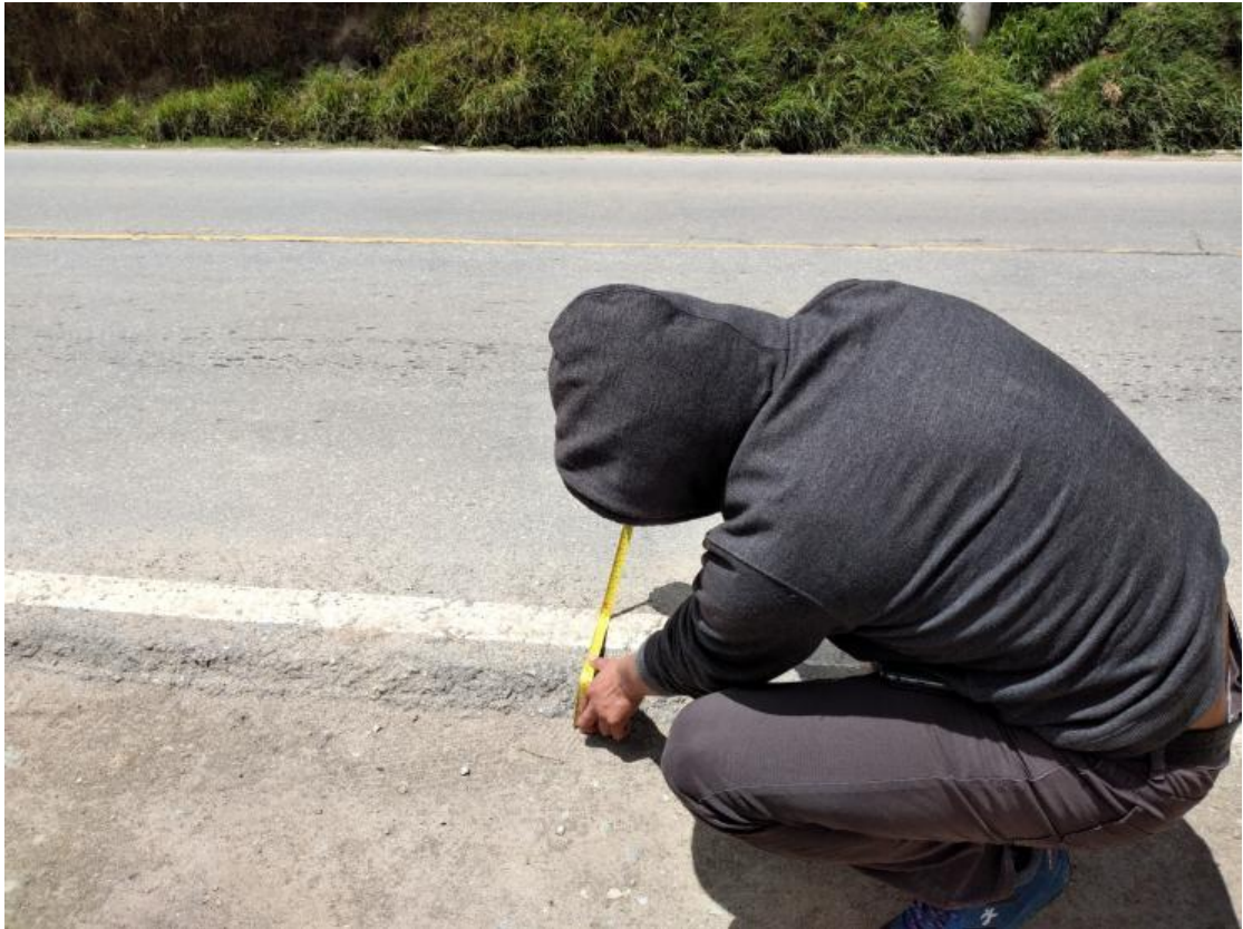
Fotografía 9. Vista de la carpeta asfáltica del tramo II de estudio.
