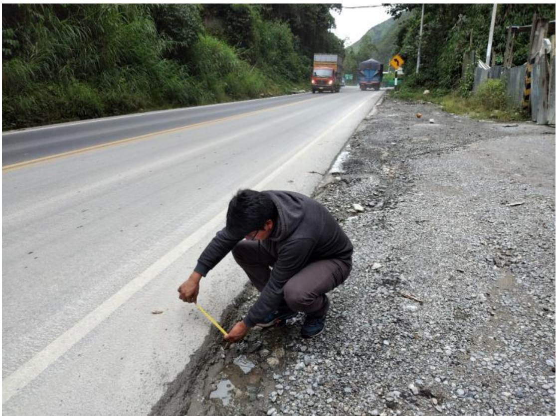
Fotografía 16. Vista de la carpeta asfáltica en el tramo IV de estudio.
