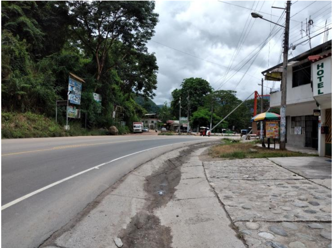
Fotografía 17. Vista del tramo V, desde San Ramón hacia La Merced.
