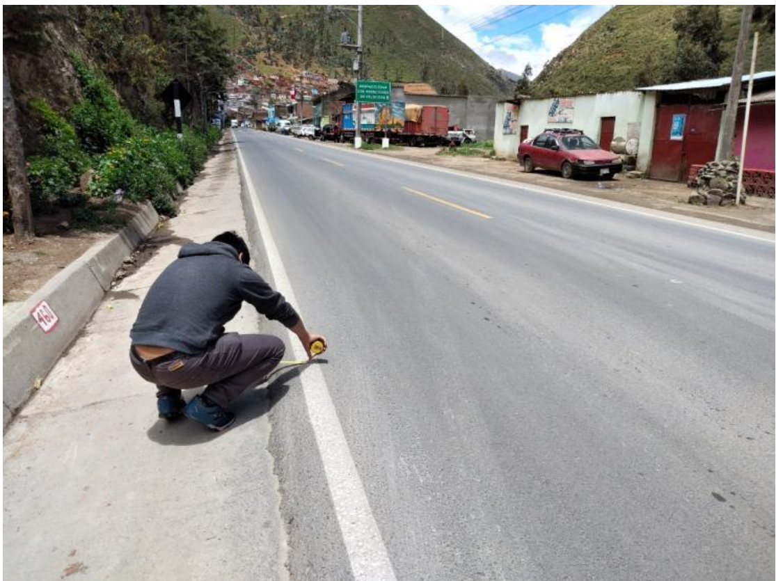
Fotografía 12. Vista de la carpeta asfáltica del tramo III de estudio.
