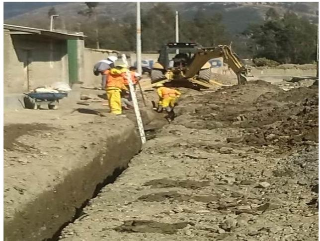
**EXCAVACIÓN DE ZANJAS PARA DRENAJE SUBTERRÁNEO**
