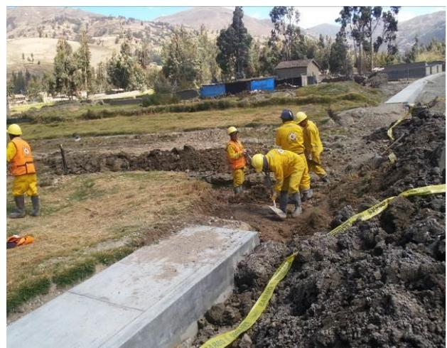
CONTINÚA LOS TRABAJOS DE EXCAVACIÓN DE ZANJAS DEL DRENAJE SUBTERRANEO CALLE ALFONZO UGARTE.
