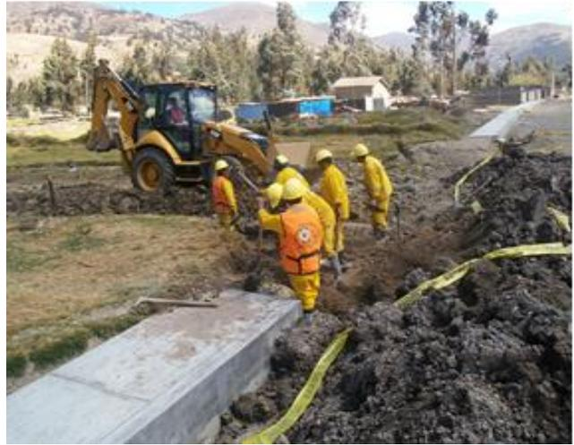
SE INICIA LA PERFORACIÓN DE LAS TUBERÍAS PARA EL DRENAJE SUBTERRANEO
