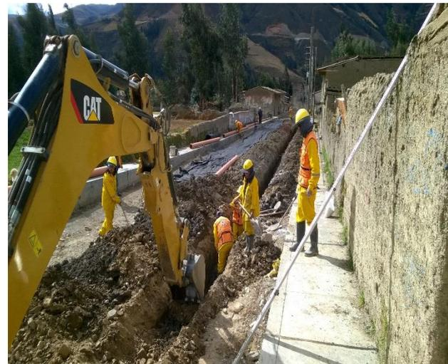
CONTINÚA LOS TRABAJOS DE EXCAVACIÓN DE ZANJAS DEL DRENAJE SUBTERRANEO CALLE SAN MARTIN
