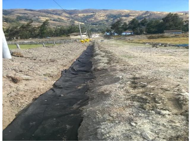
COLOCACIÓN DE GRAVA Y TAPADO DE DRENAJE SUBTERRÁNEO
