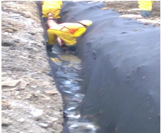
COLOCACIÓN DE TUBERÍA PERFORADA Y GEOTEXTIL EN ZANJA PARA DRENAJE SUBTERRÁNEO
