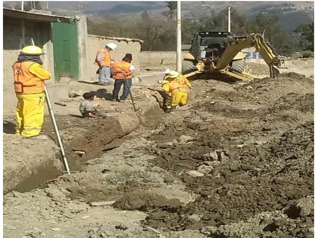
**SE CONTINUA EL CONTROL TOPOGRÁFICO (PENDIENTE) DE LA ZANJA PARA EL DRENAJE SUBTERRANEO.**
